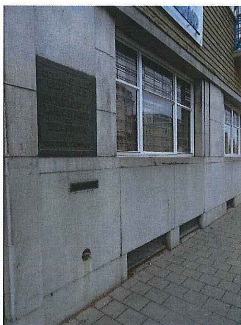
Foto 8: Detail derde travee, gelijkvloerse verdieping.
