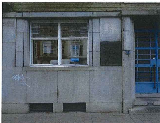
Foto 6: Detail linkertravee, gelijkvloerse verdieping.
