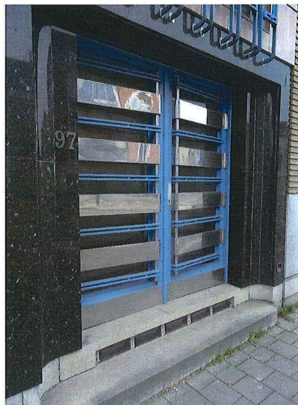
Foto 6: Voorgevel, detail toegangsdeur.
