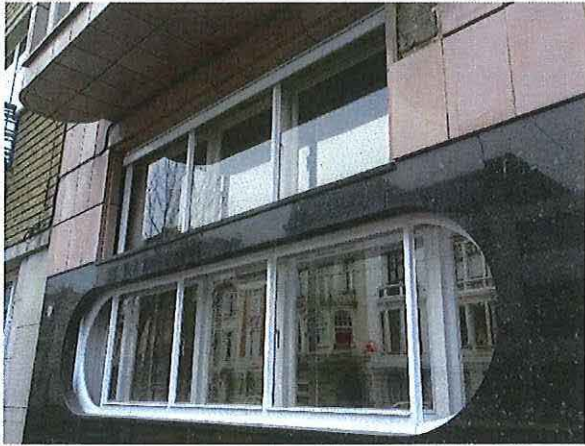
Foto 7: Voorgevel, detail benedenvenster linkertravee.
