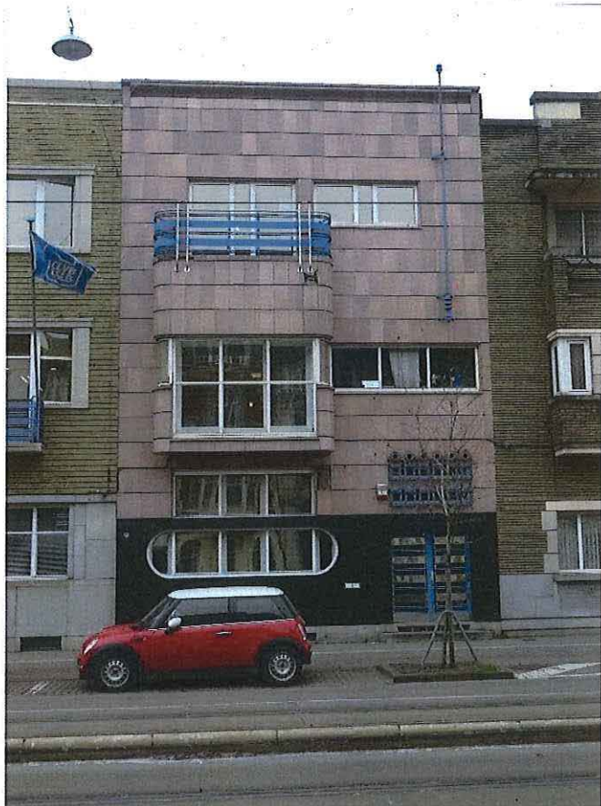
Foto 3: Woning Velghe, voorgevel.
