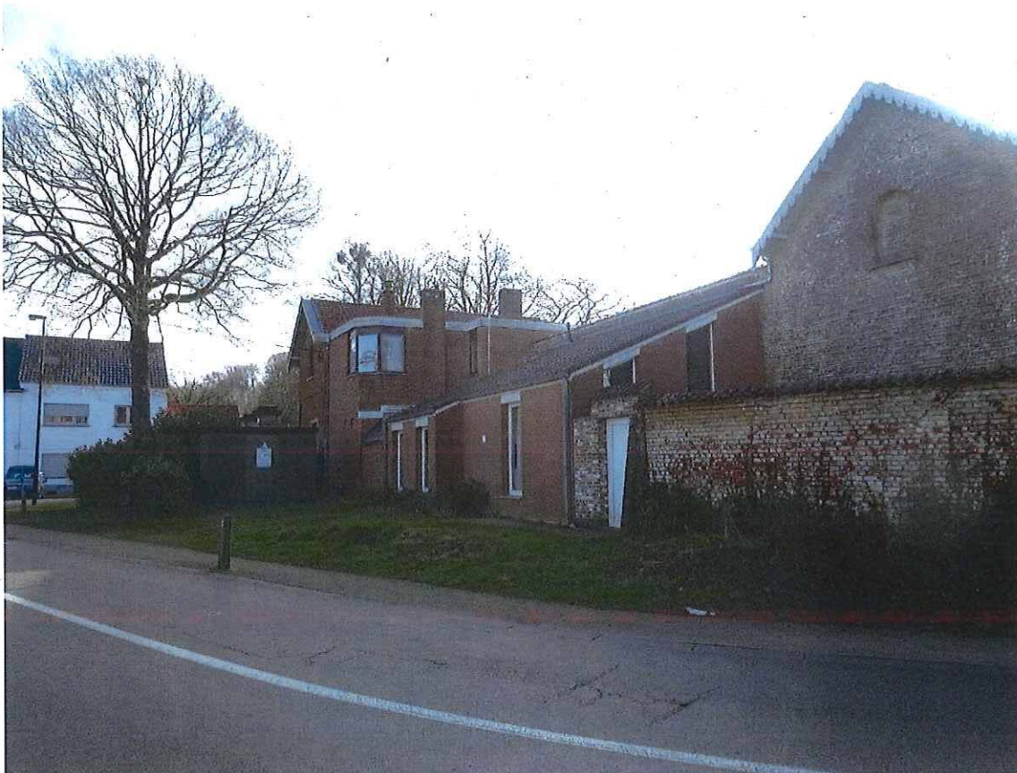
Foto 19: achtergevel van de portierswoning en symmetrisch ingeplant bijgebouw, met recenter ingevulde uitbreidingen. Links de solitaire wintereik bij de hoofdtoegang.
