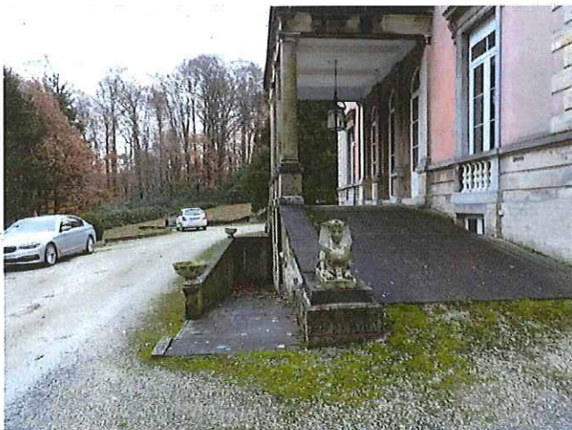
Foto 7: Voorgevel hoofgebouw: detail aflopende stenen balustrade en keldertoegang met decoratieve stenen sfinx
