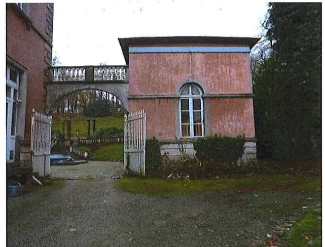
Foto 8: Beeld langs de zijgevel hoofgebouw met toegang tot binnenplaats
