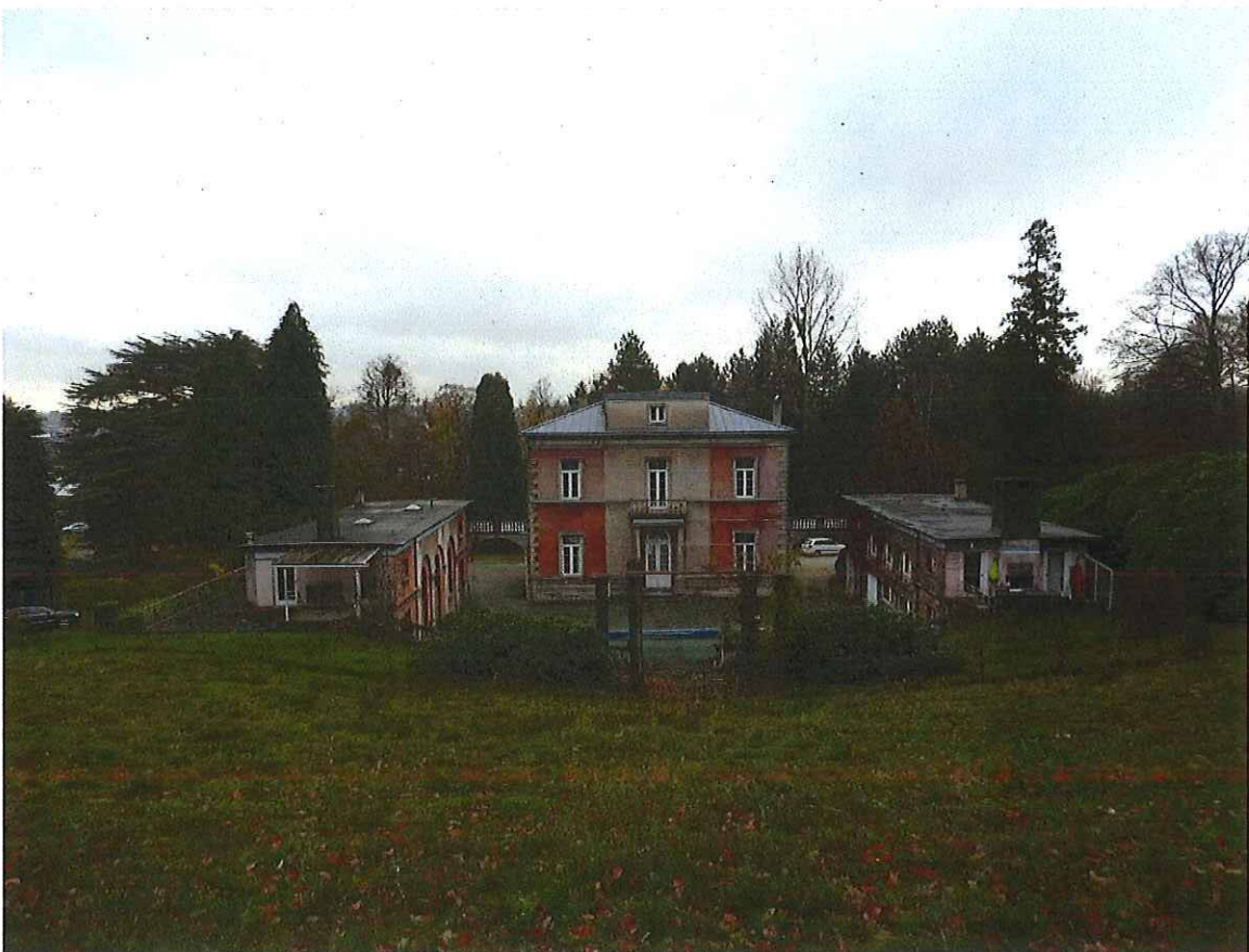
Foto 2: Achtergevels en symmetrische inplanting hoofgebouw met zijgebouwen
