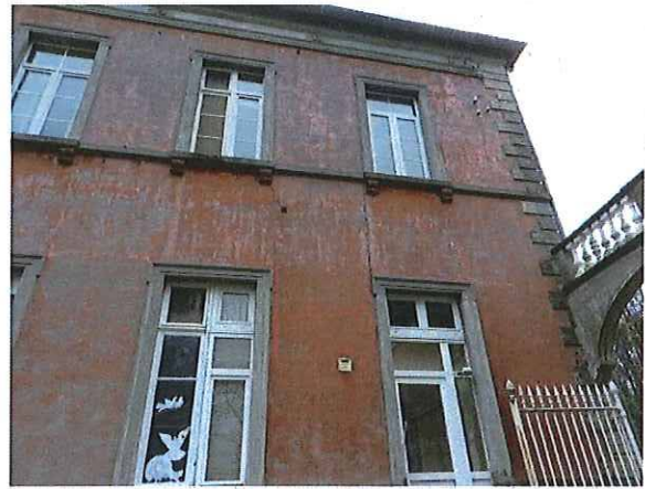
Foto 10: Zijgevel hoofdgebouw: detail
