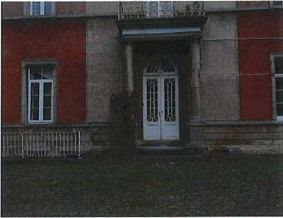
Foto 14: Achtergevel hoofdgebouw: detail achterdeur
