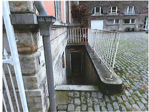
Foto 15: Achtergevel hoofdgebouw: detail toegang kelder
