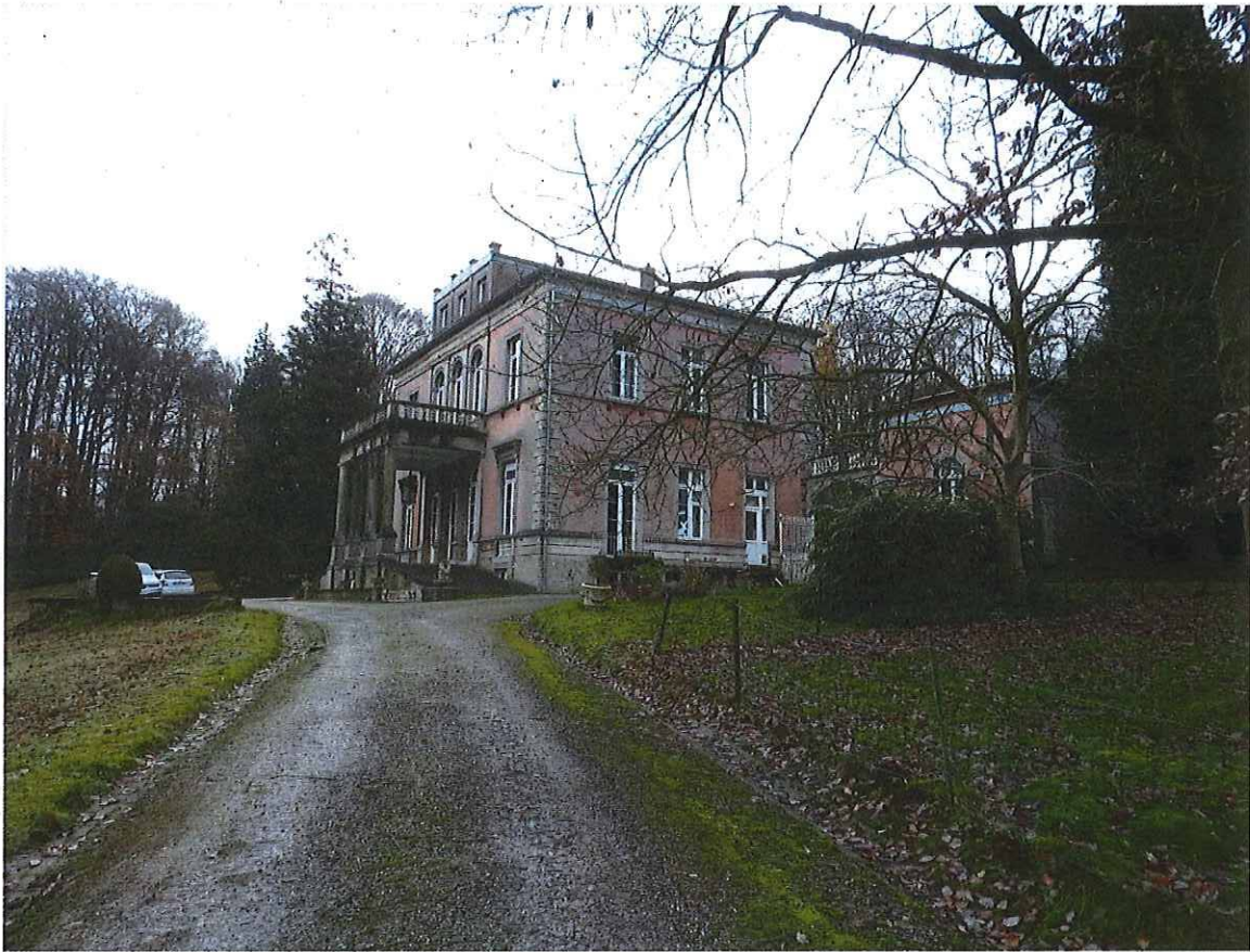
Foto 1: Zicht vanop de oprit op de voor- en zijgevel hoofgebouw
