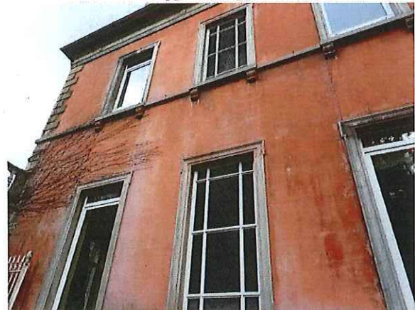
Foto 21: Zijgevel hoofdgebouw: detail
