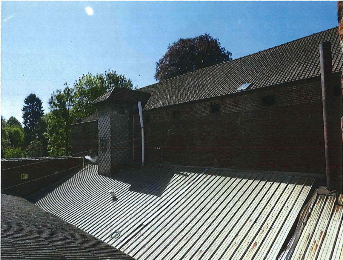
Foto 15: Voormalige binnenplaats met zicht op het oudste biermagazijn met tonnenlift (08/05/2018).
