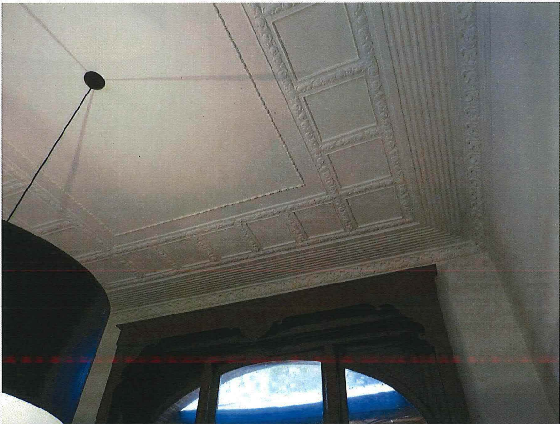
Foto 29: Interieur brouwerswoning, begane grond, stucwerk in de leefruimte ten oosten tegen de binnenkoer (08/05/2018).
