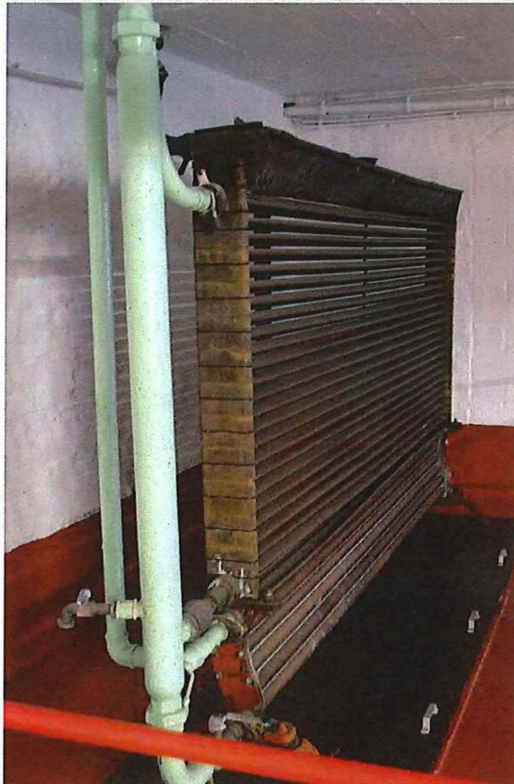
Foto 48: Interieur brouwerij, brouwzaal eerste verdieping, afsijpelingskoeler (05/02/2018).
