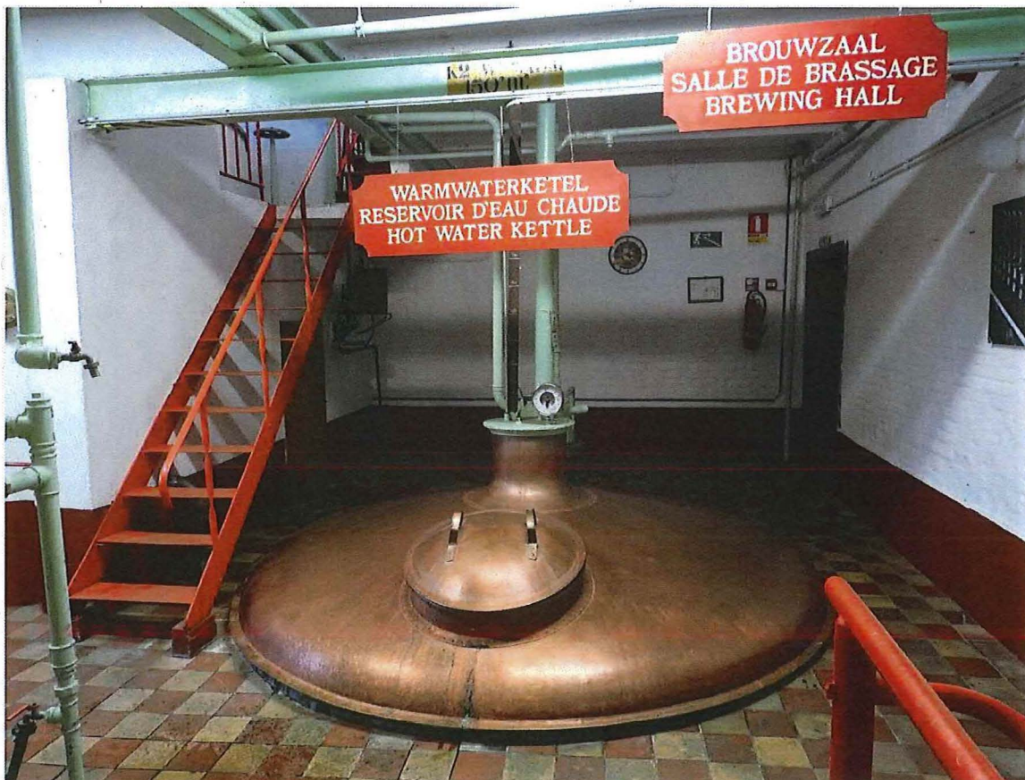
Foto 45: Interieur brouwerij, brouwzaal eerste verdieping, warmwaterketel (05/02/2018).
