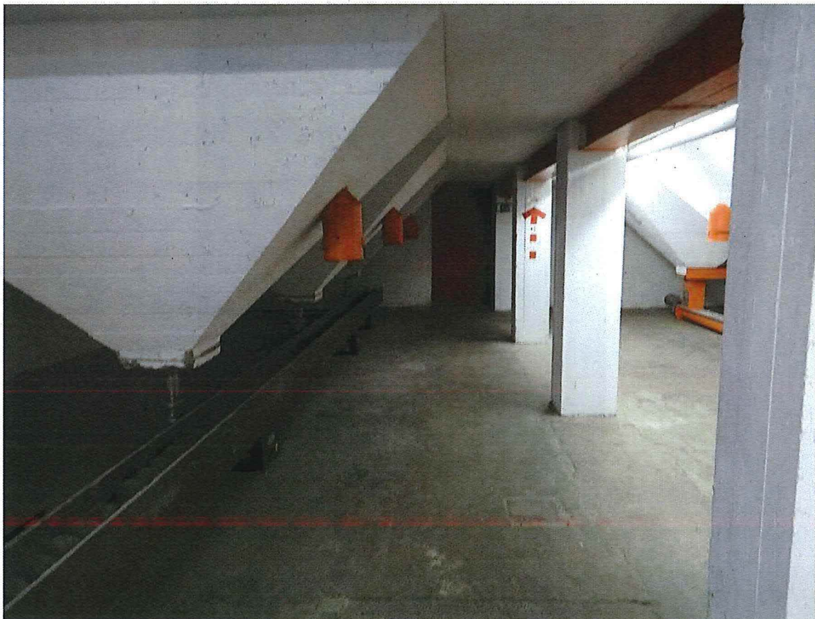
Foto 63: Interieur silogebouw, eerste verdieping met silomonden (05/02/2018).
