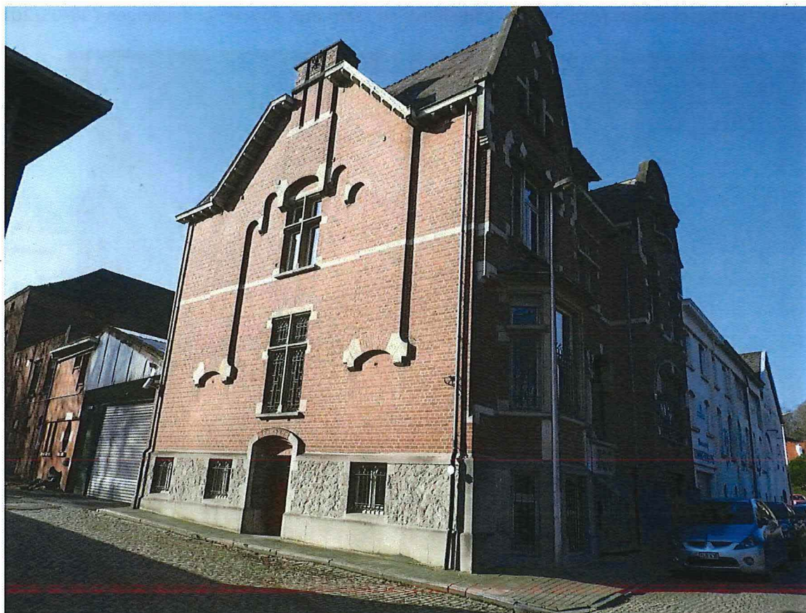
Foto 4: Brouwerswoning, oostgevel langs de buurtweg (05/02/2018).
