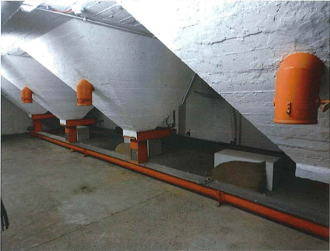
Foto 62: Interieur silogebouw, eerste verdieping met silomonden (05/02/2018).
