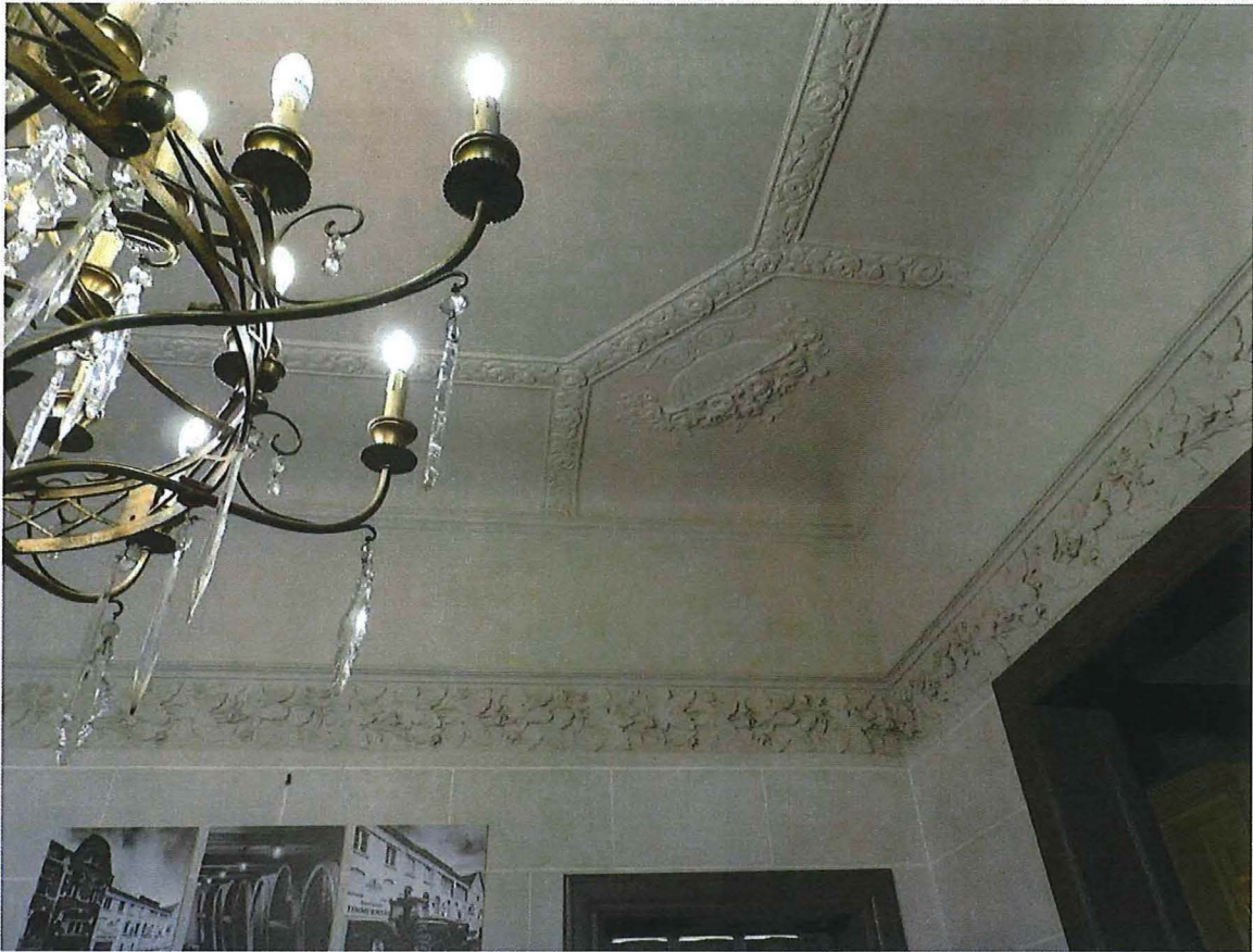
Foto 20: Interieur brouwerswoning, inkomhal met stucwerk (05/02/2018).
