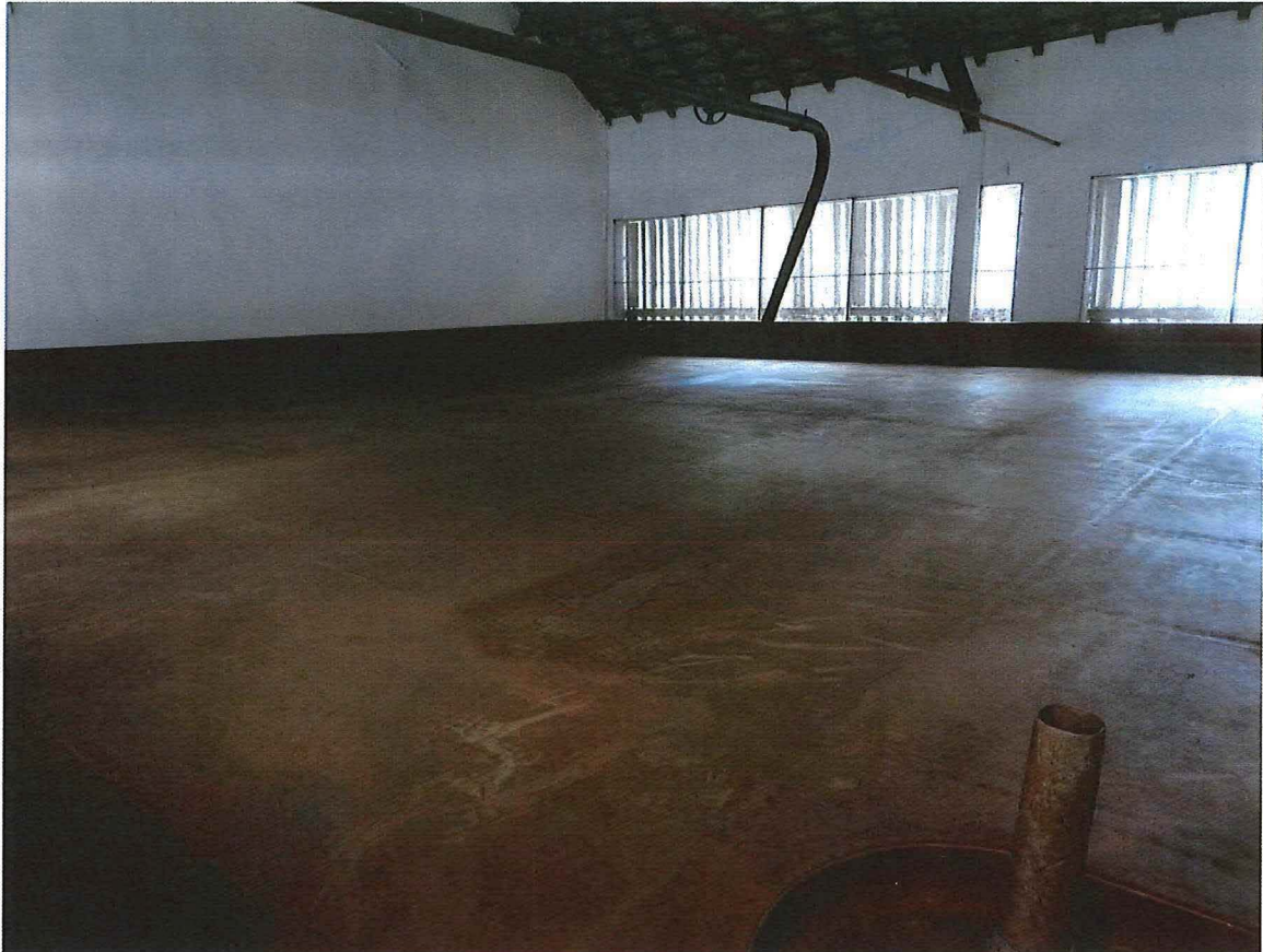
Foto 56: Interieur brouwerij, tweede verdieping, koelschip (05/02/2018).
