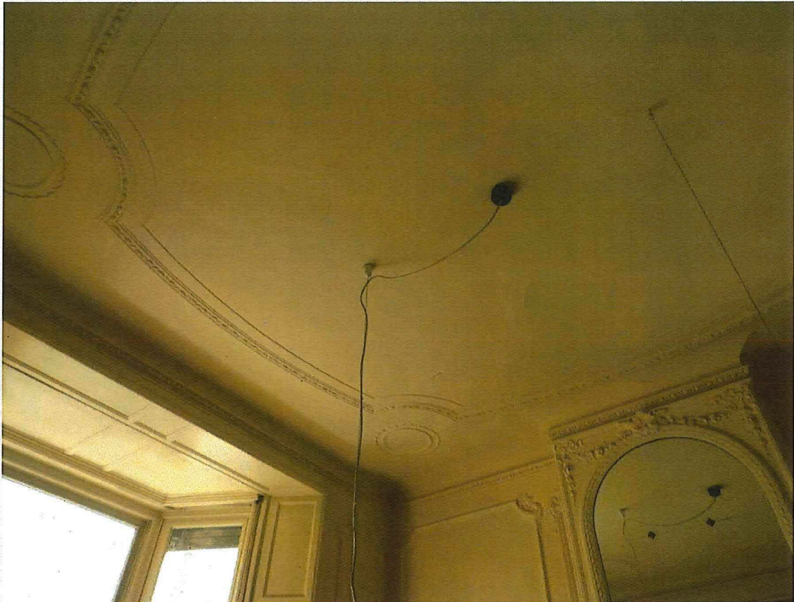
Foto 26: Interieur brouwerswoning, begane grond, stucwerk in de leefruimte ten oosten tegen de straat (08/05/2018).
