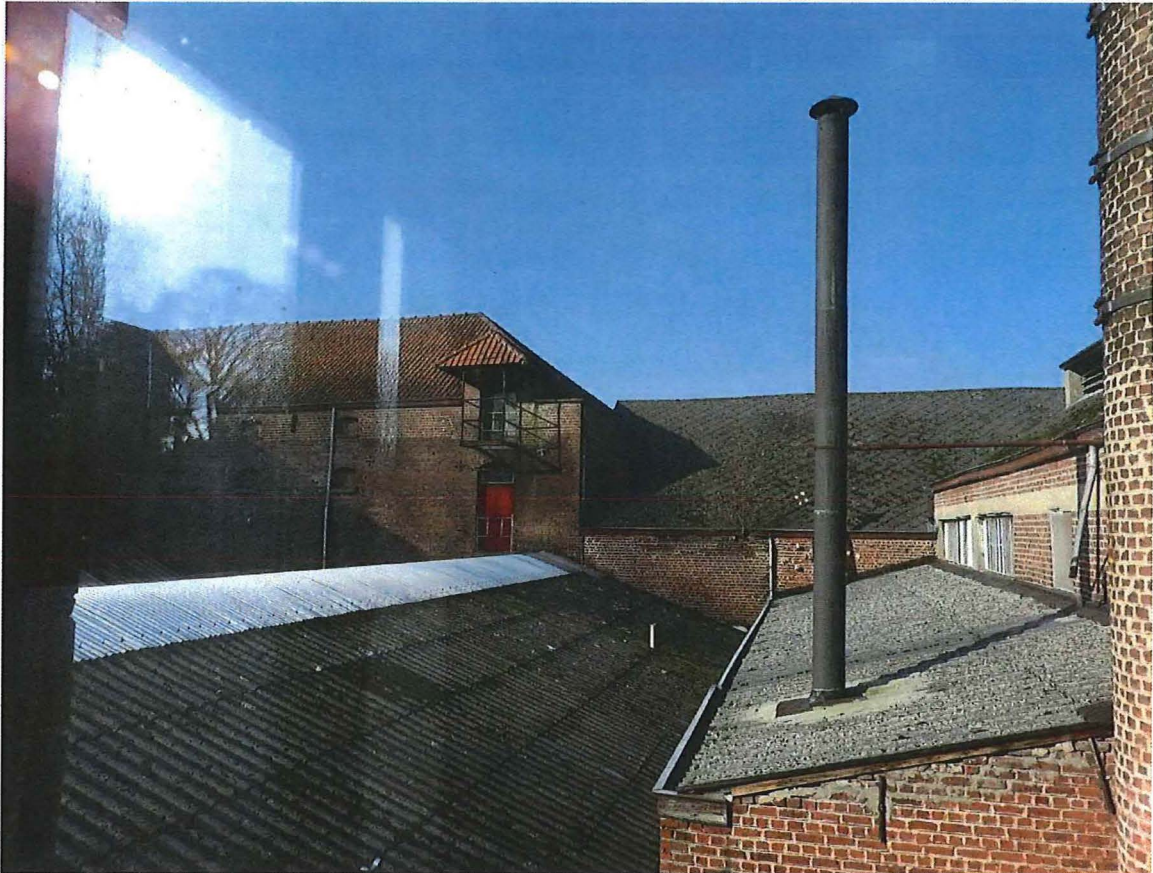
Foto 13: Voormalige binnenplaats, heden overdekt, met zicht op het silogebouw met laadvensters en rechts de achtergevel en bijbouw van de brouwerij (05/02/2018).
