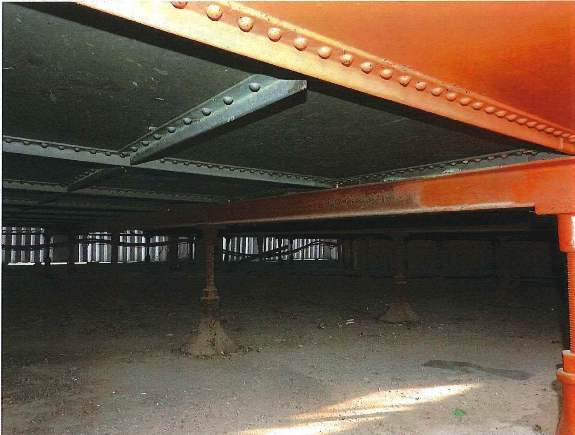
Foto 58: Interieur brouwerij, tweede verdieping, onderzijde koelschip (05/02/2018).
