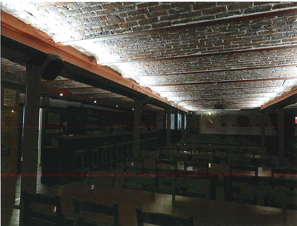
Foto 59: Interieur voormalige mouterij, begane grond met de voormalige kienvloer, vandaag verbruikszaal (05/02/2018).
