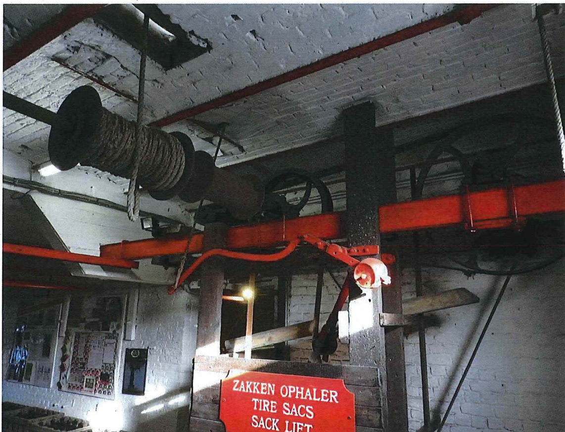
Foto 67: Interieur silogebouw, tweede verdieping, zakkenlift (05/02/2018).
