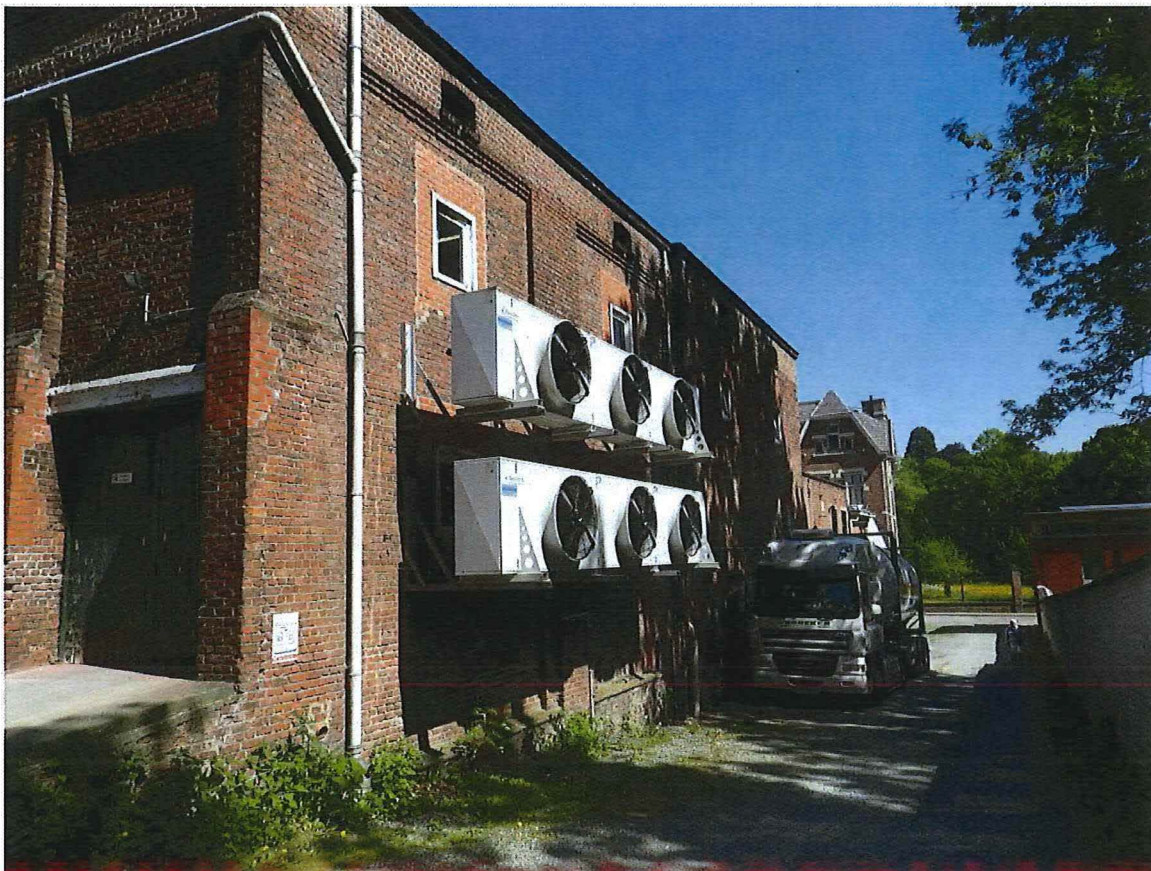
Foto 10: Zijgevel biermagazijnen en bijgebouwen ten oosten langs de buurtweg (08/05/2018).
