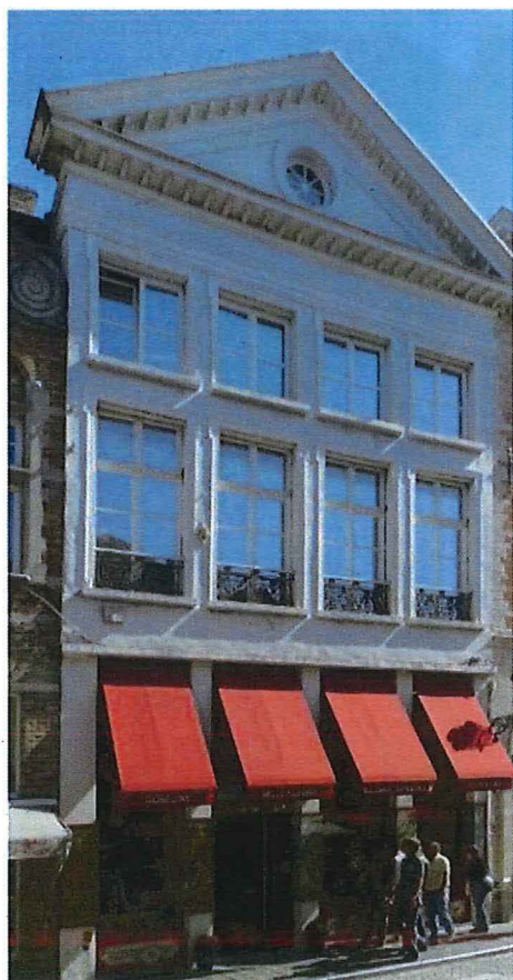
Foto 101: Wollestraat nummer 31 (toestand vóór renovatiewerken 2017)
