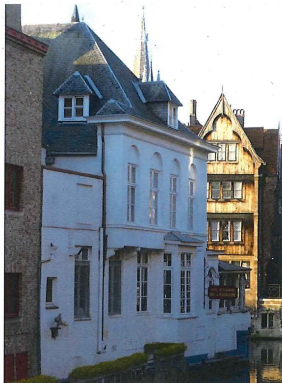
Foto 44: Huidenvettersplein nummer 12, zijgevel
