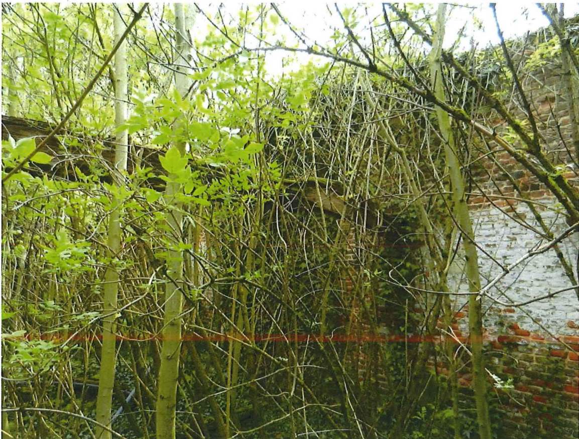
Foto 13: binnenzicht in het poortgebouw, met moerbalk.
