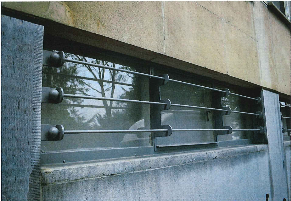
Foto 7: Voorgevel: begane grond, bandraam met stalen traliewerk
