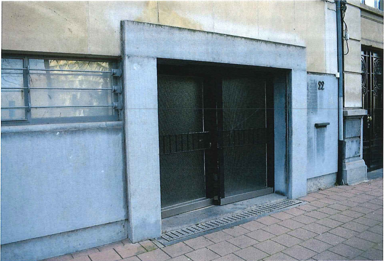
Foto 6: Voorgevel: begane grond, hoofdingang
