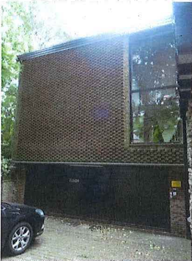
Foto 5: Noordgevel van de oostelijke vleugel.
