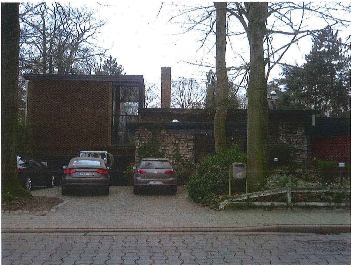
Foto 4: Voorgevel, zicht vanuit het noorden.
