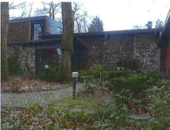
Foto 10: Voortuinaanleg met wandelpad in betontegels.
