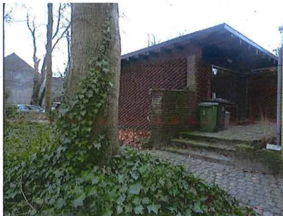
Foto 15: Volume ten noordwesten, diensttoegang in de westzijde.
