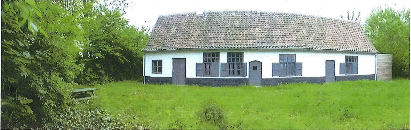
Figuur 1: na verplaatsing, gevel zijde Kerkakkerstraat
