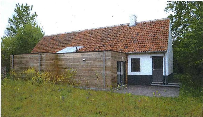
Figuur 2: na verplaatsing, gevel zijde spoorweg
