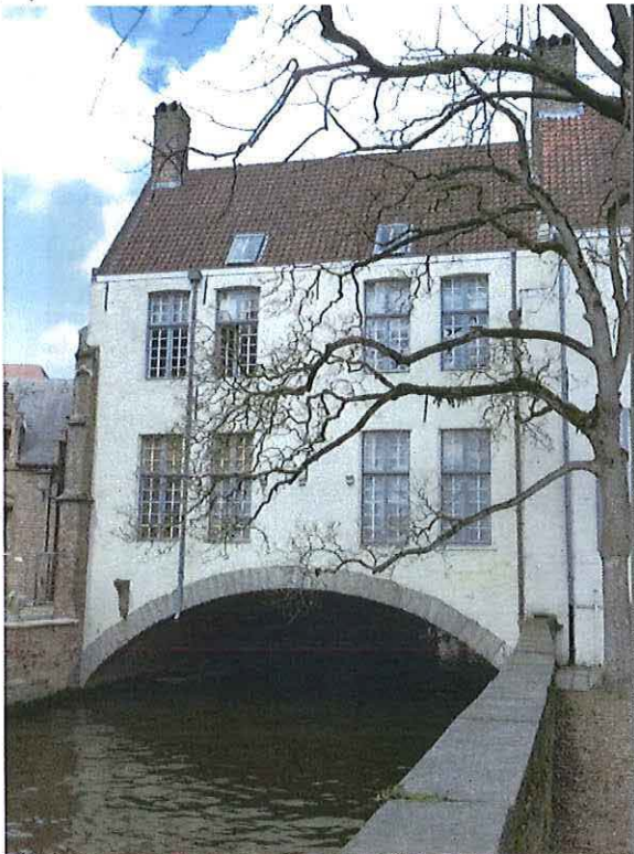
Foto 30: Dijver nummer 16, achtergevel van het Arentshuis en de Bakkersrei.
