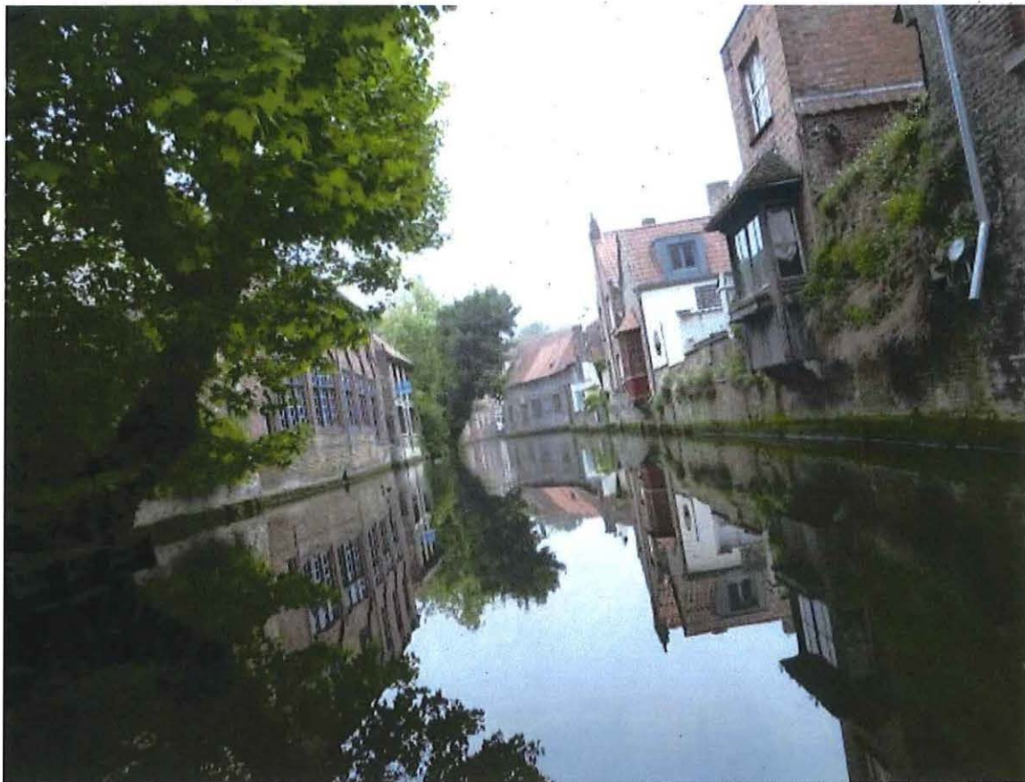
Foto 189: Zicht op de Bakkersrei naar de achterhuizen en de kaaimuren horend bij de panden in de Kastanjeboomstraat.
