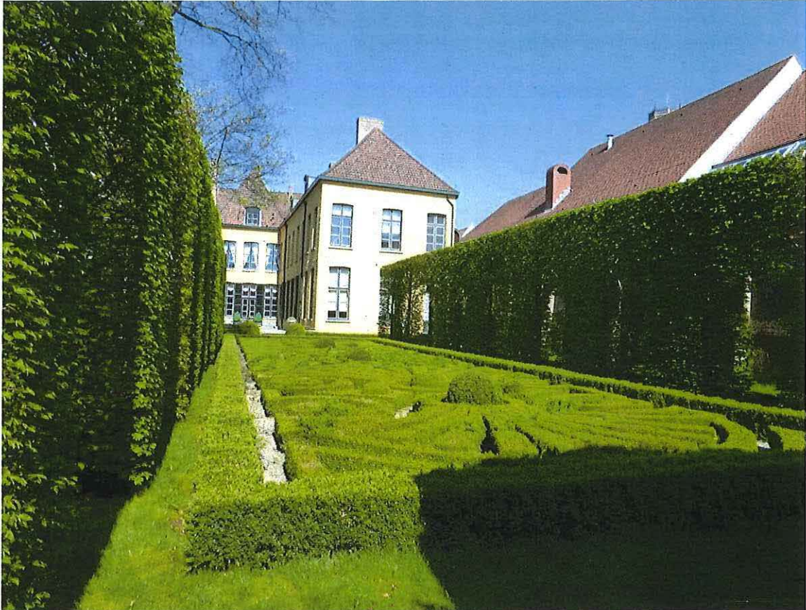
Foto 86: Oude Burg nummer 21-23, zicht op de tuin en de achtergevels van het hoofdvolume aan de Oude Burg.
