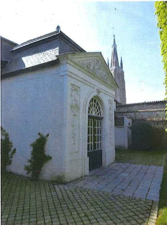
Foto 90: Oude Brug nummer 21-23, zicht op de tuingevel van de orangerie.
