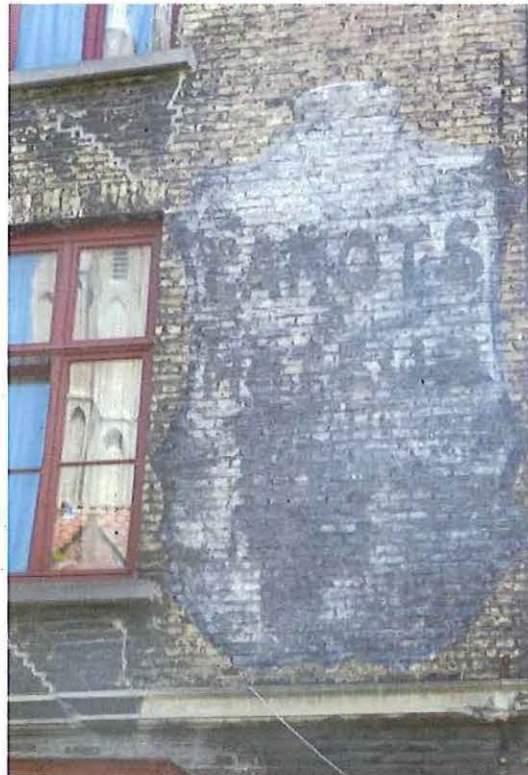
Foto 204: Katelijnestraat nummer 1, zijgevel met reclame-opschrift.
