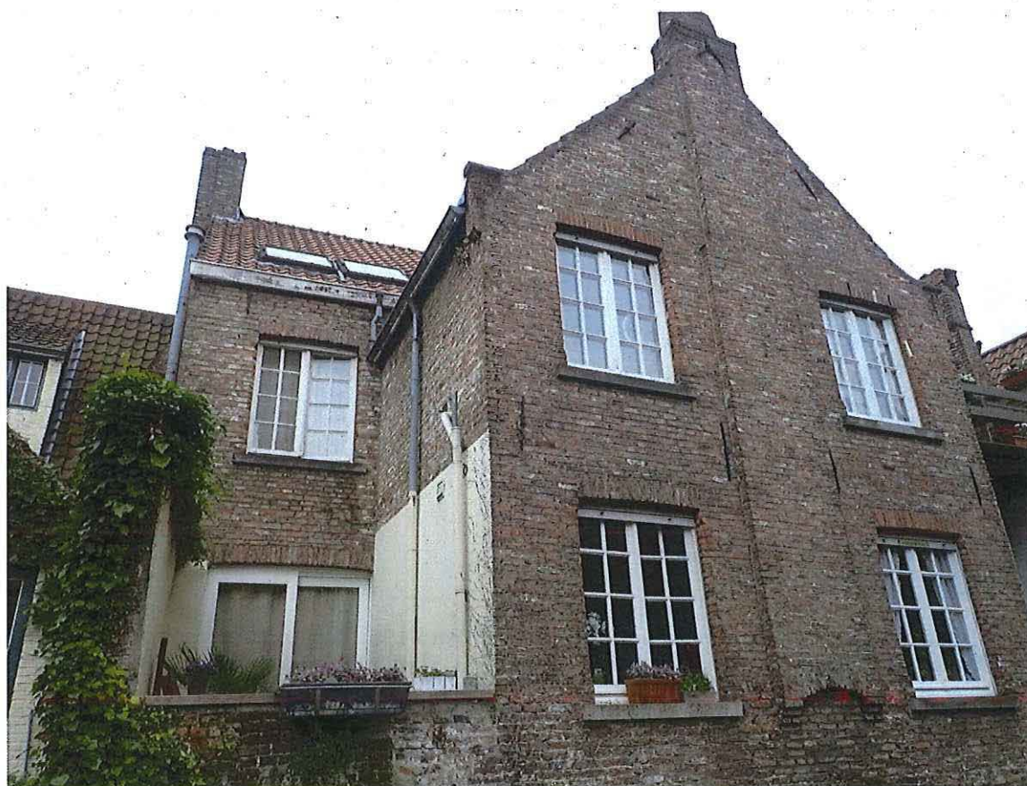
Foto 198: Kastanjeboomstraat nummer 22, kaaimuren en volume aan water.
