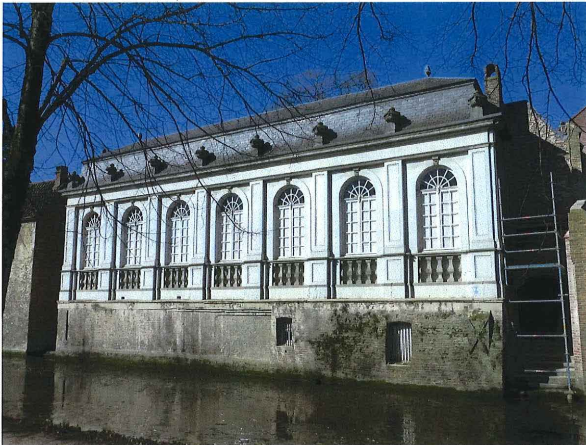
Foto 84: Oude Burg nummer 21-23, Orangerie, achtergevel kant Dijver.
