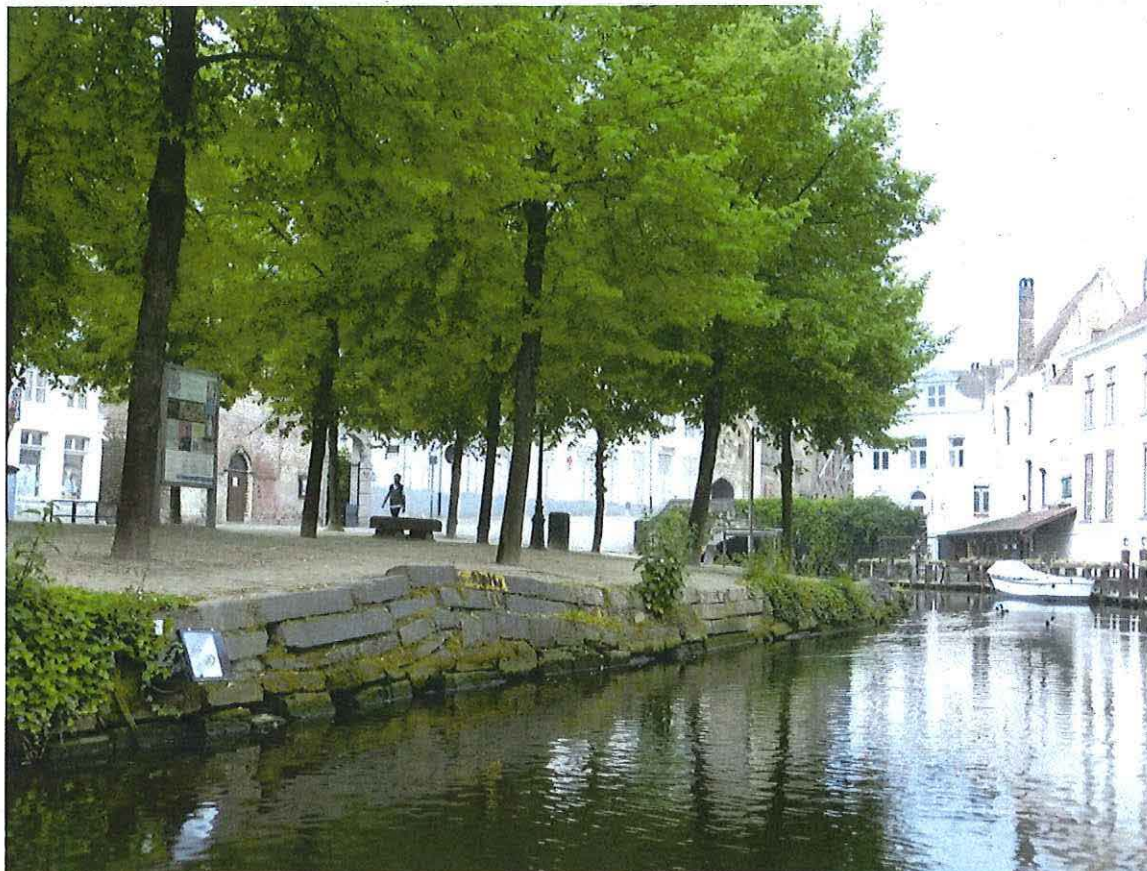
Foto 5: Dijver, oeveraanleg van blauwe hardsteen en Doornikse steen.
