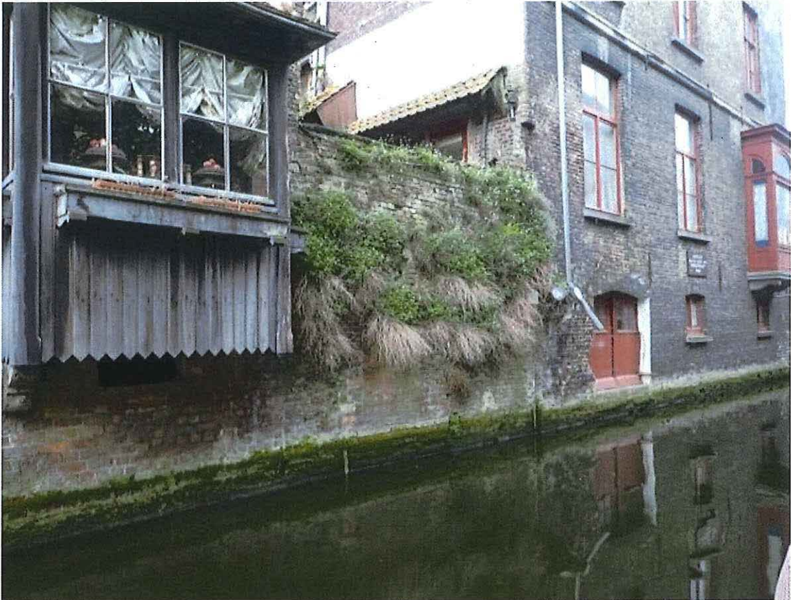
Foto 201: Kastanjeboomstraat nummer 34, volume aan Bakkersrei en kaaimuren.
