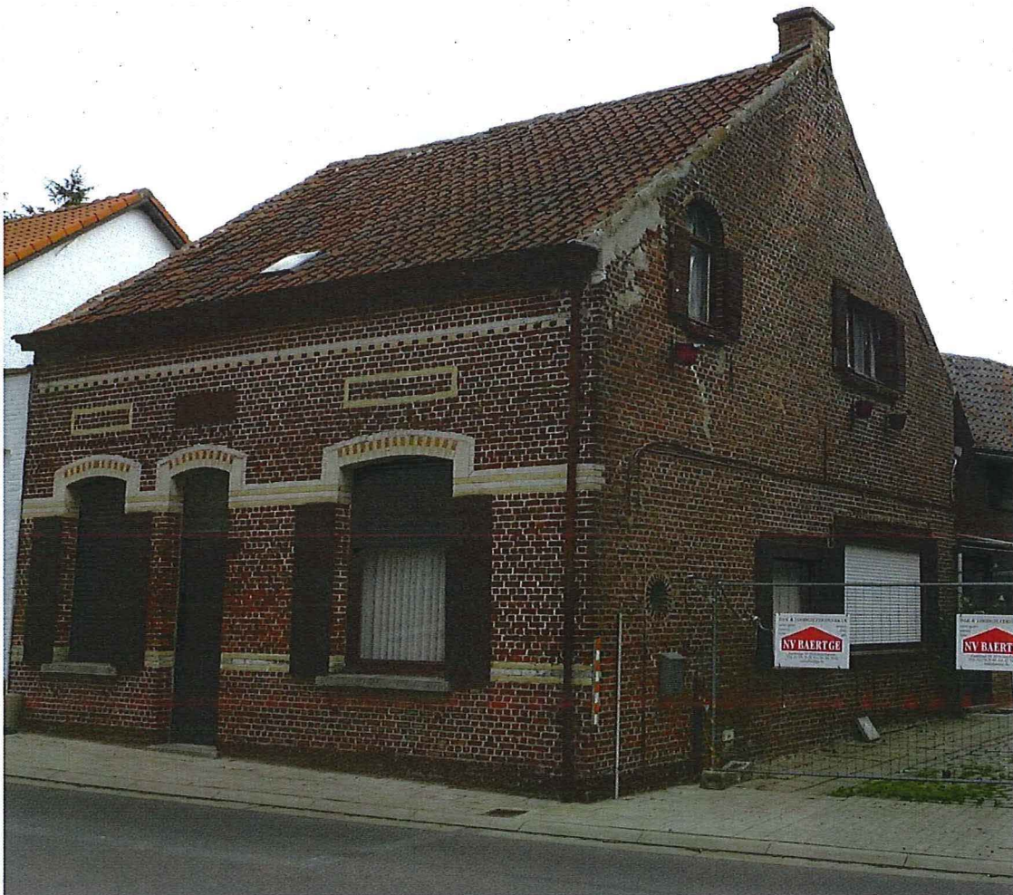
Foto 7: Woonhuis. Zuidelijke zijgevel met rond venstertje op de begane grond en rondbogig in de puntgeveltop.
