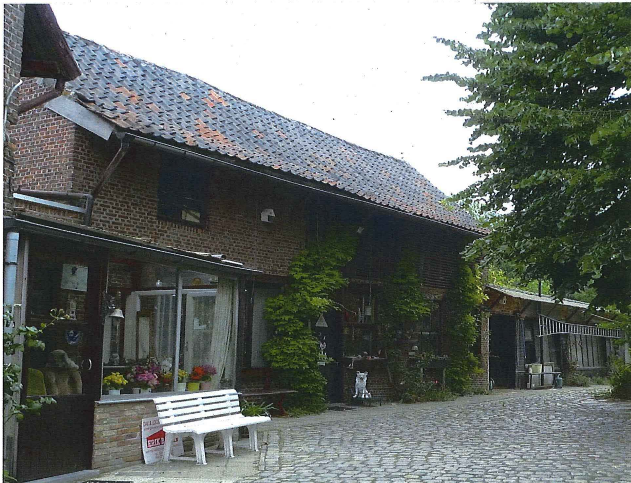
Foto 12: Voormalige blokstal. Voorgevel. Toestand 10 juli 2017.
