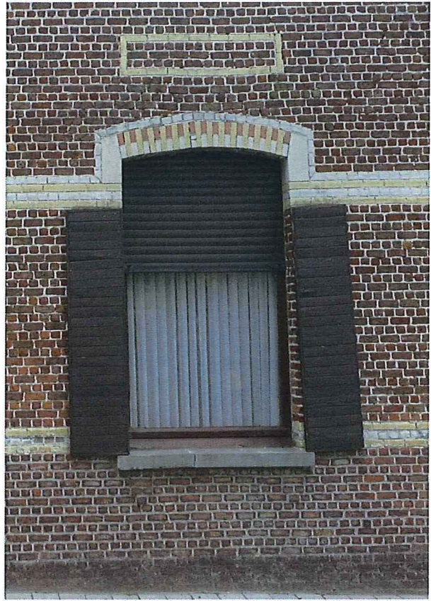
Foto 6: Woonhuis. Detail rechtervenster en decoratief metselwerk.
