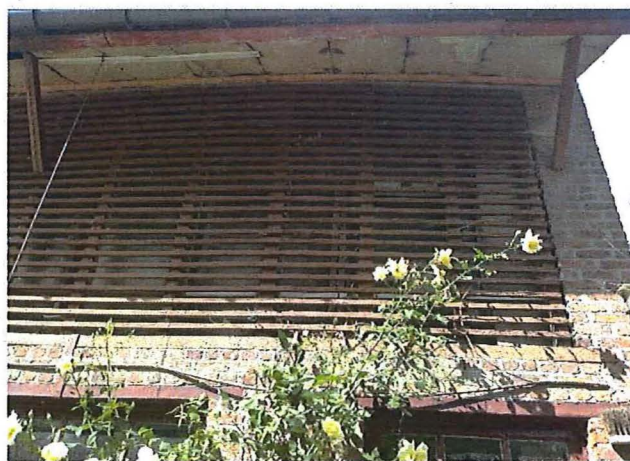
Foto 20: Voormalige blokstal. Zolderverdieping. Kenmerkende droogconstructie in stijl- en regelwerk.
