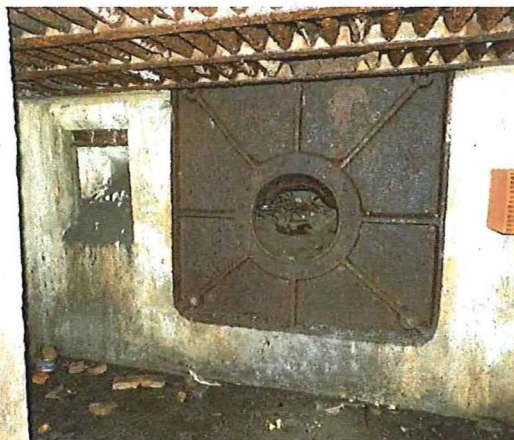
Foto 14: Zicht op de observatieopening en de plaataffuit voor het kanon aan de noordoostelijke voorzijde van de bunker. Foto genomen op 14 juni 2017.
