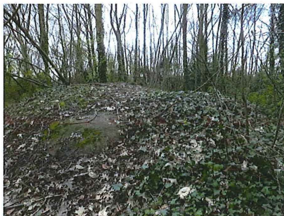
Foto 12: Het dak van de geschutsbunker. Foto genomen op 22 maart 2017.
