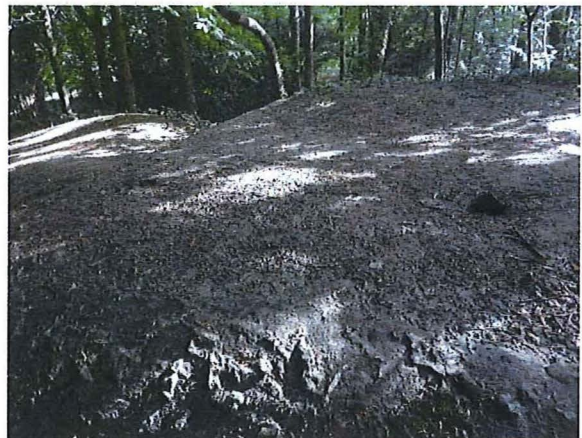
Foto 4: De twee openingen doorheen het dak aan de (zuidwestelijke) voorzijde van de bunker. Foto genomen op 14 juni 2017.
