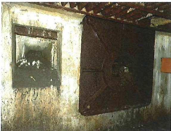
Foto 13: Zicht op de observatieopening en de plaataffuit voor het kanon aan de noordoostelijke voorzijde van de bunker. Foto genomen op 14 juni 2017.
