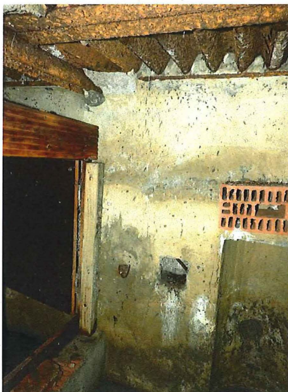
Foto 10: De kachelnis met ernaast een kleine vierkante opening ter hoogte van de binnentoeegang. Foto genomen op 14 juni 2017.
