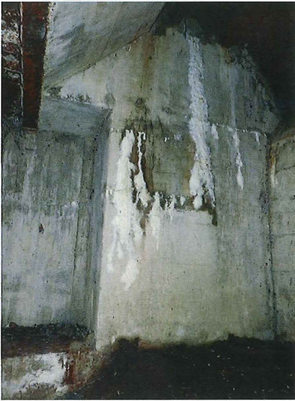
Foto 4: Het plafond van de observatiebunker verhoogt ter hoogte van de koepel. Foto genomen op 13 oktober 2017.
