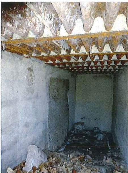
Foto 8: Zicht in de gang van de bunker. De toegang tot de bunkerruimte is dichtgemaakt. Foto genomen op 17 maart 2017.
