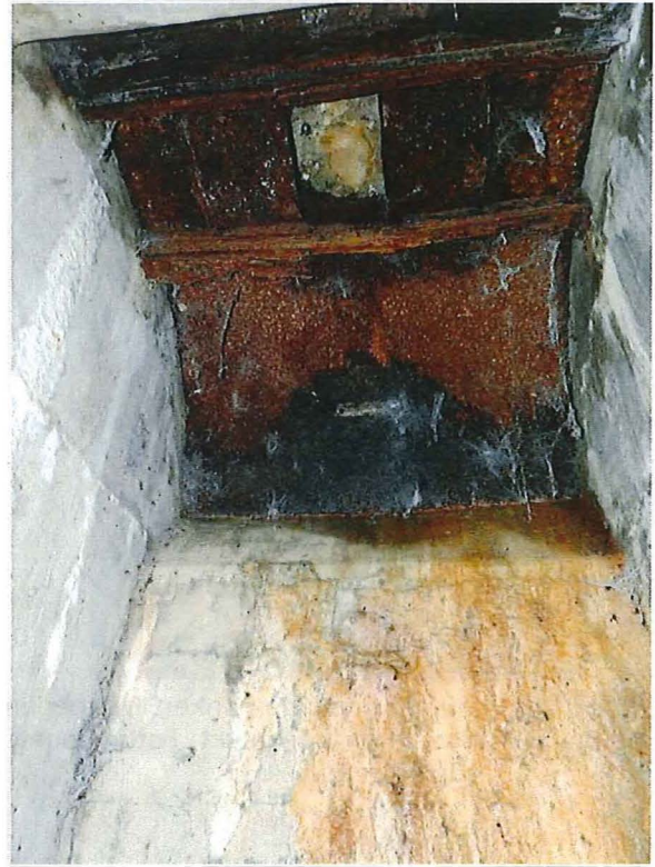
Foto 5: De pantserplaat met ronde opening voor observatie, die volgestort is. IJzeren platen konden van binnenuit voor deze ronde opening geschoven worden. Foto genomen op 13 oktober 2017.
