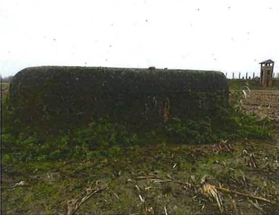
Foto 2: De mitrailleurspost vanuit noordoostelijke hoek. Foto genomen op 5 december 2017.
