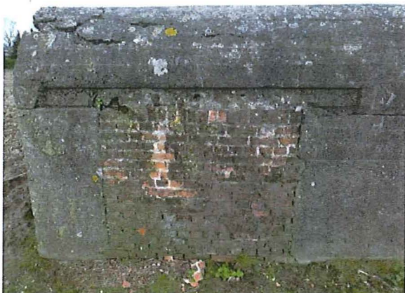
Foto 4: Detail van de dichtgemaakte toegang aan zuidwestelijke zijde. Foto genomen op 22 maart 2017.
