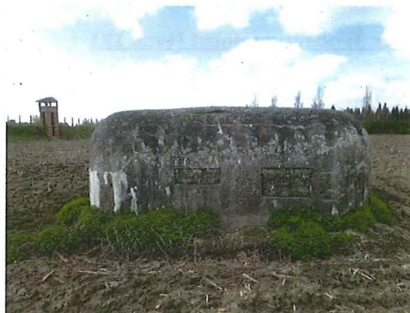
Foto 5: De dichtgemaakte muuropeningen aan zuidoostelijke zijde. Foto genomen op 22 maart 2017.
