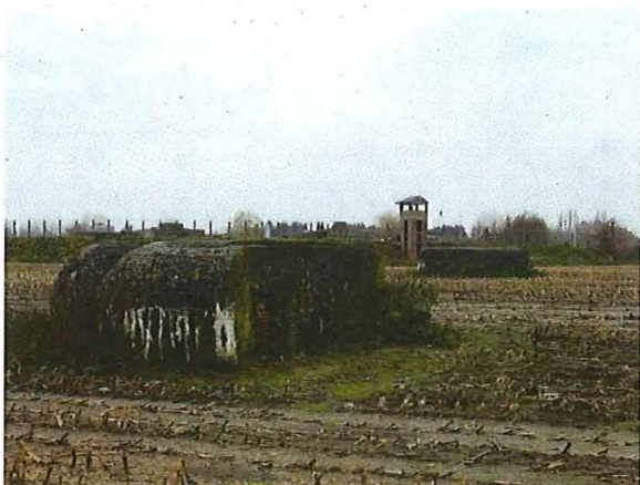
Foto 6: Het manschappenonderkomen vanuit oostelijke hoek. Foto genomen op 5 december 2017.
