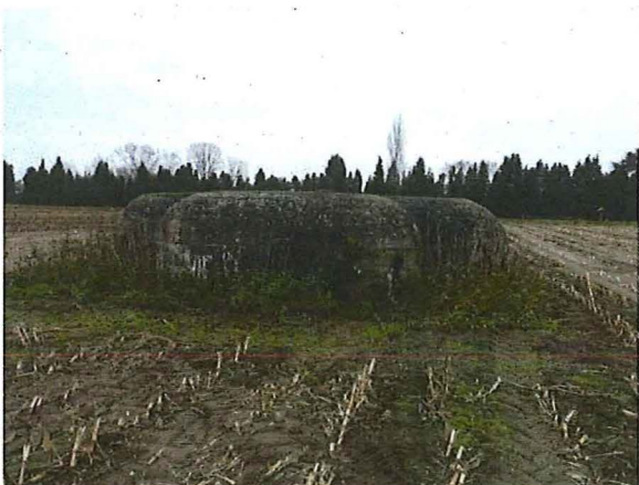
Foto 8: Het manschappenonderkomen aan zuidelijke zijde. Foto genomen op 5 december 2017.
