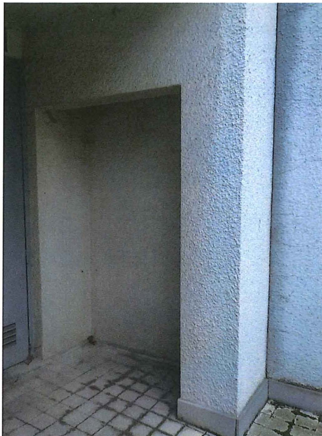
Foto 6 : nis, rechts van deur, begane grond.
