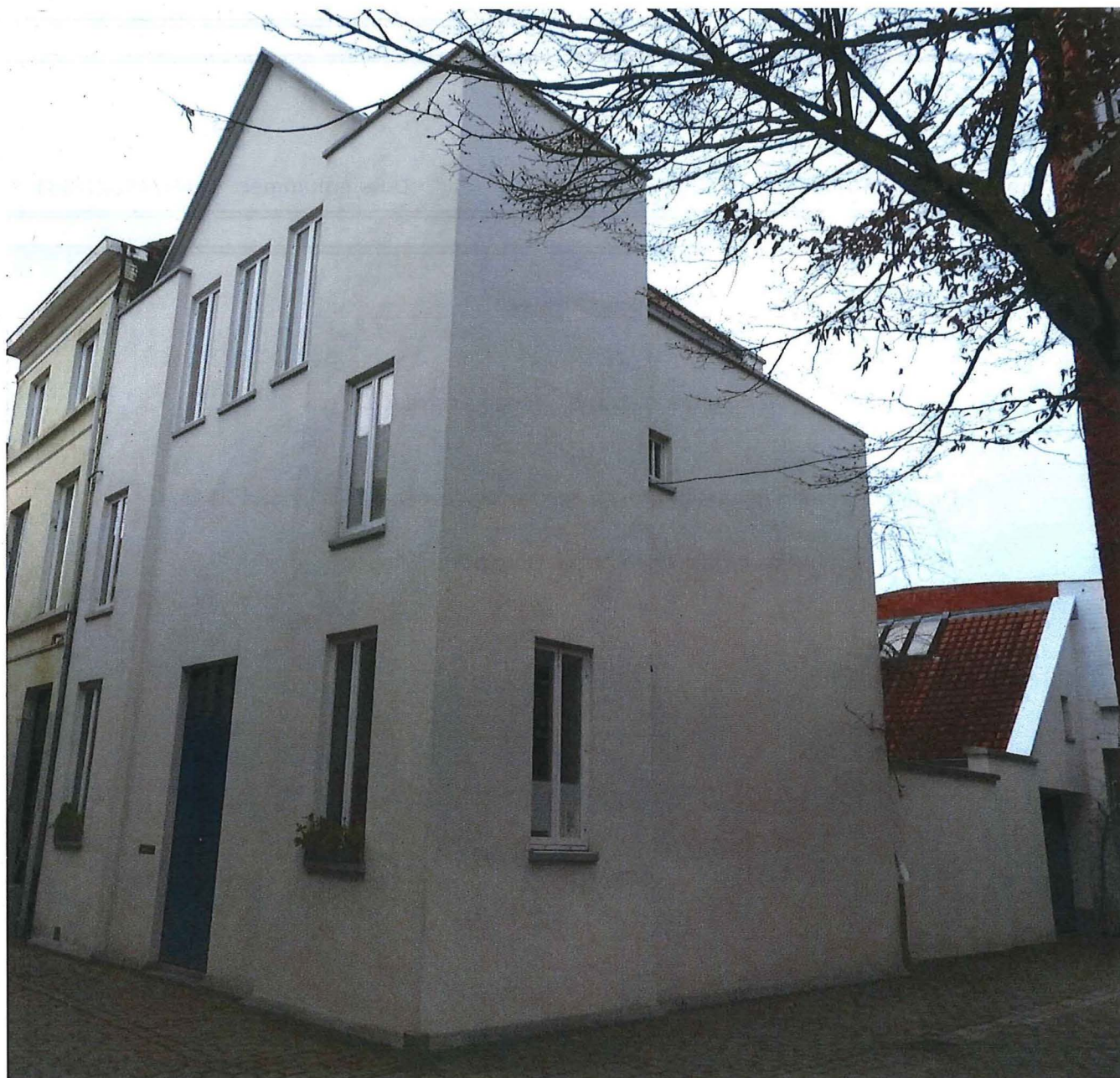
Foto 1 : voorgevel en noordelijke zijgevel.
