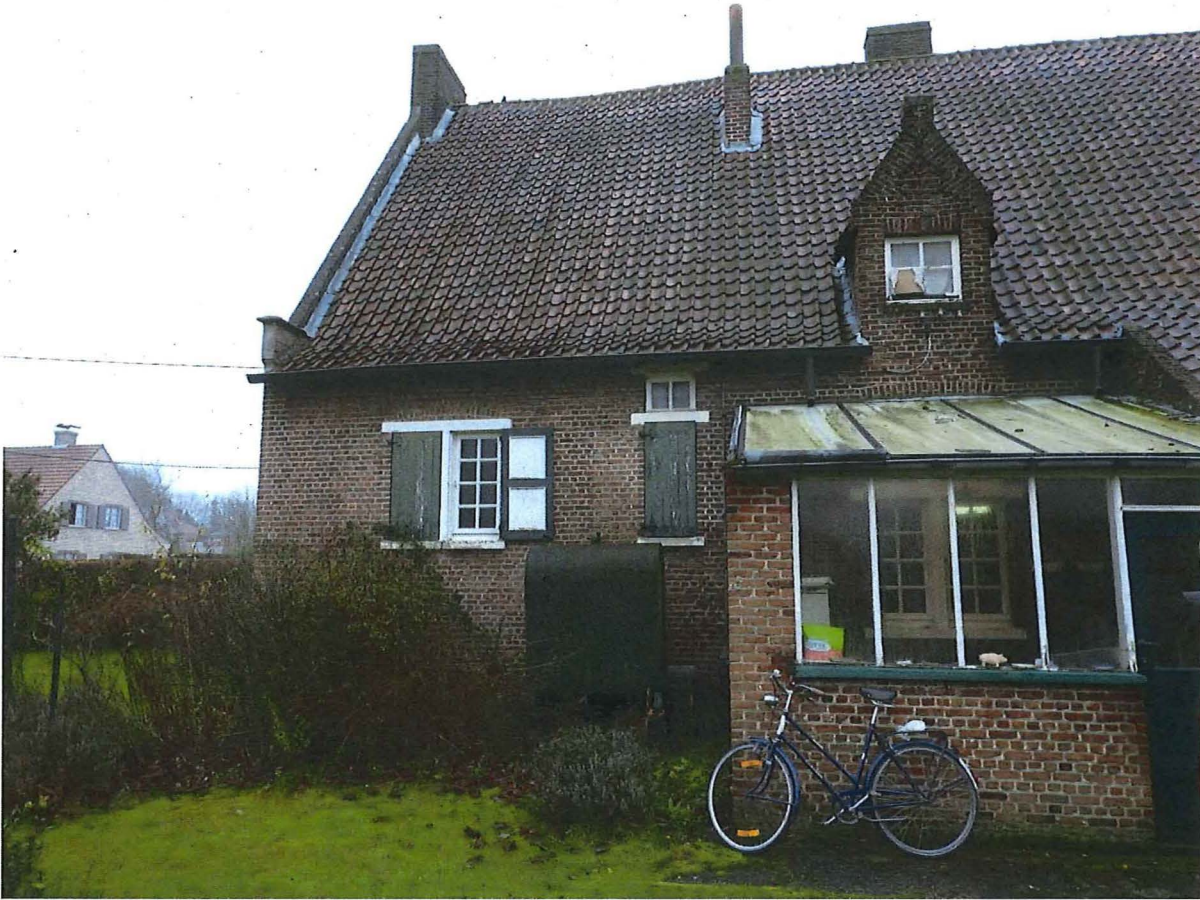
Foto 3 : achtergevel (oostelijk deel)
