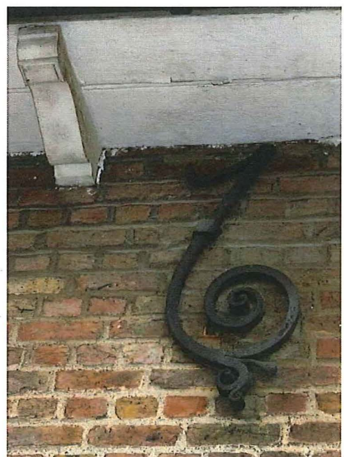
Foto 7 : voorgevel (uitkragend dak op modillons en sieranker)
