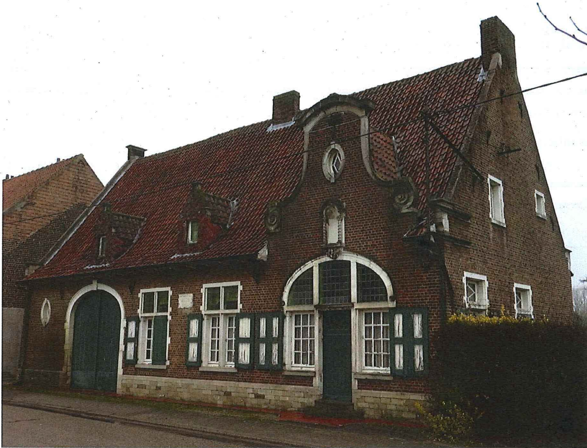
Foto 1 : voorgevel en oostgevel
