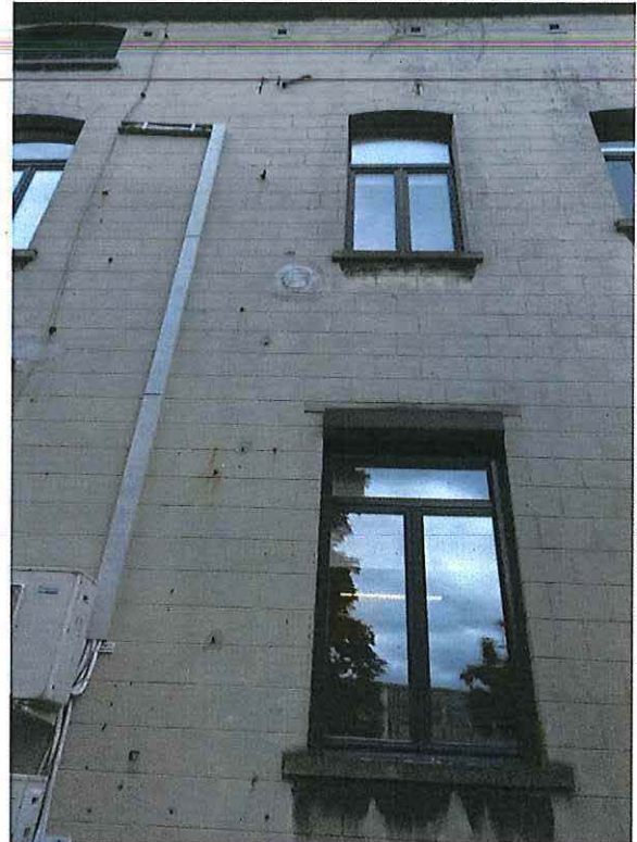
Foto 19: Detail middelste travee achtergevel herenwoning Delacre (18 juni 2018).
