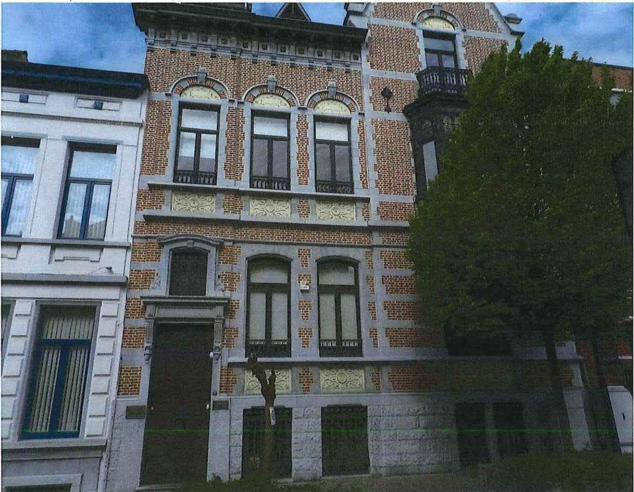
Foto 6: Detail lijstgevel herenwoning Delacre (18 juni 2018).
