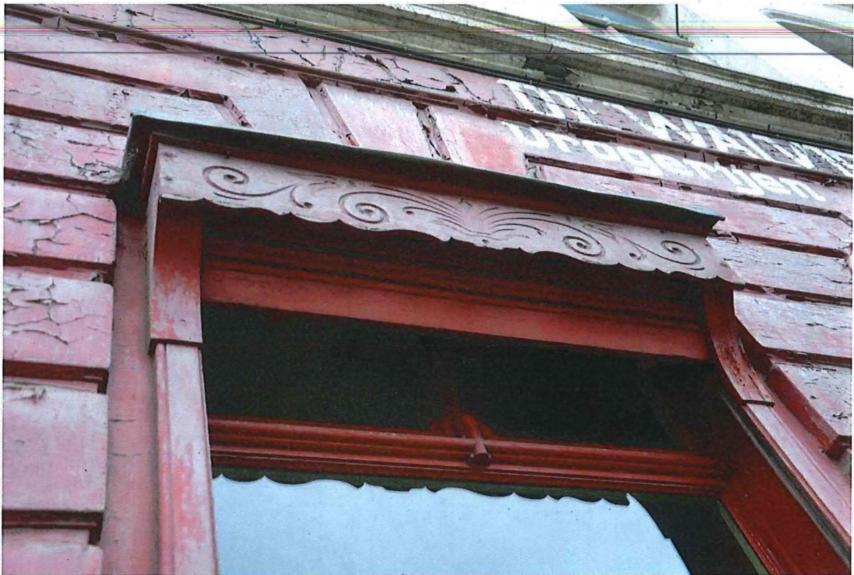
Foto 8: Voorgevel, detail venster (1ste travee). Zicht op rolluikkast en bewaard bovenlicht.
