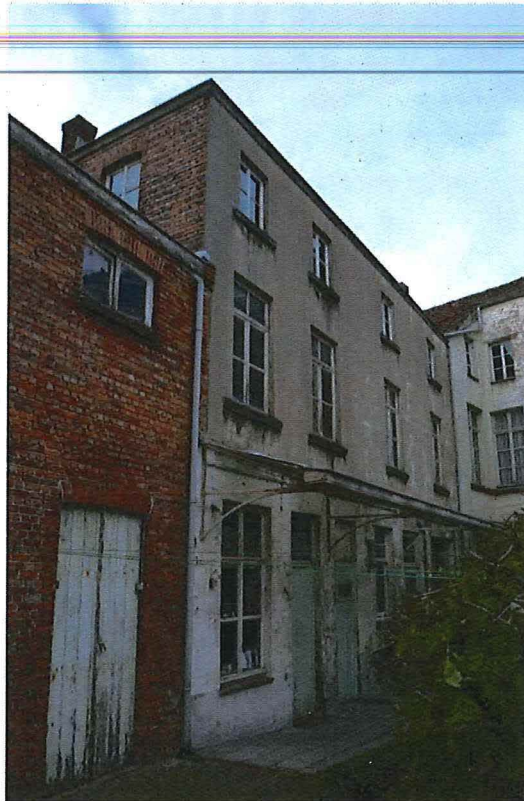
Foto 12: Algemeen zicht op de tuingevel van de achterbouw (links, de deur naar het magazijn).
