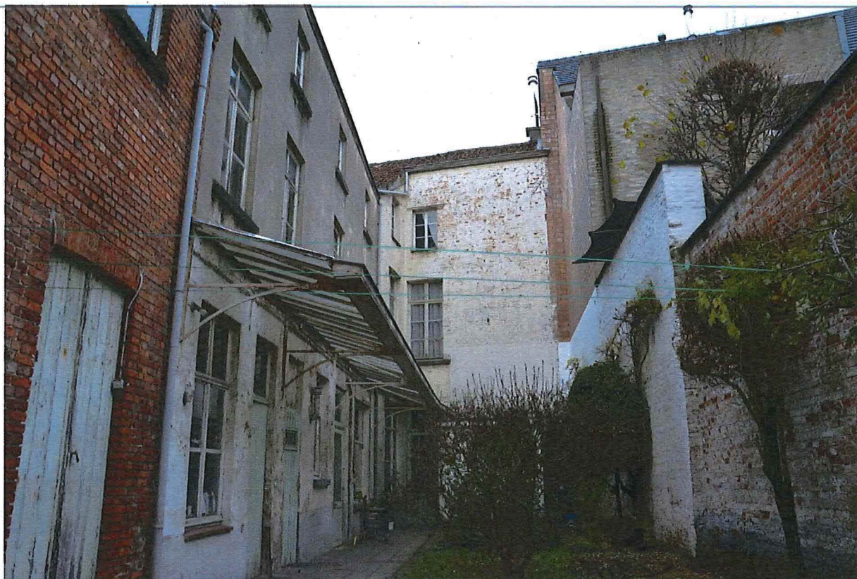
Foto 10: Exterieur achterzijde, algemeen zicht naar de noordzijde (richting de Ankerstraat). De luifel voorziet in de circulatie tussen de ruimtes op het gelijkvloers.
