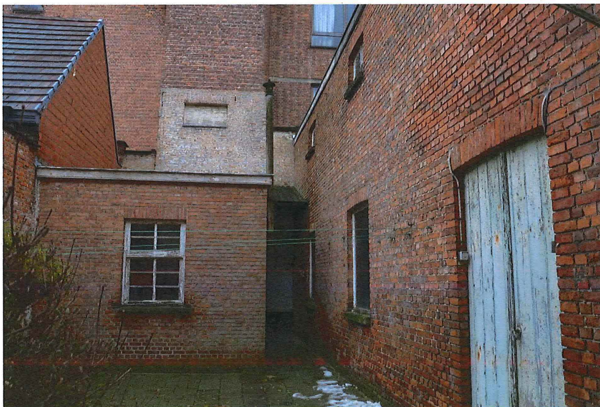
Foto 11: Exterieur achterzijde, algemeen zicht naar de zuidzijde.
