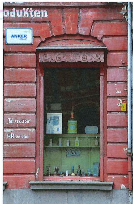
Foto 6: voorgevel, detail venster (4de travee) met rolluikkast.
