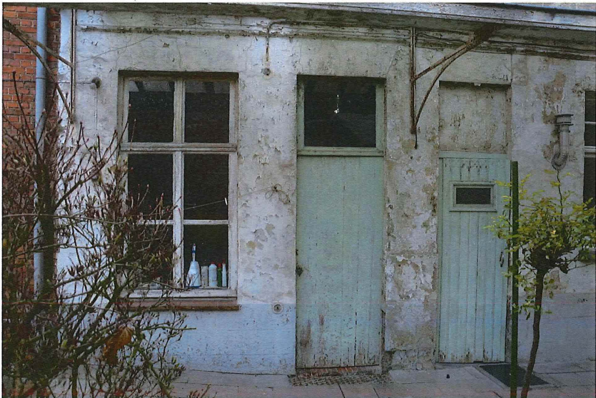
Foto 13: Achterbouw, gelijkvloers (raam en deur van het pomphuis; plankendeur van het toilet).
