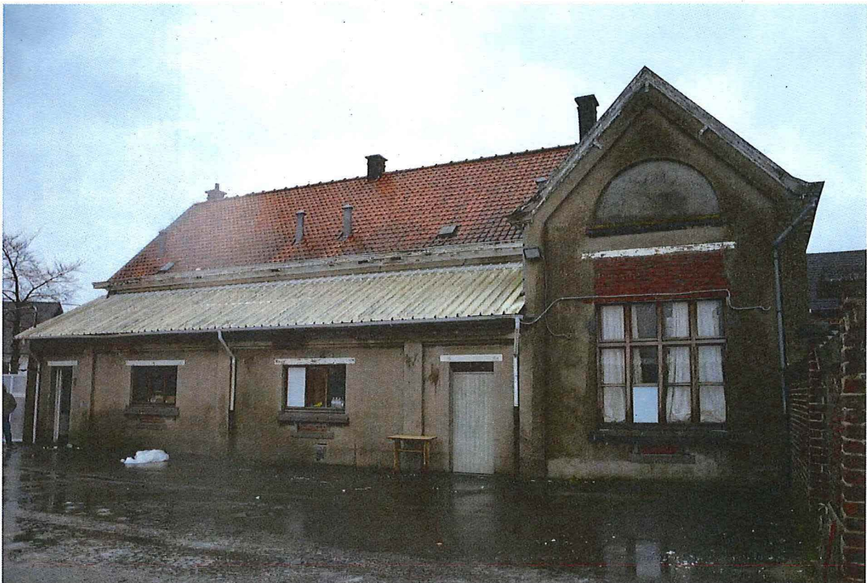
Foto 17: Achtergevel gemeenteschool met puntgevel (13/12/2017).
