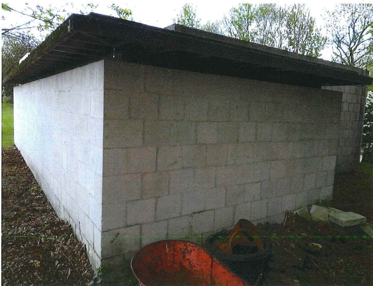
Foto 11 : berging (noordwestelijke en noordoostelijke gevel)
