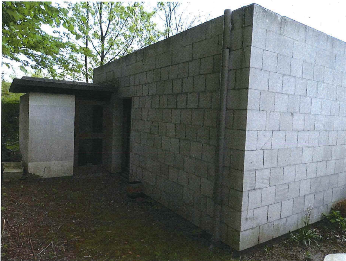
Foto 10 : noordwestelijke zijgevel met berging
