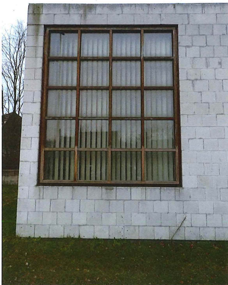
Foto 5 : ateliervenster in de voorgevel
