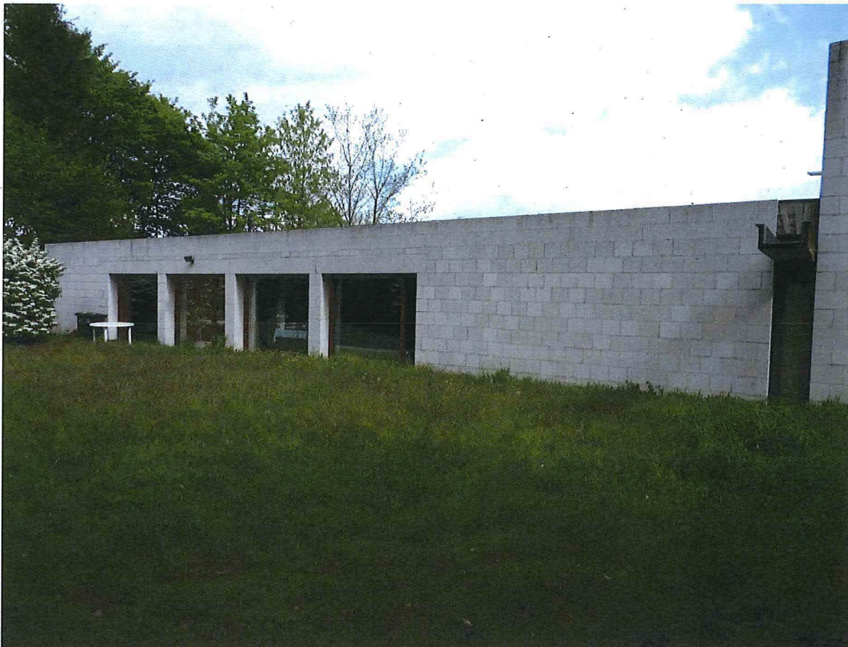
Foto 6 : achtergevel (noordwestelijk deel)
