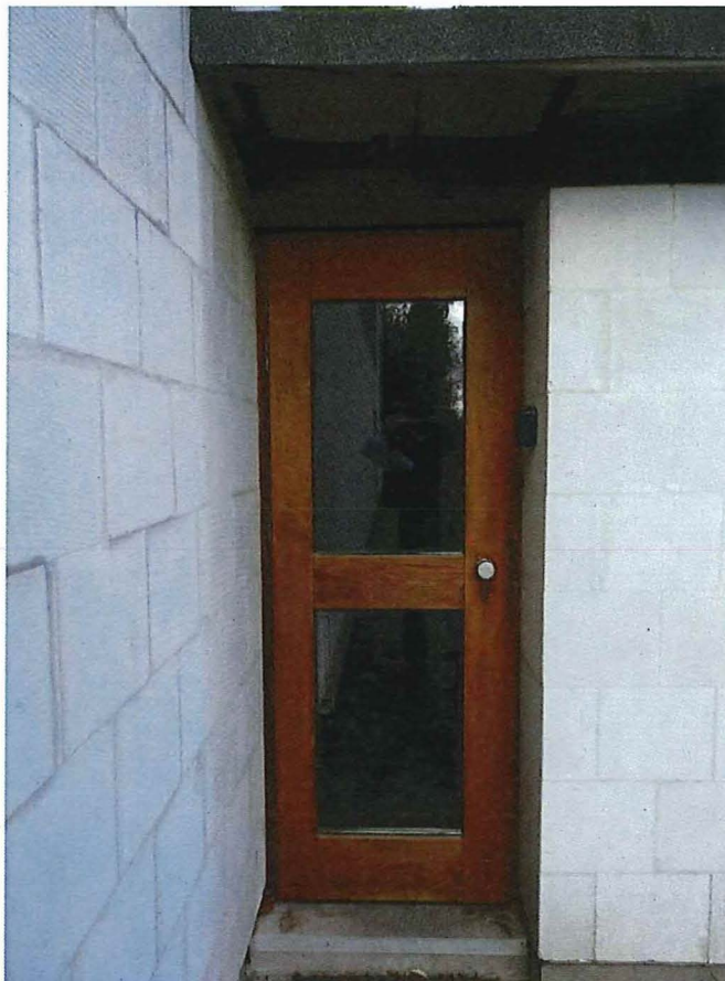
Foto 4 : deur in de zuidoostelijke gevel van de berging
