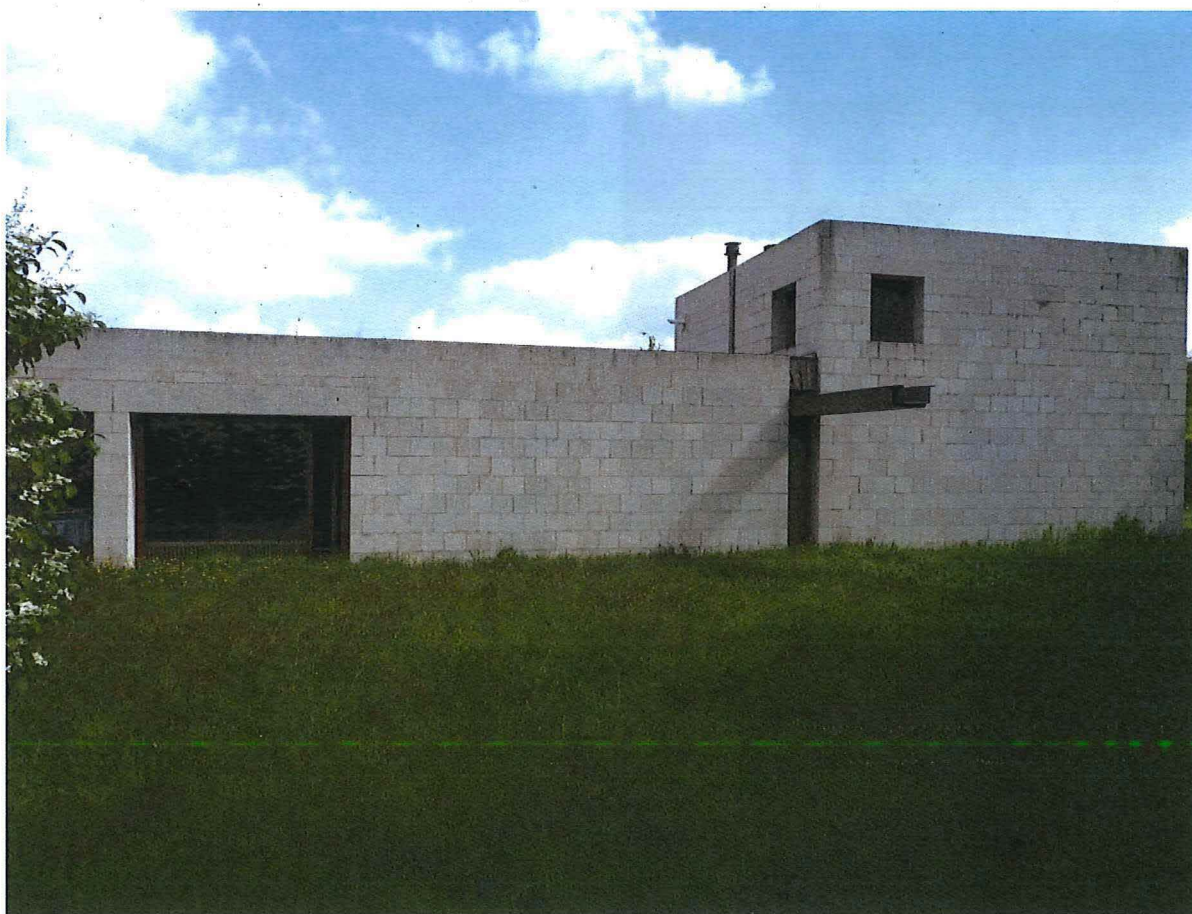
Foto 7 : achtergevel (zuidoostelijk deel)
