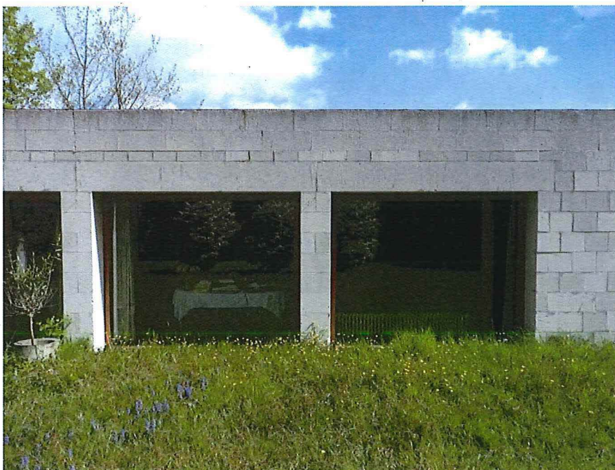
Foto 9 : achtergevel met grote vensters
