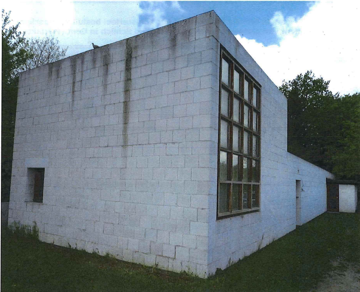
Foto 1 : zuidoostelijke zijgevel en voorgevel
