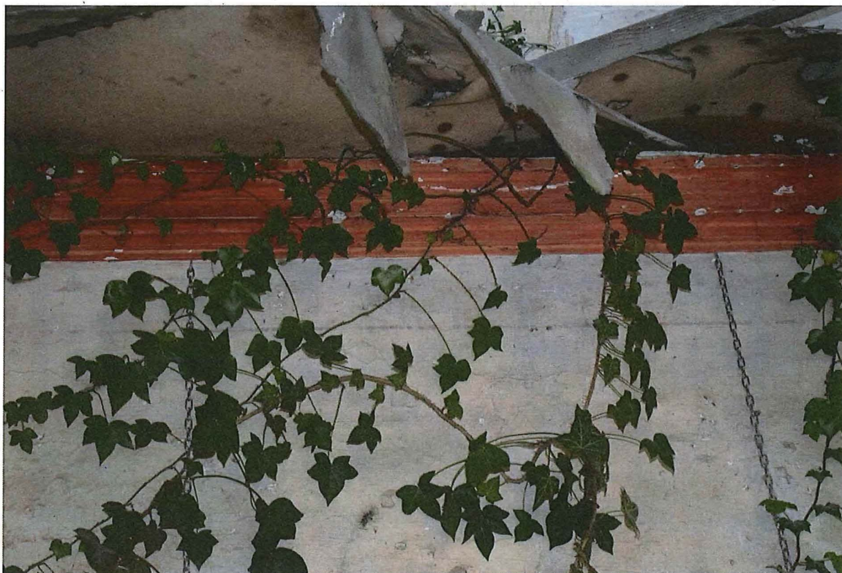
Foto 28: tuinpaviljoen: fragmentarisch bewaarde binnenbepleistering met omlopend lijstwerk
