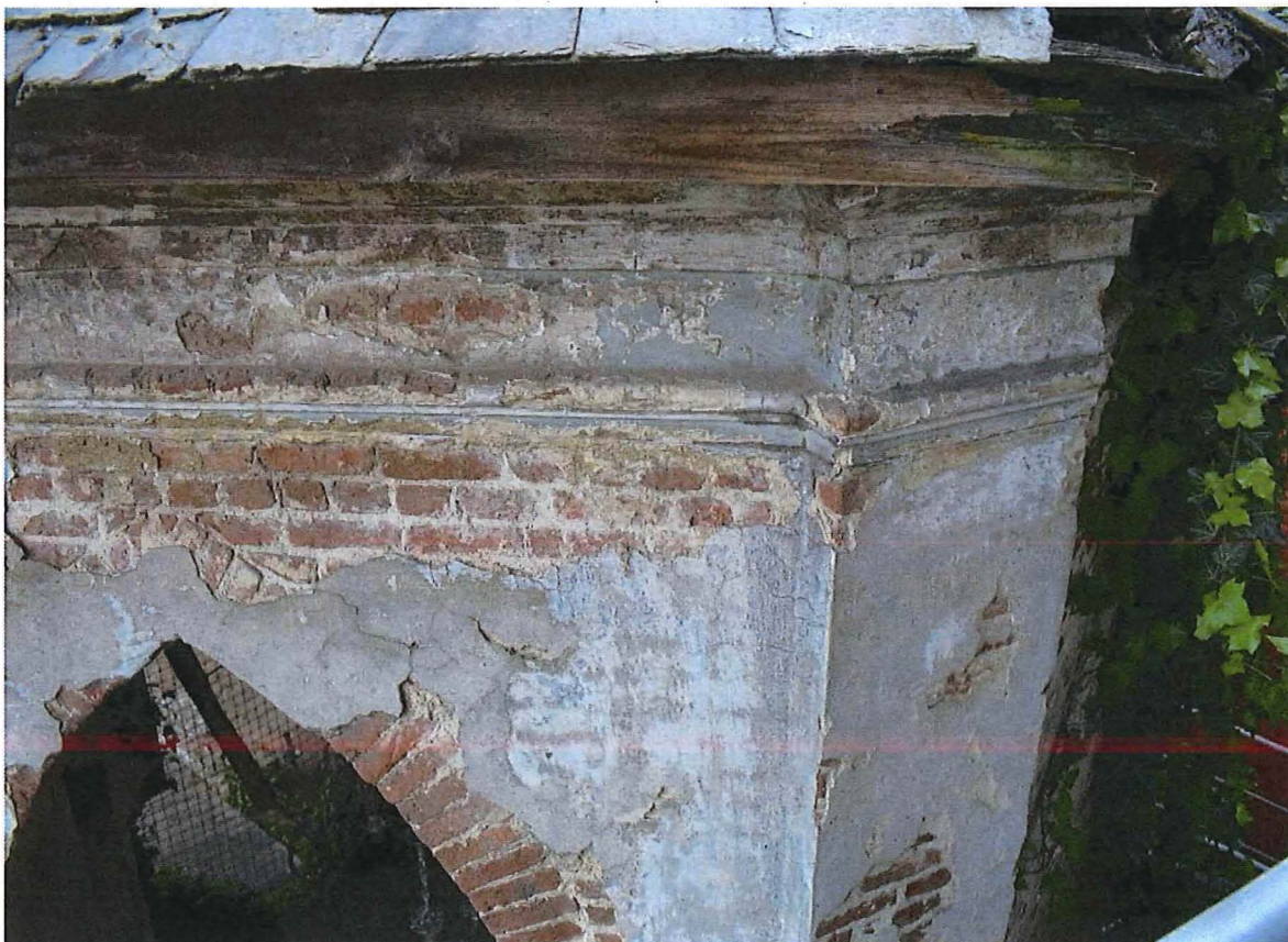
Foto 12: noord-oostzijde: detail van de gevelbeëindiging met profileerde daklijst: fragmentarisch bewaarde buitenbepleistering
