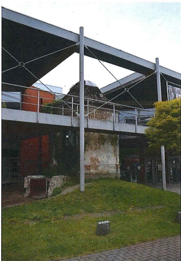
Foto 3: het tuinpaviljoen met ijskelder ingekapseld in de staalstructuur van de sport- en evenementenhal
