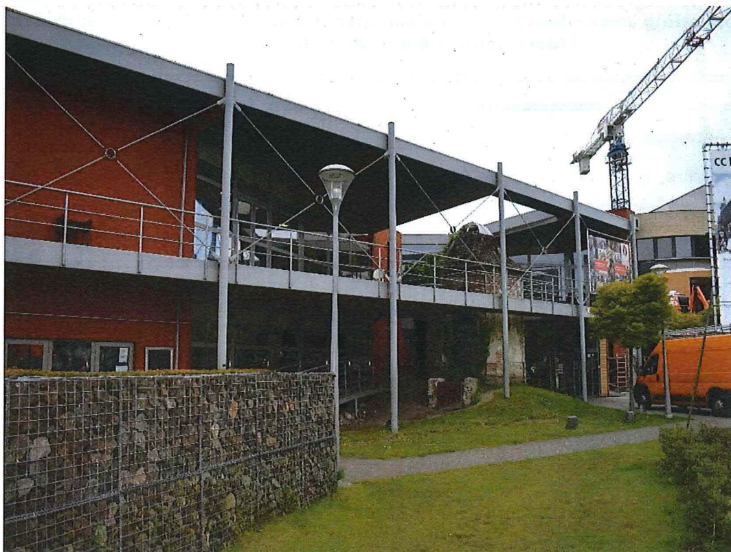
Foto 1: het tuinpaviljoen met ijskelder ingekapseld in de staalstructuur van de sport- en evenementenhal
