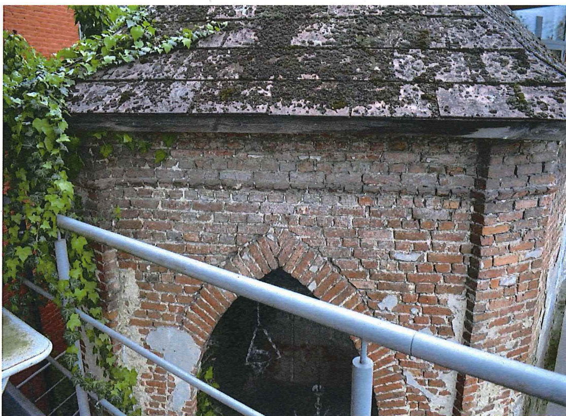
Foto 13: zuid-oostzijde: detail van de gevelbeëindiging met profileerde daklijst: buitenbeploistering niet meer bewaard
