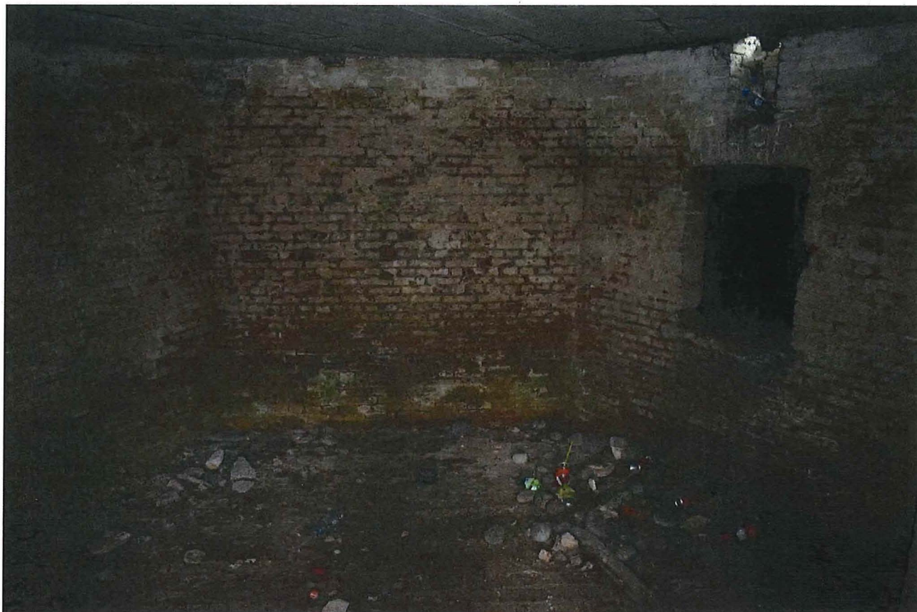
Foto 20: ijskelder: muur- en ventilatieopening
