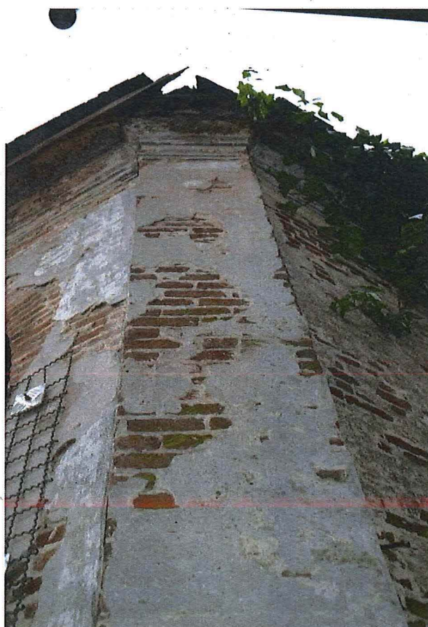
Foto 9: detail buitengevel met lisenen op de hoeken
