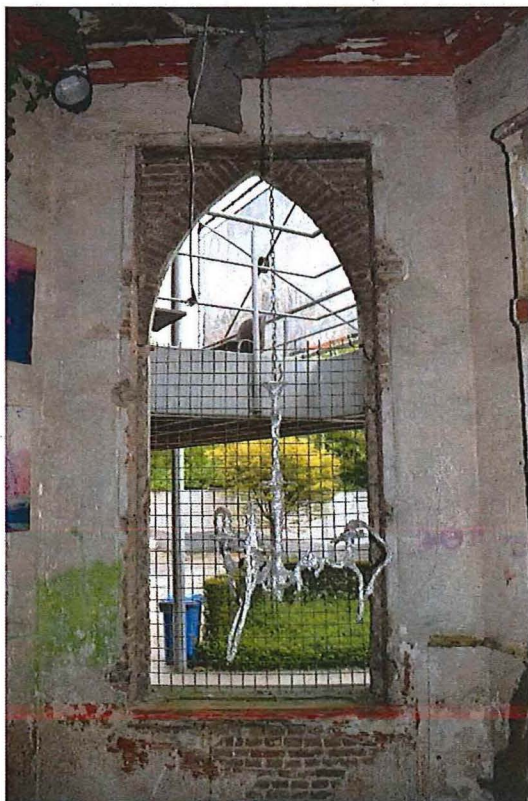
Foto 24: tuinpaviljoen: spitsboogvormig venster afgeschermd met maasnet
