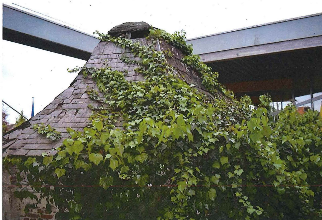
Foto 16: beschadiging van de bedaking door woekerende klimop
