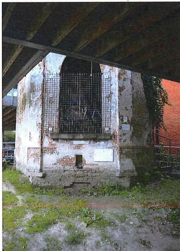
Foto 6: noordoostgevel met venster en verluchtingsopening
