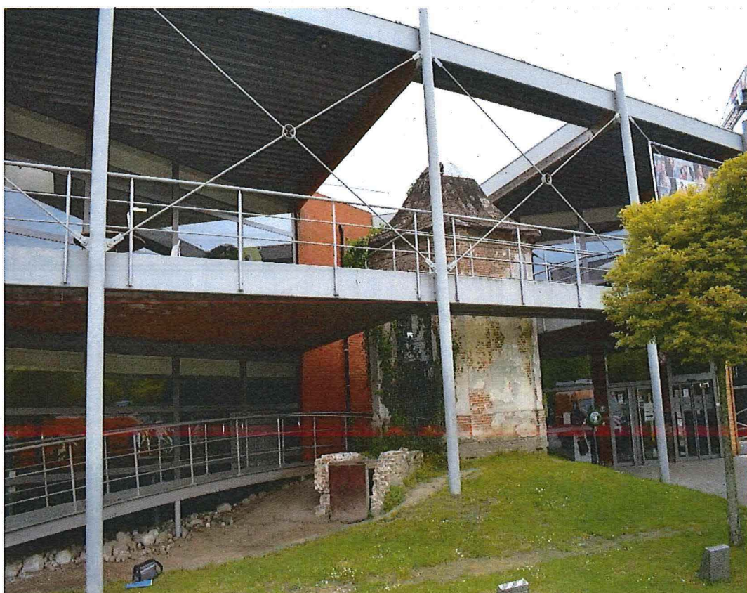
Foto 2: het tuinpaviljoen met ijskelder ingekapseld in de staalstructuur van de sport- en evenementenhal
