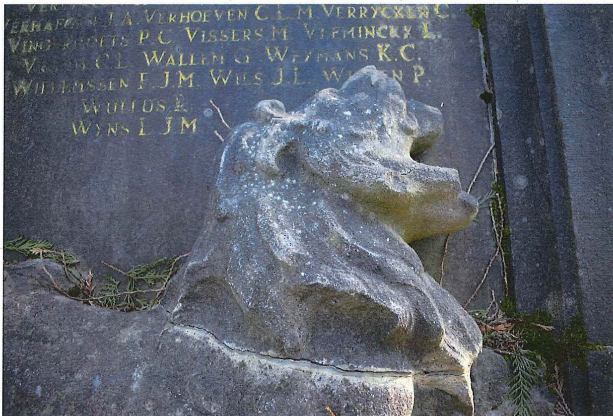
Foto 8: detail leeuwenkop met zichtbare (eertijds ondeskundig herstelde) barst
