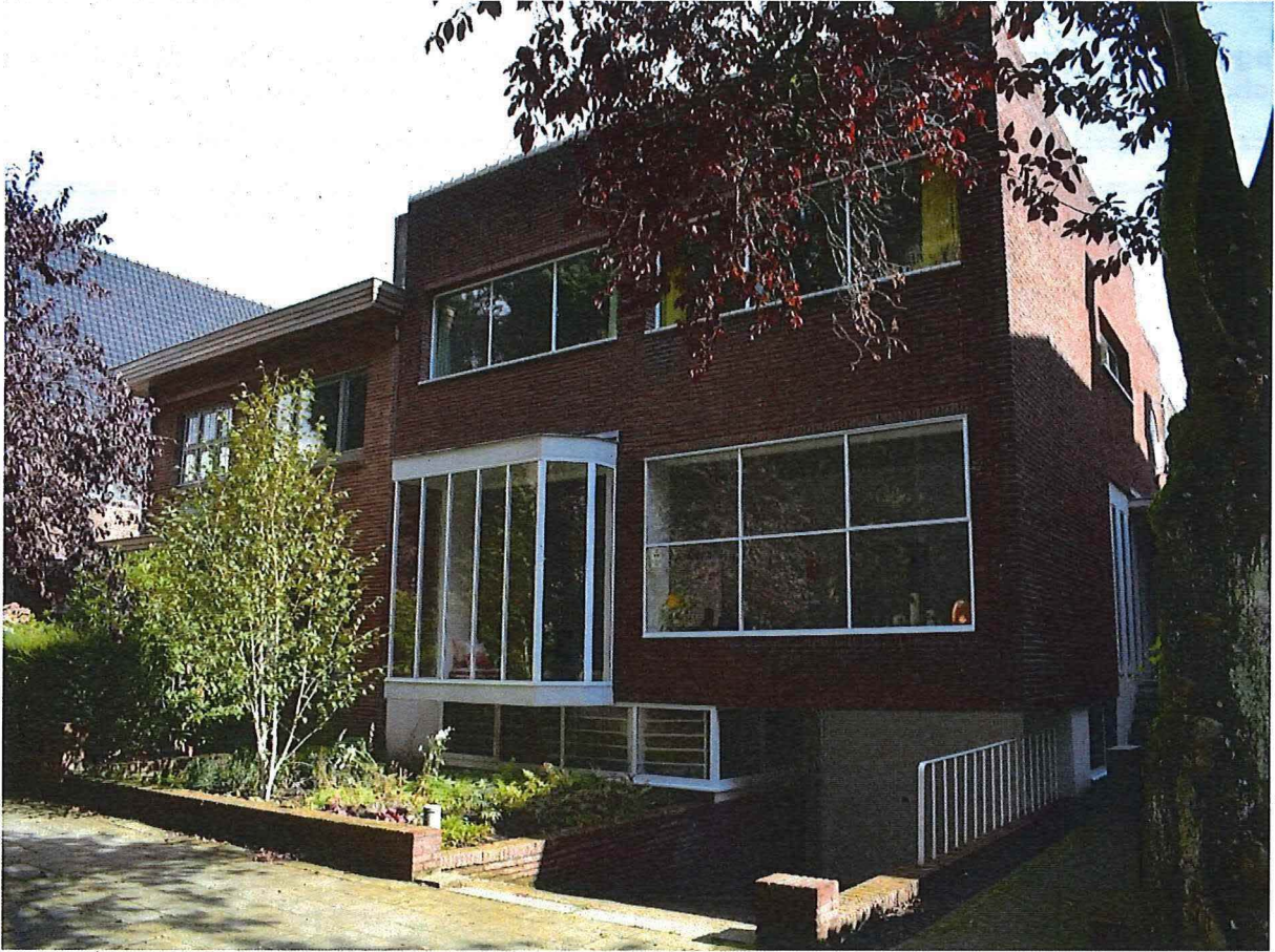
Foto 1: zicht op voorgevel
