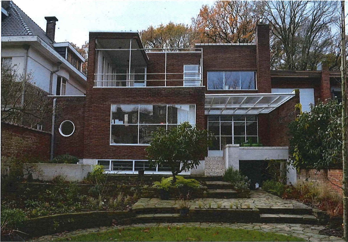
Foto 7: zicht op achtergevel
