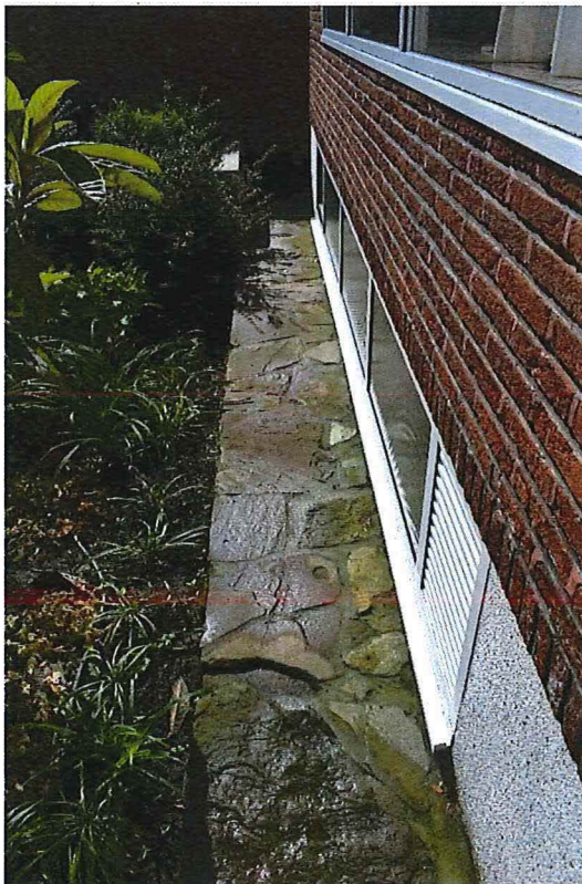
Foto 8: achtergevel met vensterband
