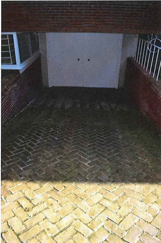
Foto 3: voorgevel met hellingbaan naar de garage
