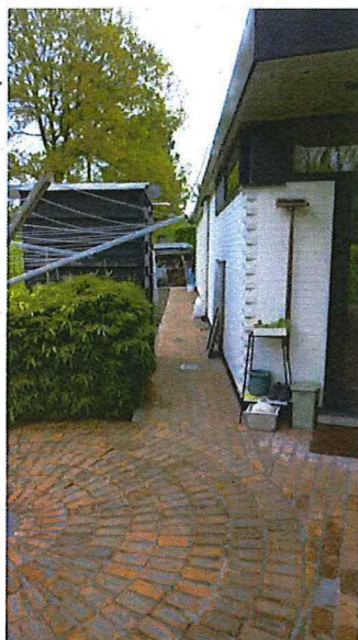
Foto 19: Noordgevel, terras aan de achterdeur.
