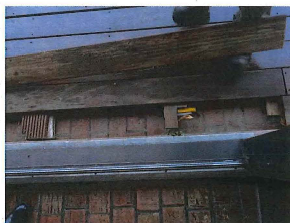
Foto 17: Westgevel, avondterras, detail van de bewaarde bakstenen onder de huidige terrasvloer.
