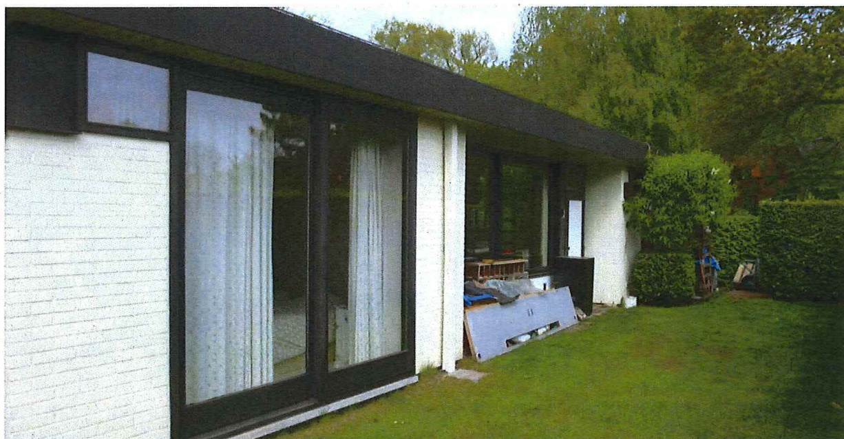
Foto 4: Oostgevel, slaapkamer ouders en architectuurstudio.
