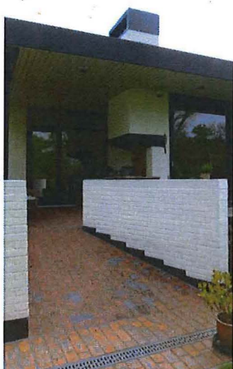
Foto 13: Westgevel, detail hellend vlak tot terras.
