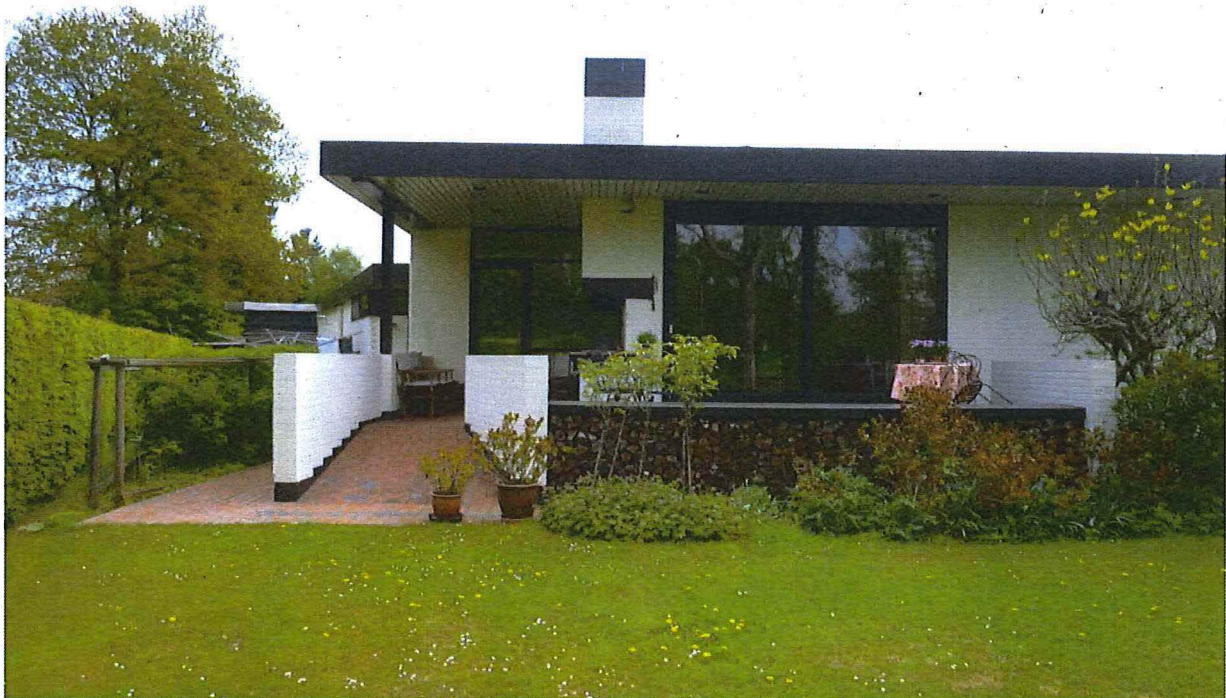
Foto 11: Westgevel, detail terras.
