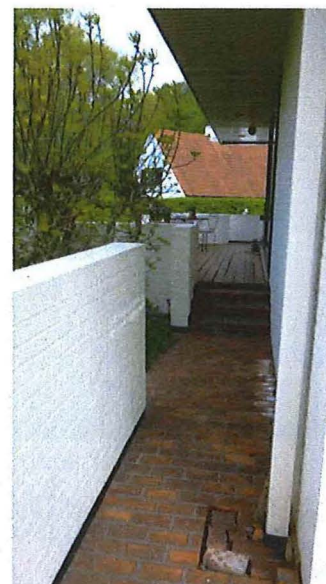
Foto 15: Westgevel, detail pad tussen middag- en avondterras.
