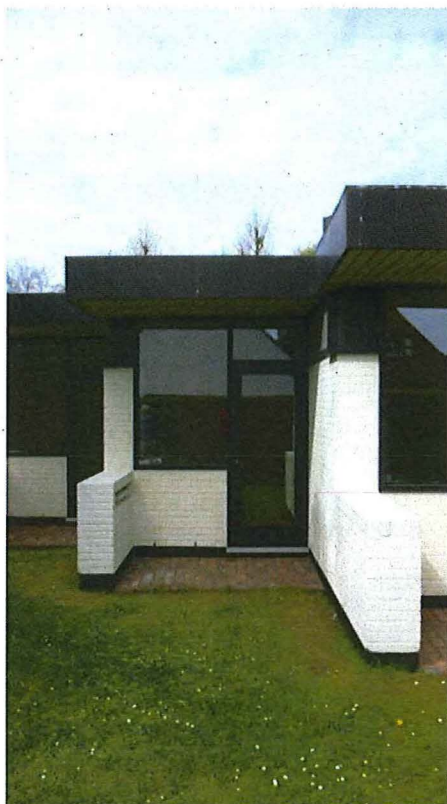
Foto 6: Oostgevel, detail kinderkamer
