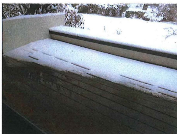
Foto 16: Westgevel, avondterras (heden gedeeltelijk bedekt met houten beplanking).
