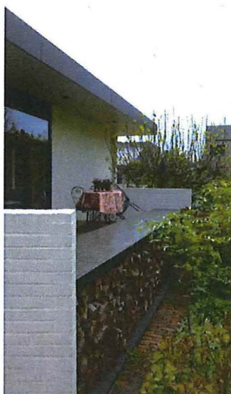
Foto 14: Westgevel, detail terras.
