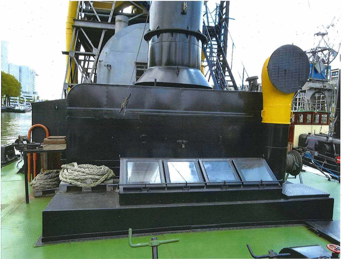
Foto 29: Zicht vanop het voordek op de koelkast boven de stoomketel, met een luchthapper, koekoek en bovenop de basis van de schoorsteen van de stoomketel.
