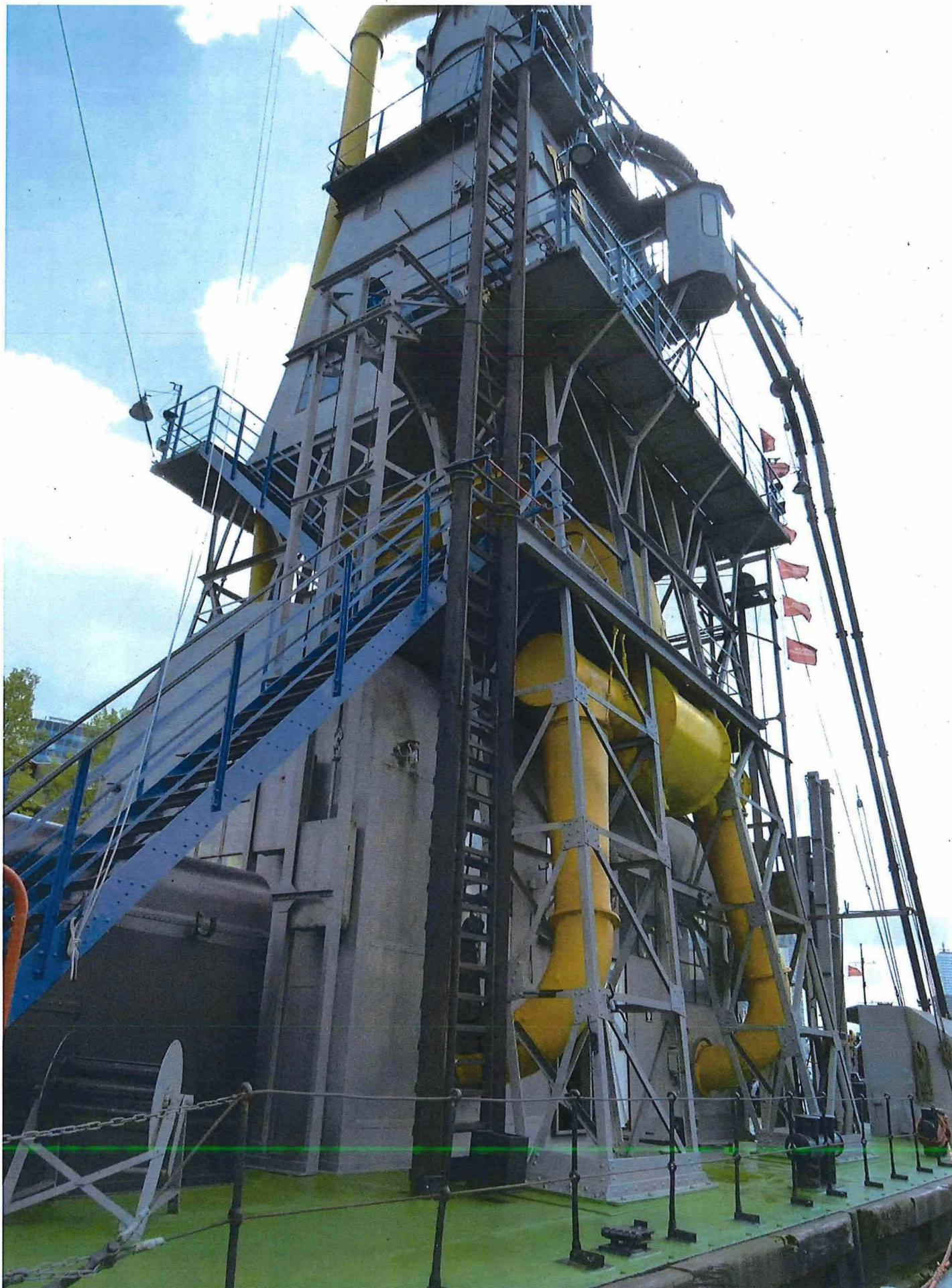
Foto 7: Zicht op de toren vanaf de bakboordzijde.
