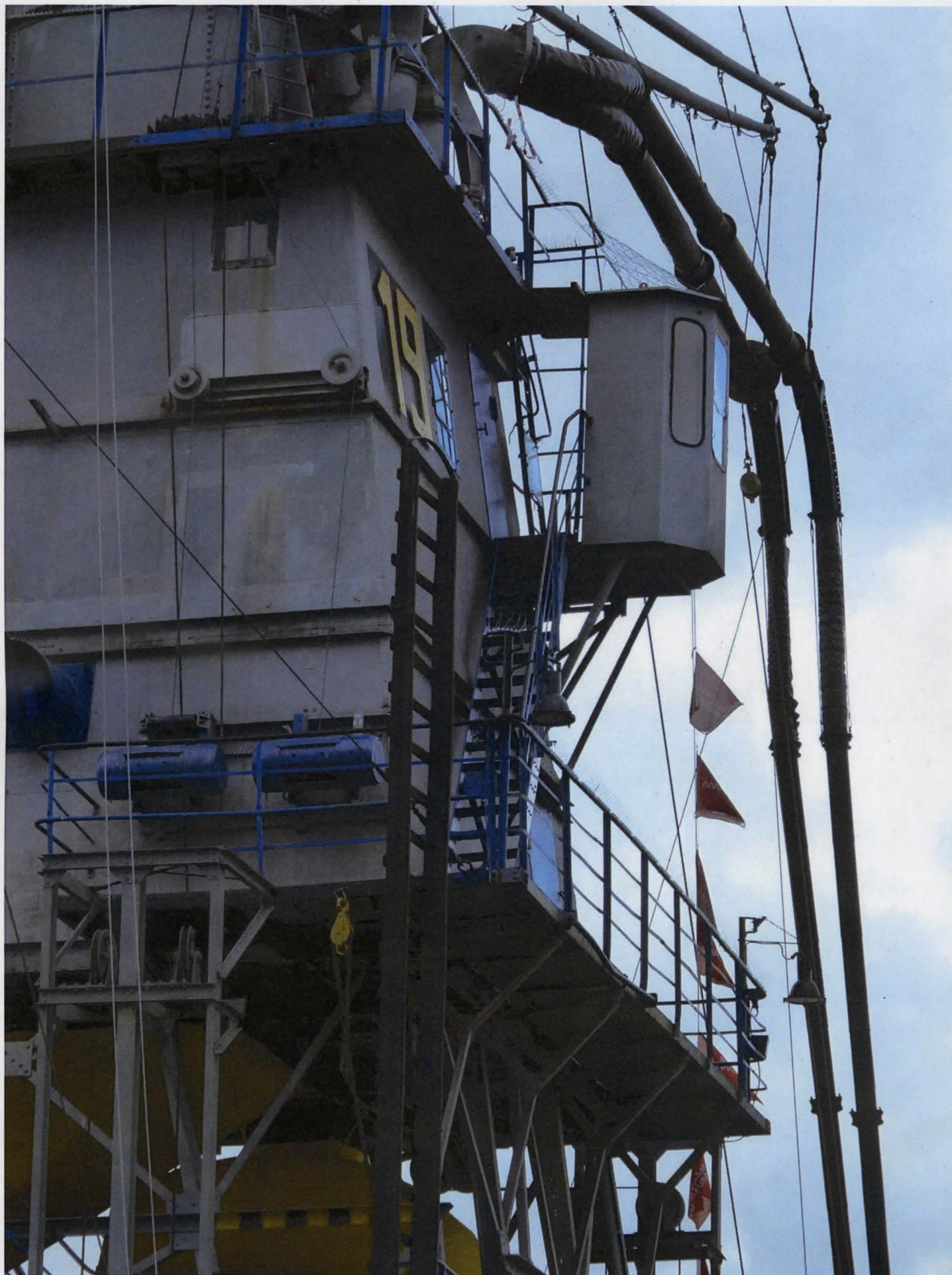
Foto 8: Detail van de toren op het niveau van de weegkamer.
