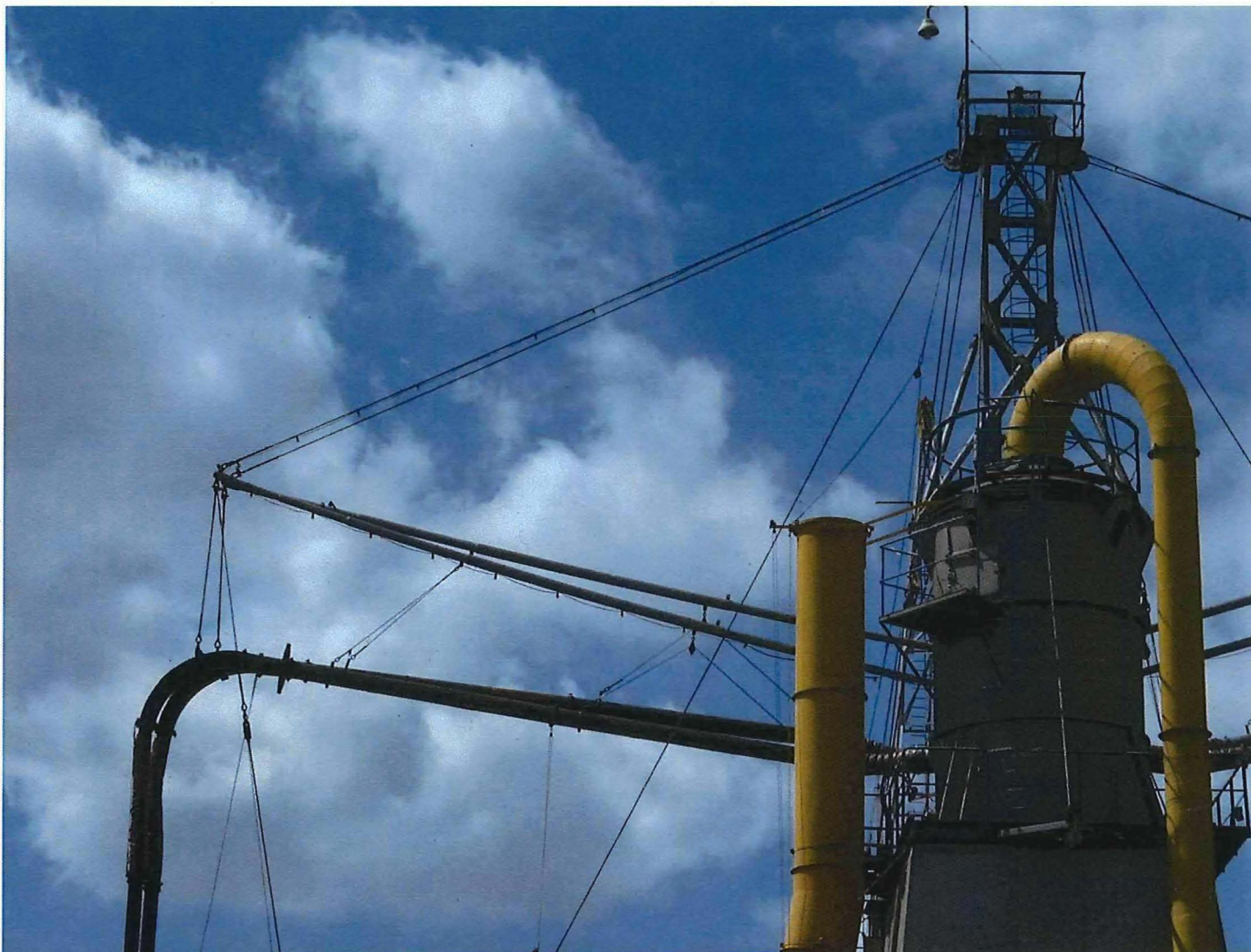
Foto 16: Zicht op de top van de toren met de recipiënt, de mast, de gieken en de graanzuigleidingen.
