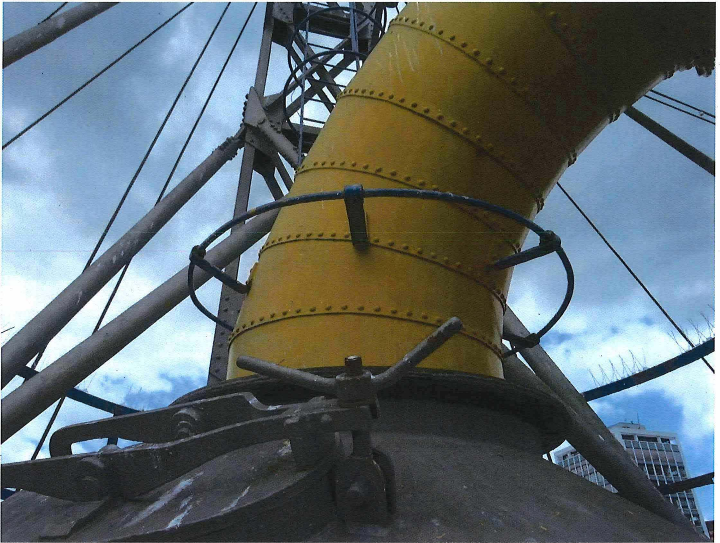
Foto 17: Aansluiting van de luchtzuigleiding die de lucht uit de recipiënt zuigt en met de vacuümpompen is verbonden.
