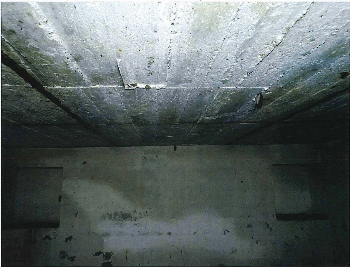
Foto 6: Zicht in de binnenruimte.
