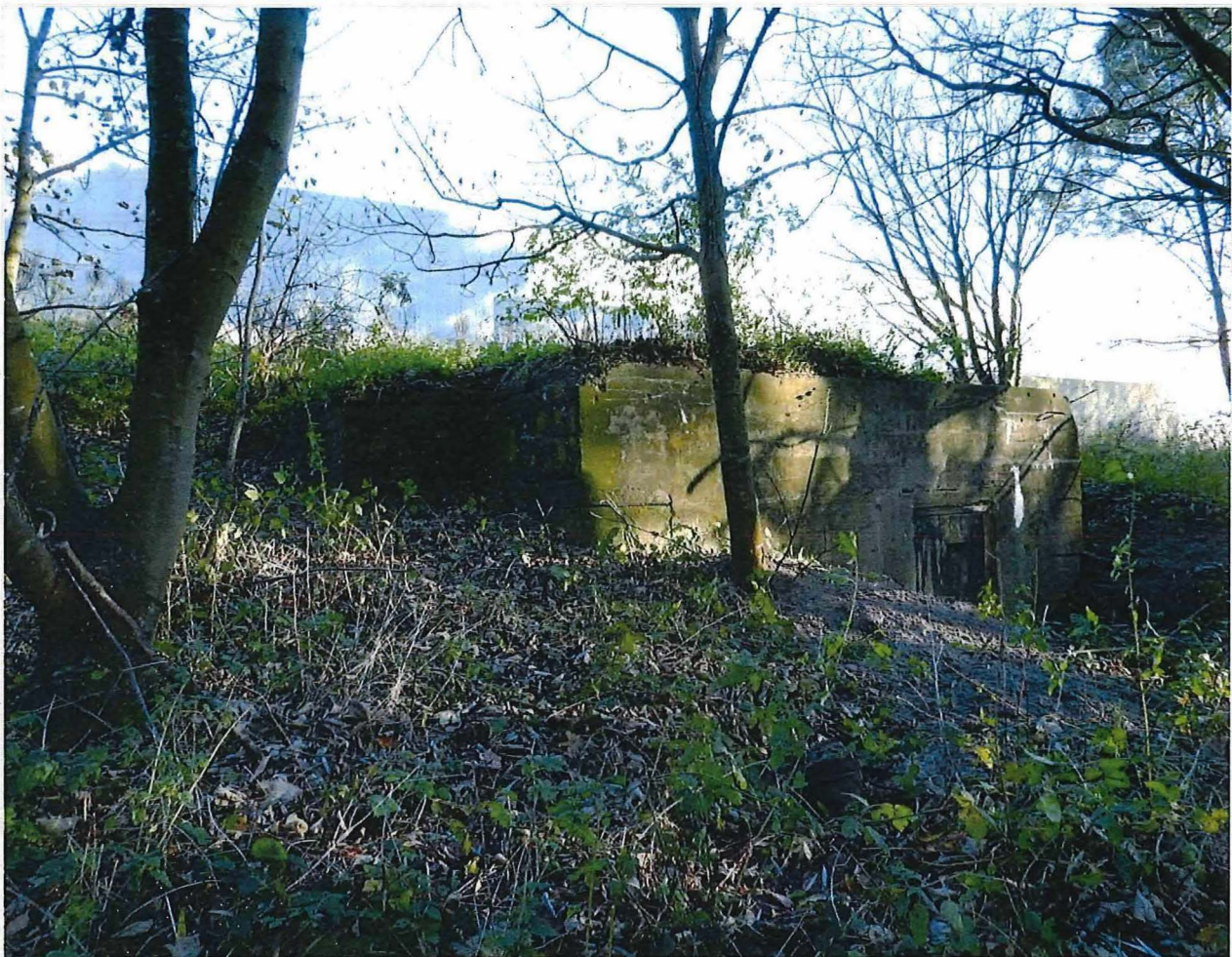
Foto 1: Zicht op de bunker vanaf westelijke zijde.
