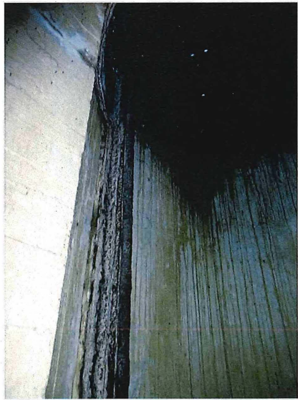
Foto 6: Een geleidingsbalk waarlangs het hefkoopelsysteem op en neer gelaten kon worden.
