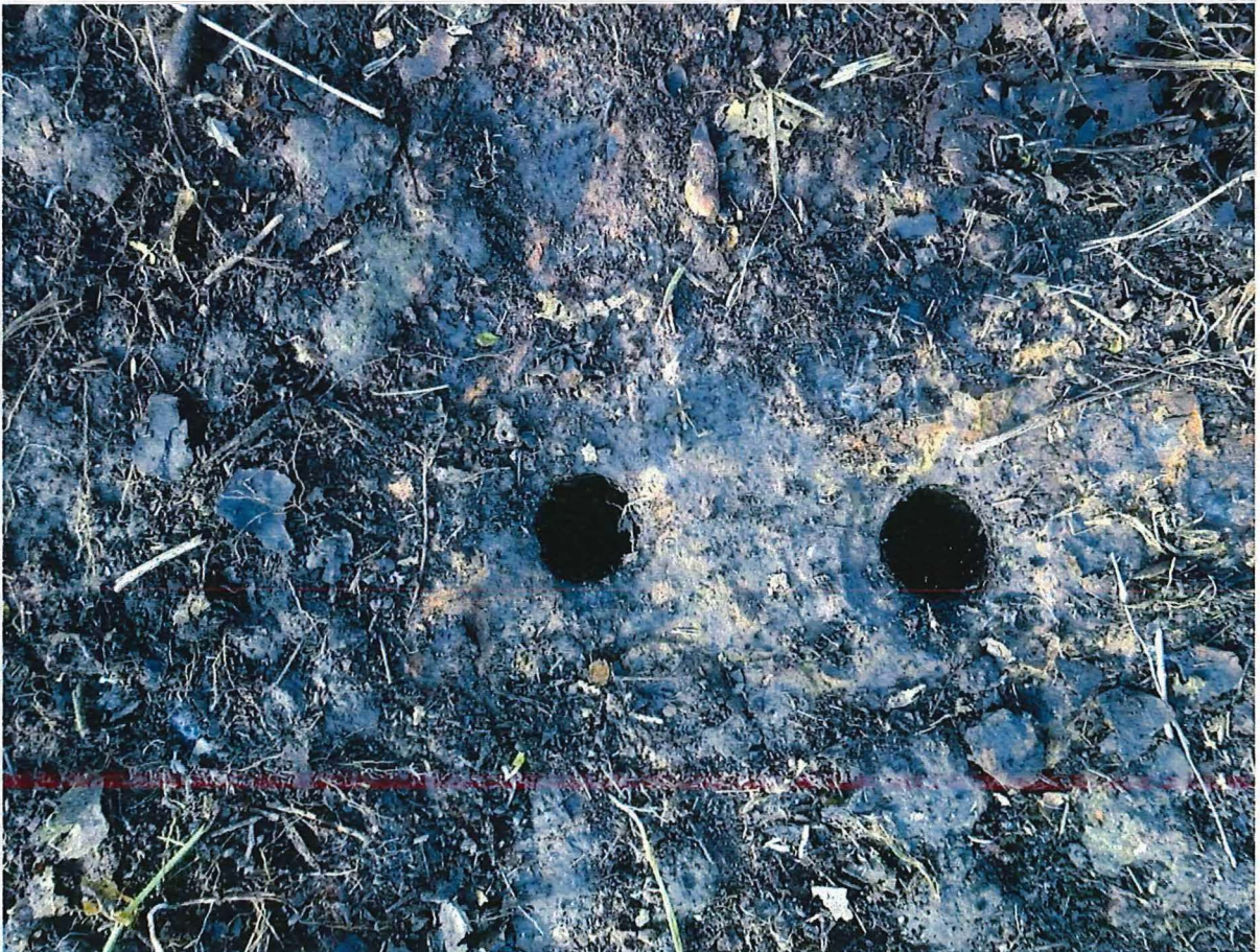
Foto 8: Twee openingen in de pantserkoepel, zichtbaar bovenop de dijk.
