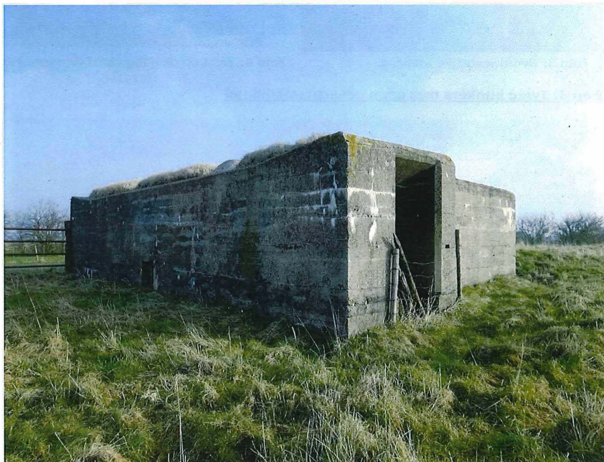
Foto 7: De noordelijke bunker vanuit zuidwestelijke hoek.
