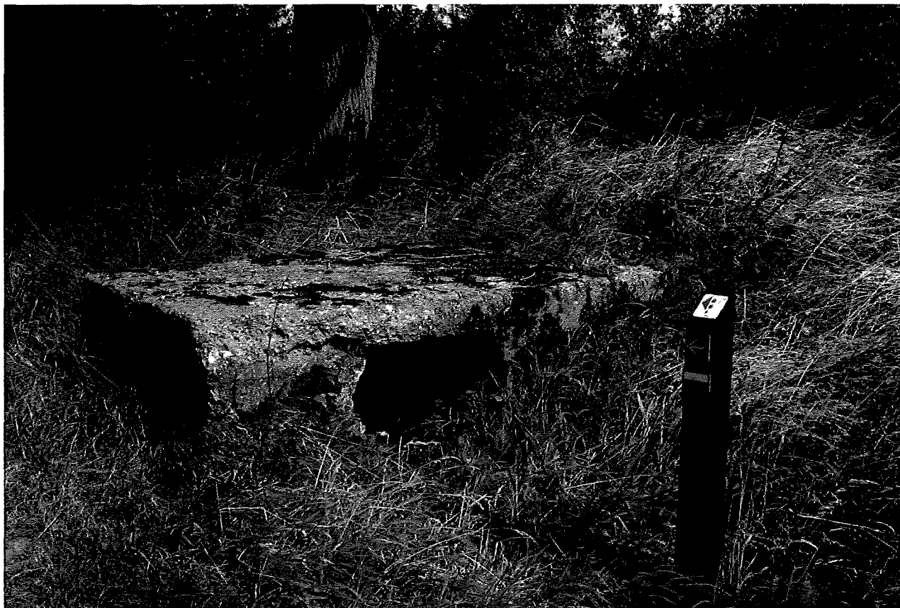
Foto 16: Zicht op het betonnen postje.
