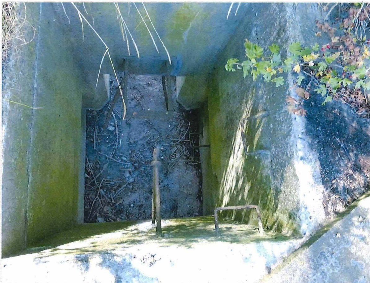
Foto 20: Eén van de twee vierkante mangaten in het dak, met ijzeren elementen.
