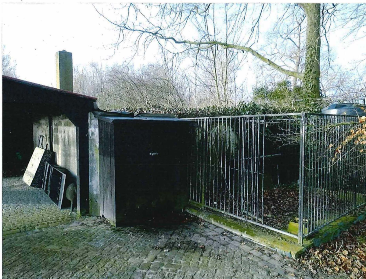
Foto 2: Het manschappenverblijf vanaf noordelijke zijde.
