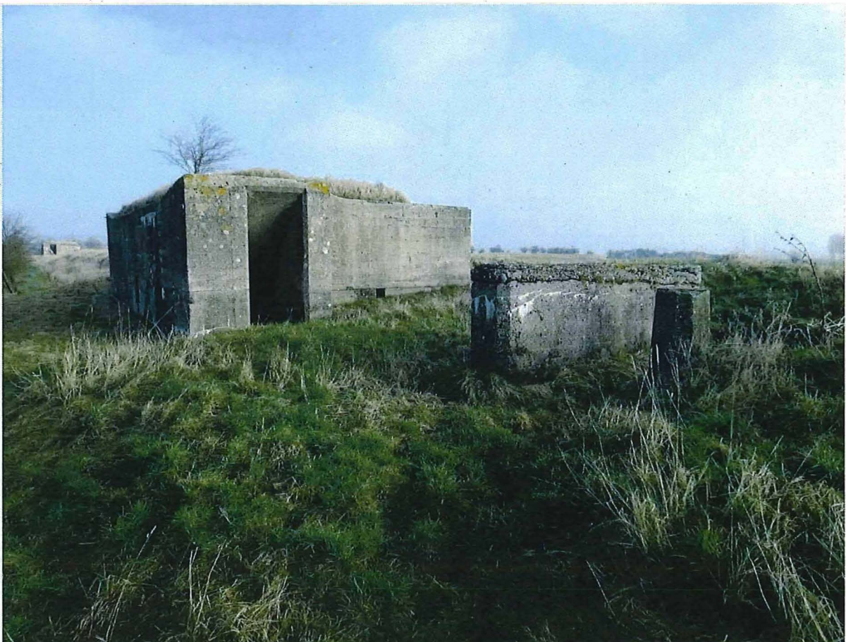
Foto 9: De zuidelijke bunker met open gevechtsstelling. De noordelijke bunker is op de achtergrond te zien.
