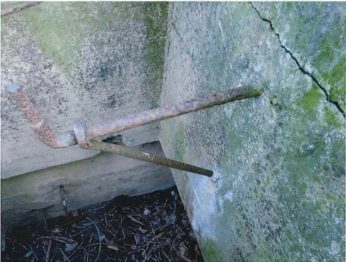
Foto 22: IJzeren haak voor bevestiging waarnemingsapparatuur.
