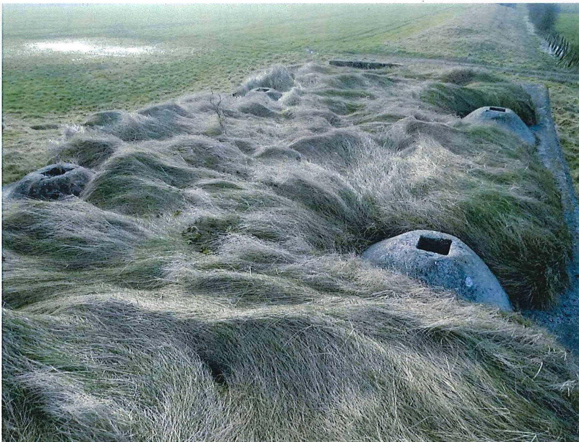
Foto 6: Betonnen uitstulpingen met vierkante openingen op het met gras begroeide dak.
