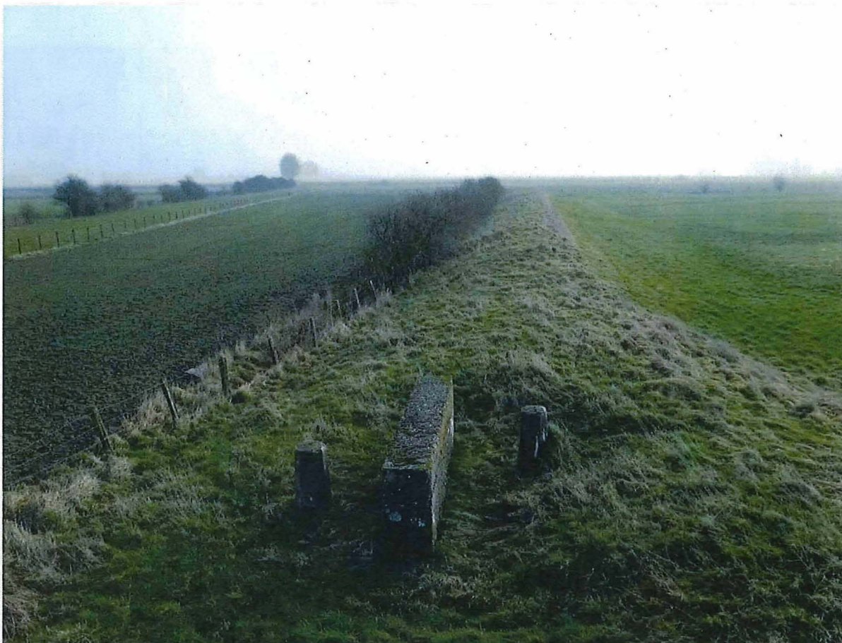
Foto 12: Geschrante opstelling van de mitrailleurspaaltjes ten opzichte van het muurtje.
