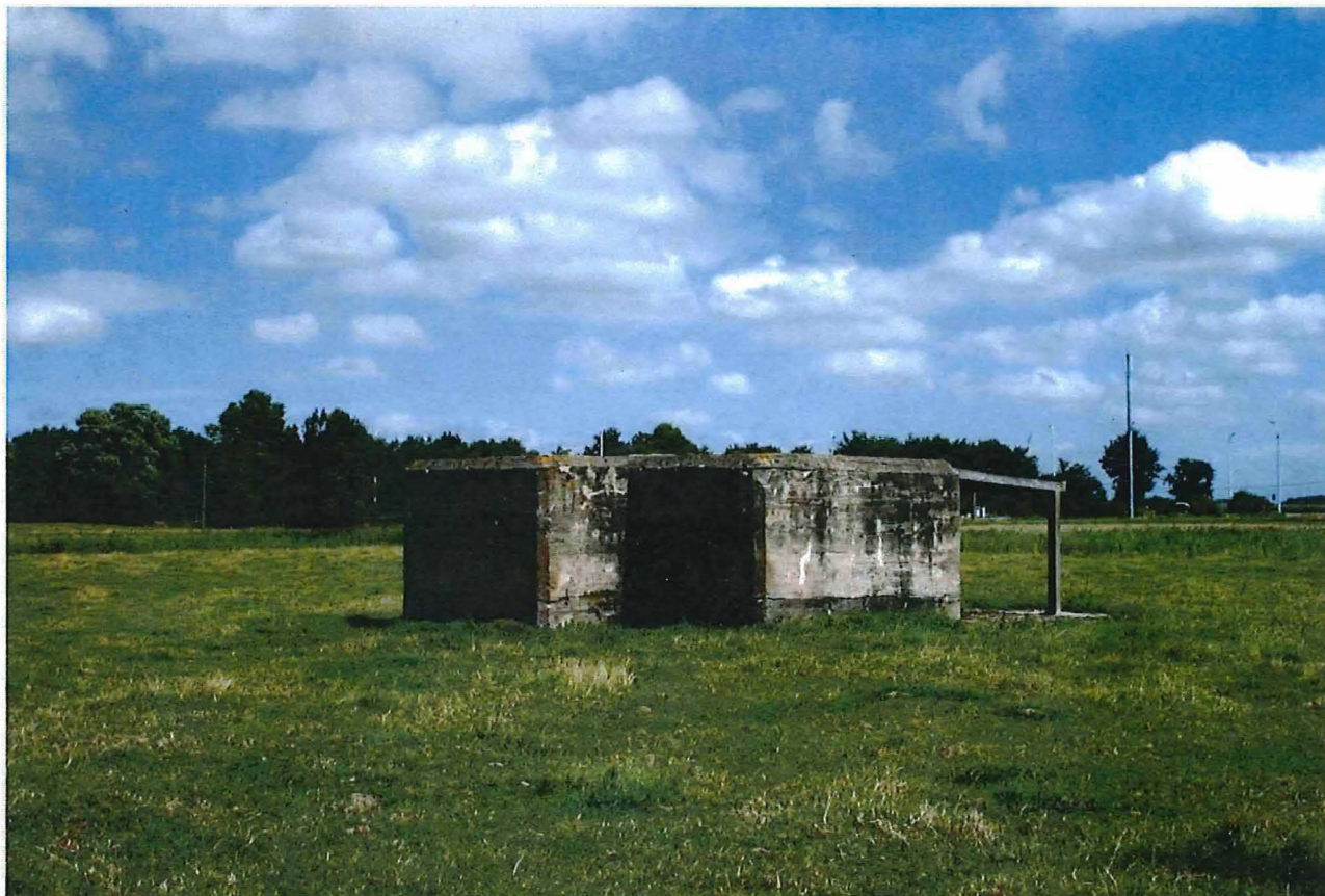
Foto 5: De seinpost vanuit zuidwestelijke hoek.
