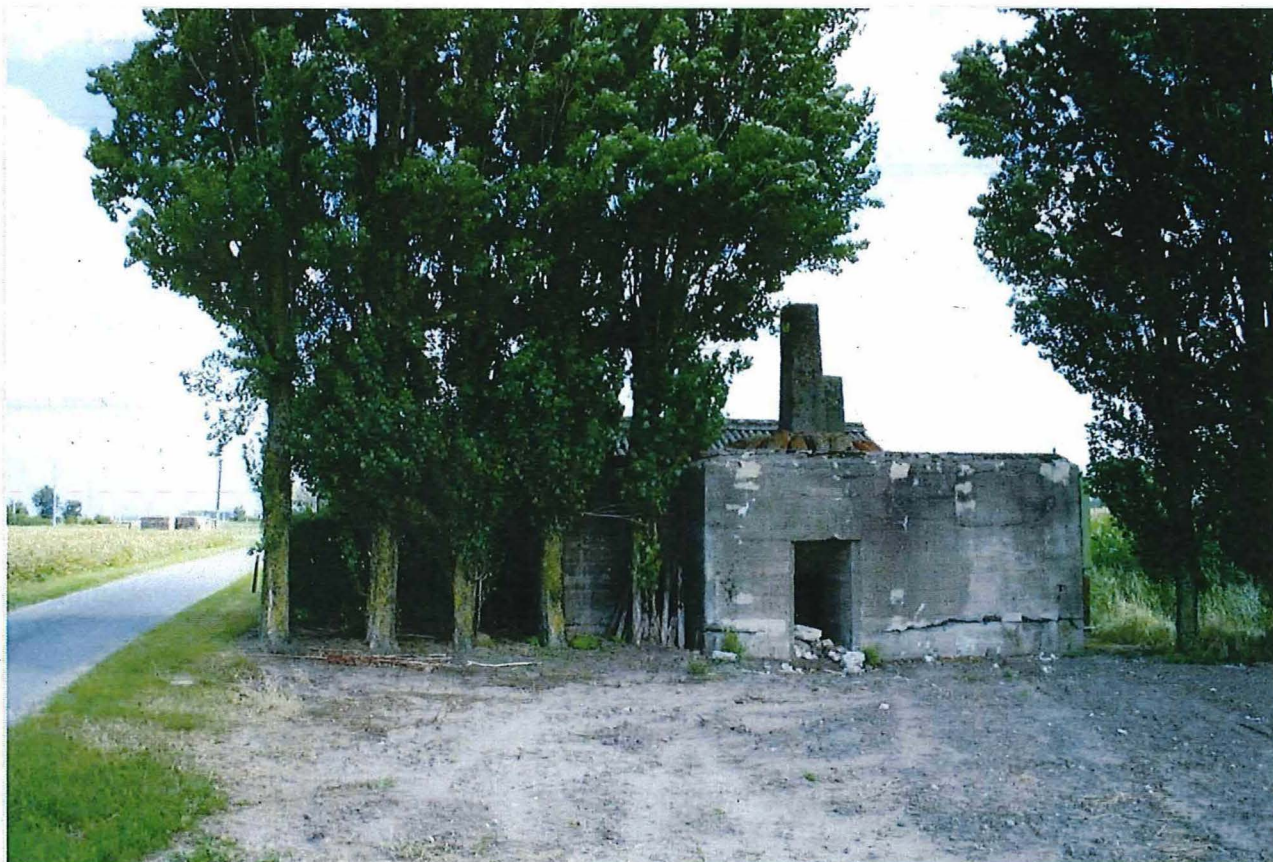
Foto 1: Zicht op de commandopost vanaf westelijke zijde. De seinpost is links op de achtergrond te zien.
