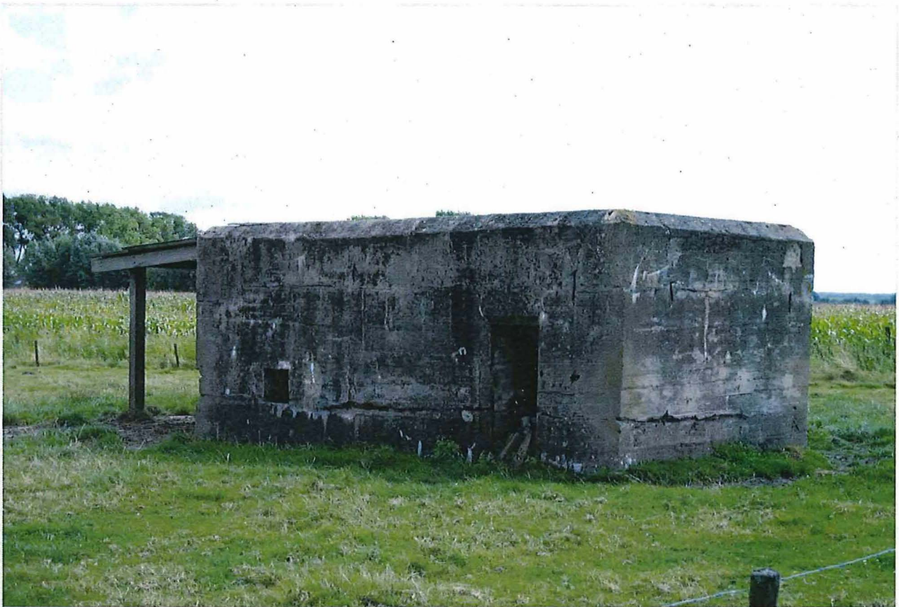
Foto 7: De noordelijke zijde met toegang en één muuropening met traliewerk.
