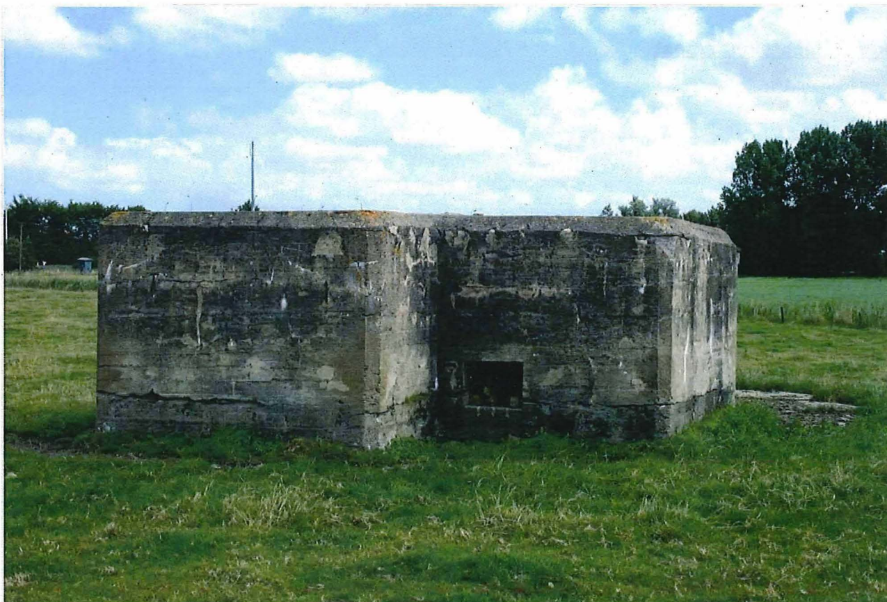
Foto 6: Detail van de westelijke zijde, met opening afgesloten met traliewerk.
