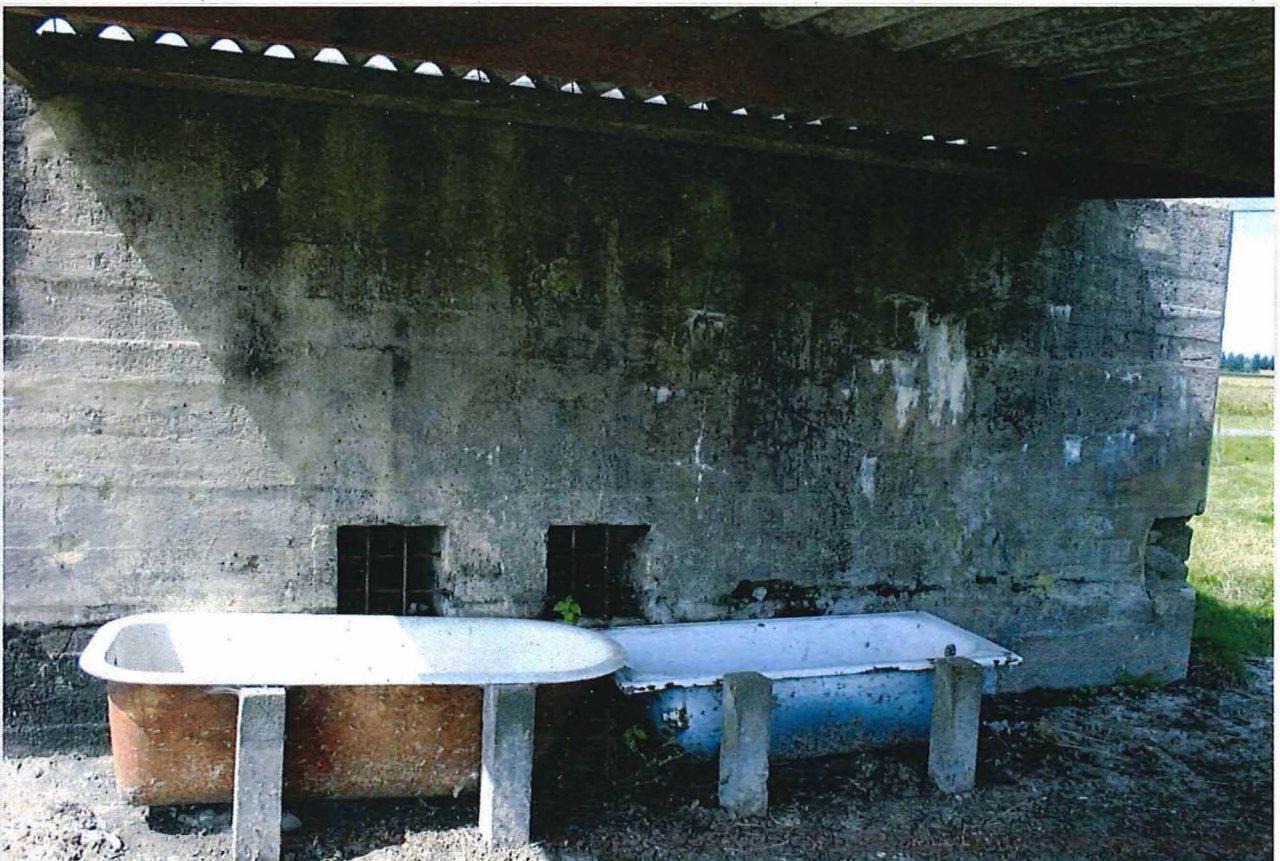
Foto 8: Twee met traliewerk afgesloten openingen in de oostelijke muur.
