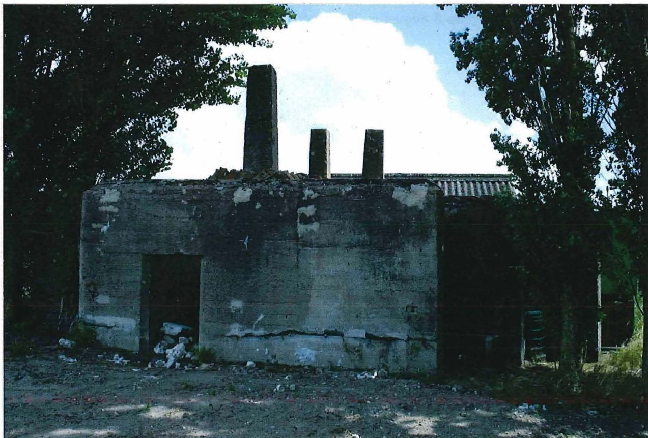
Foto 2: Zicht op de commandopost vanaf westelijke zijde. De drie schoorstenen op het dak zijn zichtbaar.
