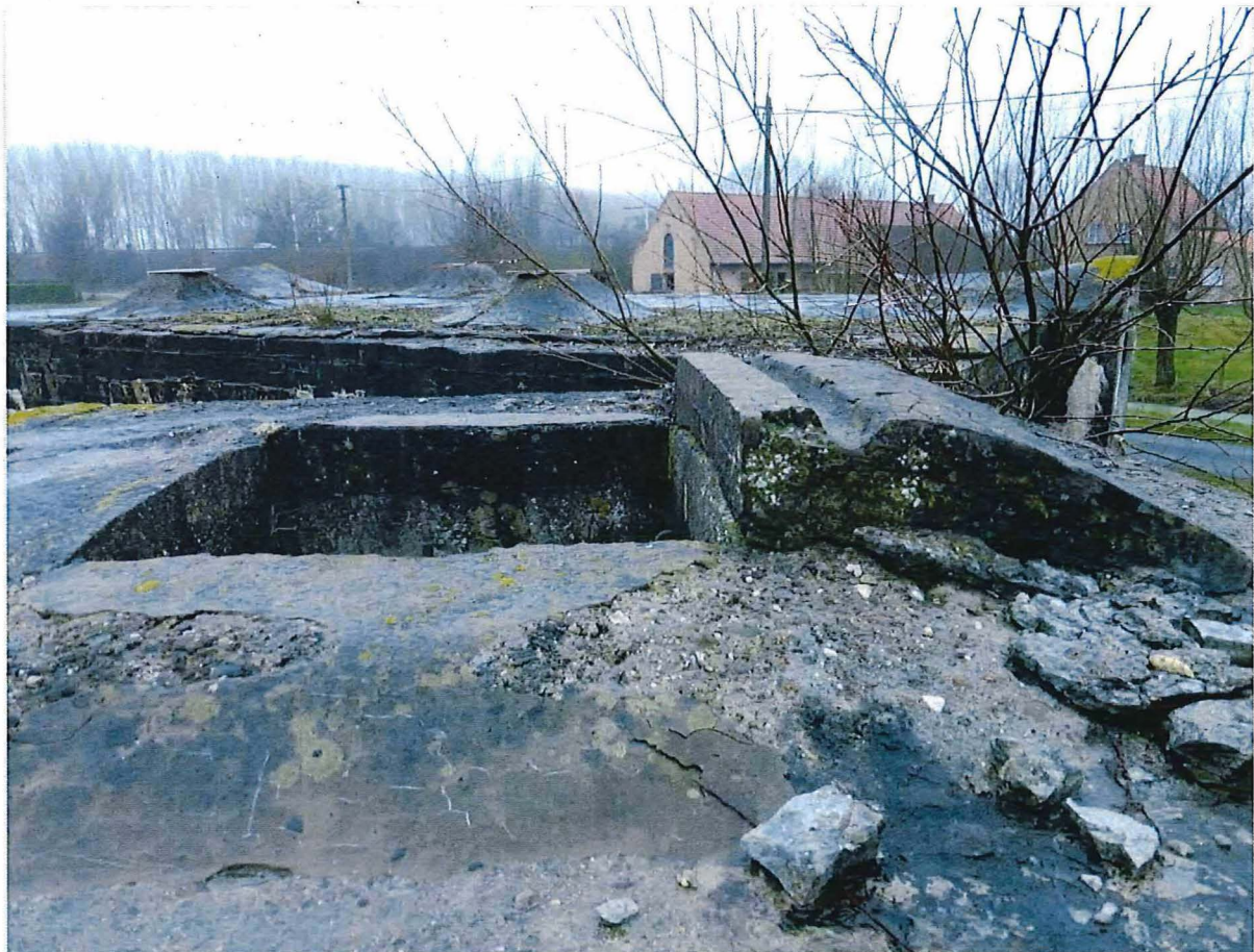
Foto 10: De betonnen rand rond het vierkante mangat van de observatiepost is wellicht maar ten dele bewaard. Op de achtergrond zijn de vier uitstulpingen op het dak van de bunker te zien.
