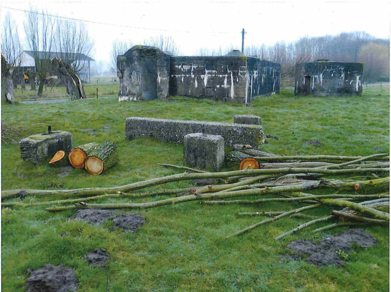
Foto 3: Stützpunkt Mauritz vanuit zuidoostelijke richting, met de betonnen gevechtsstelling op de voorgrond.
