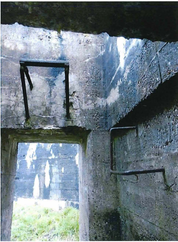
Foto 8: IJzeren elementen in de artillerie-observatiepost.
