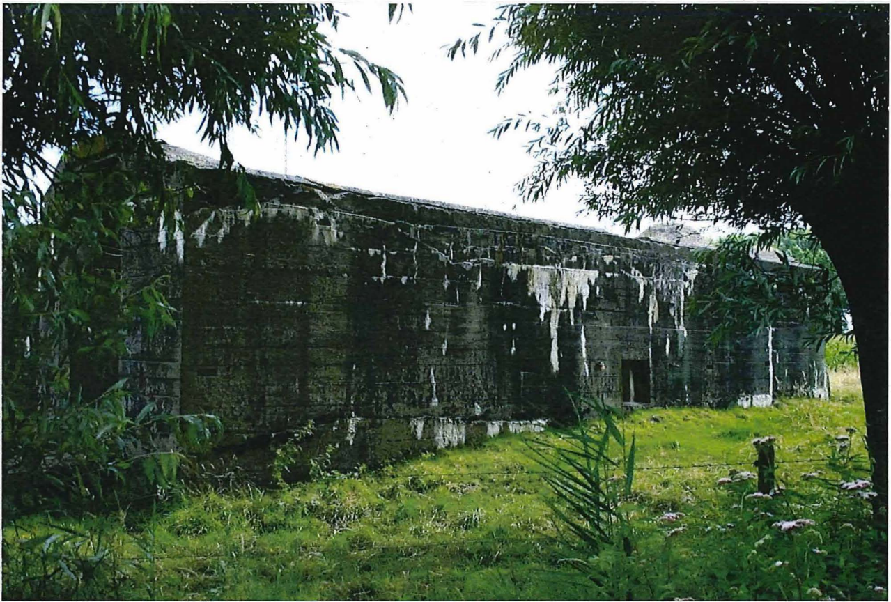
Foto 5: De westelijke zijde van de bunker, met opening.
