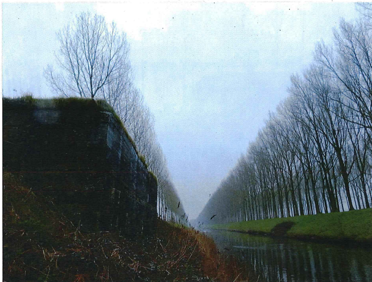
Foto 11: Zicht op de bunker, kant Leopoldkanaal.
