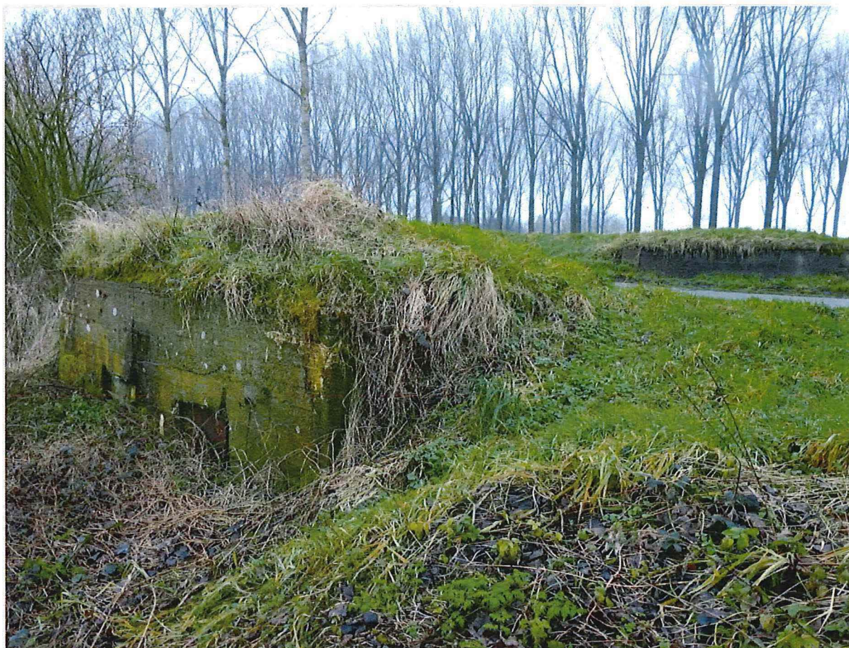
Foto 13: De observatiepost tegenover de flankerende bunker.
