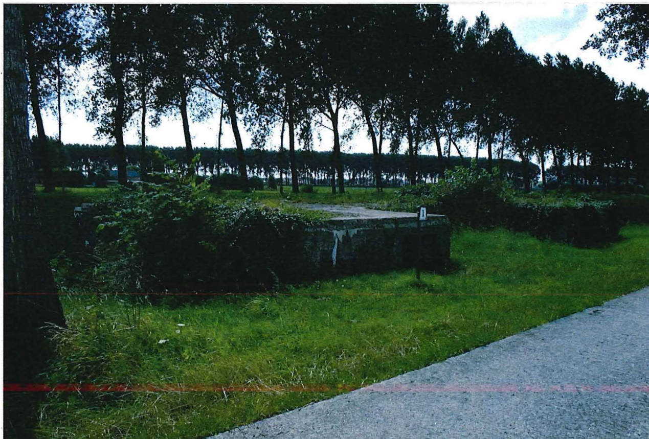
Foto 2: Zicht op de bunker vanaf de Vlotweg.
