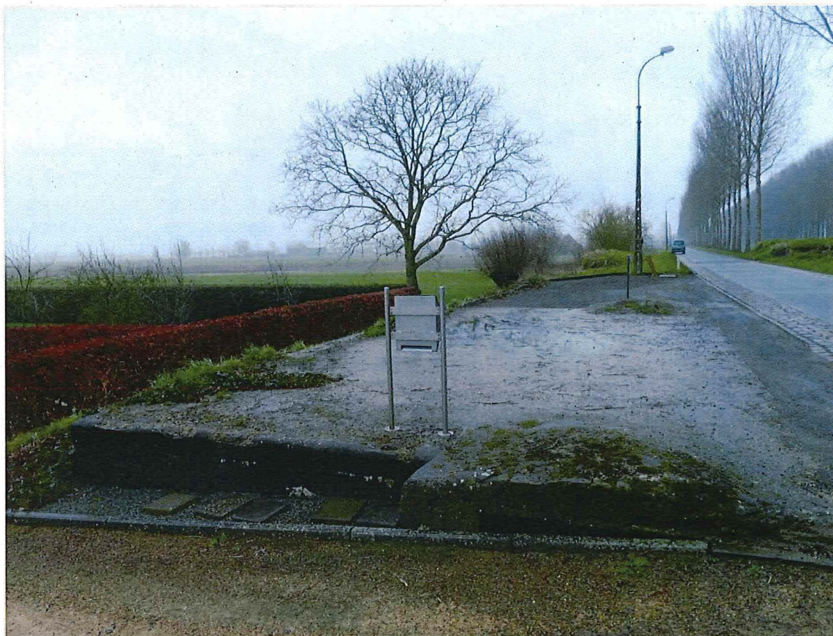
Foto 17: Manschappenonderkomen ter hoogte van Dijkstraat 33.
