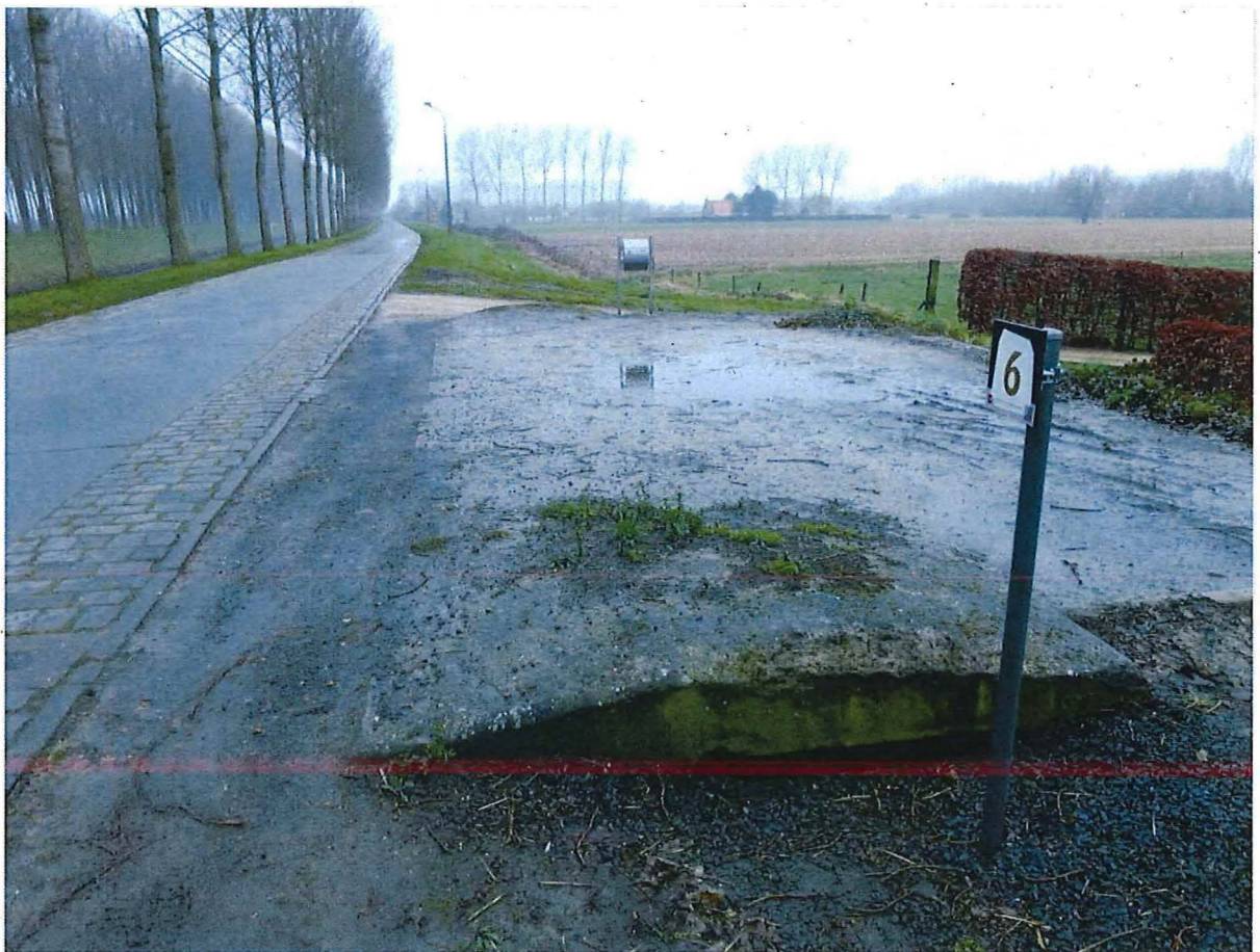
Foto 16: Manschappenonderkomen ter hoogte van Dijkstraat 33.
