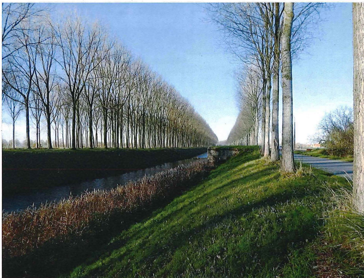
Foto 9: De flankerende bunker langs het Leopoldkanaal, ter hoogte van Dijkstraat 33.
