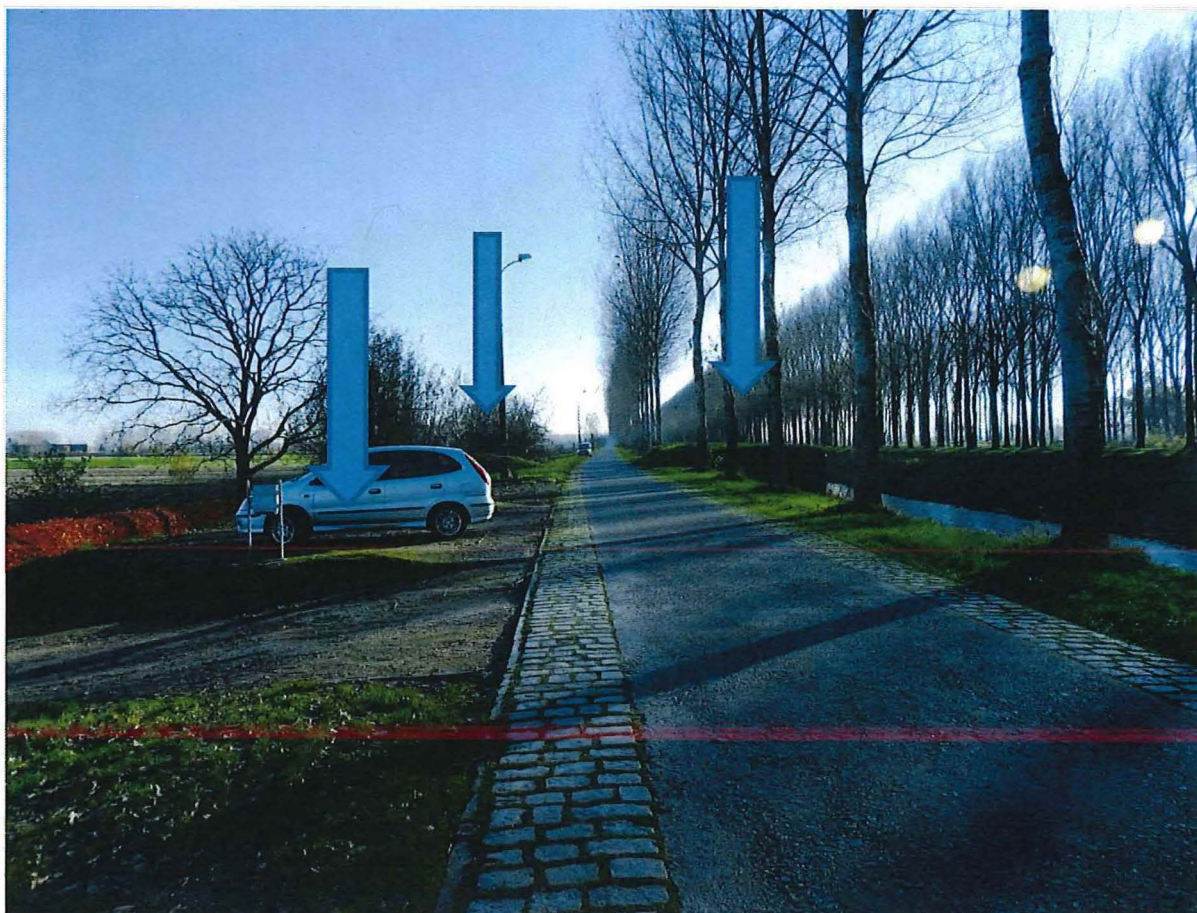
Foto 8: Ligging van de drie bunkers ter hoogte van Dijkstraat 33. Rechts aan de waterkant de flankerende mitrailleurspost, aan de andere kant van de dijk de observatiepost en links vooraan de kleinere bunker.
