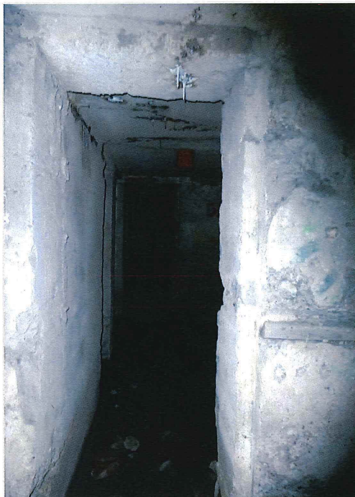
Foto 5: Zicht in de bunker
