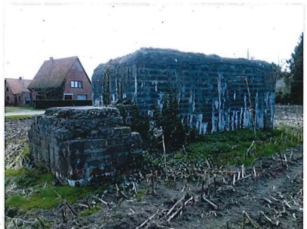
Foto 72: Bunker 20: vanuit noordwestelijke zijde, met zicht op de borstwering
