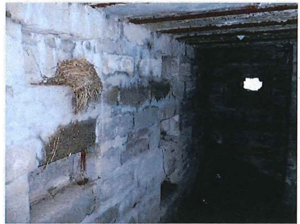
Foto 26: Bunker 6: binnenruimte met nissen en uitsprong met muuropening aan noordelijke zijde
