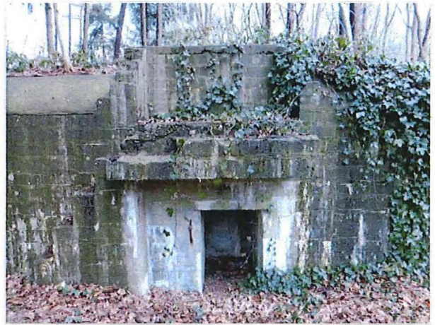
Foto 2: Bunker 1: luifel, borstwering, betonnen trap
