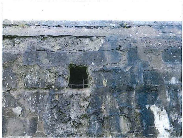
Foto 16: Bunker 4: muuropening met ijzeren rooster afgesloten
