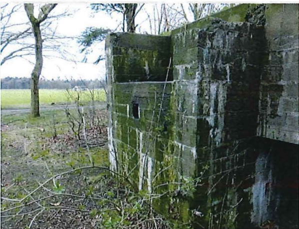
Foto 35: Bunker 8: uitspringend platform aan zuidoostelijke zijde
