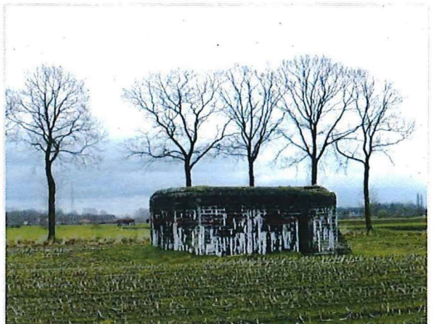
Foto 24: Bunker 6: westelijke zijde
