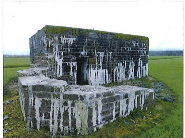
Foto 10: Bunker 3: noordwestelijke borstwering
