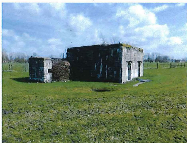
Foto 53: Bunker 15: zicht vanuit noordwestelijke hoek
