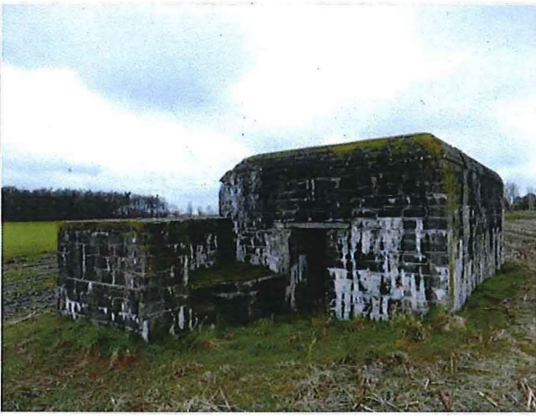
Foto 19: Bunker 5: zuidelijke zijde met borstwering
