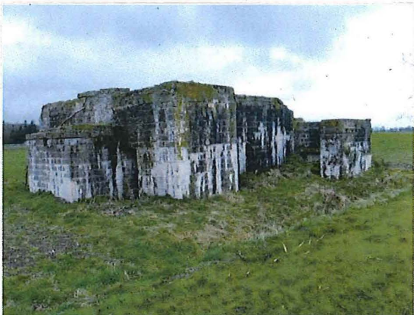
Foto 27: Bunker 7: zicht op de bunker vanuit zuidoostelijke hoek
