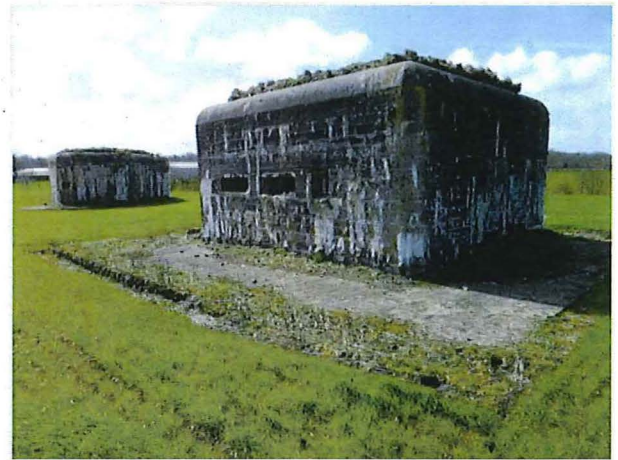
Foto 62: Bunker 17: zicht vanuit noordoostelijke hoek. Bunker 18 is te zien in de achtergrond
