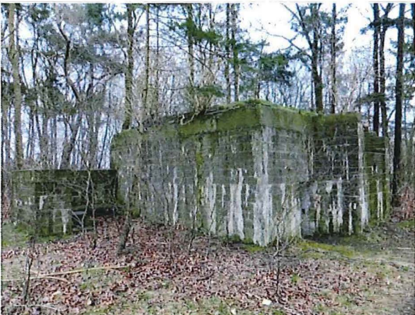
Foto 33: Bunker 8: vanuit zuidwestelijke hoek
