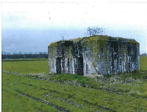
Foto 41: Bunker 10: vanuit zuidoostelijke hoek
