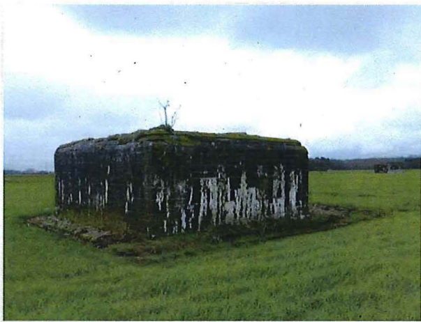
Foto 13: Bunker 4: noordelijke en westelijke zijde
