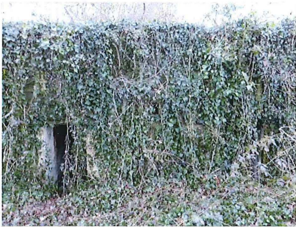
Foto 37: Bunker 9: achterzijde van de bunker
