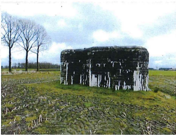
Foto 25: Bunker 6: noordelijke zijde met muuropening in vooruitspringend deel
