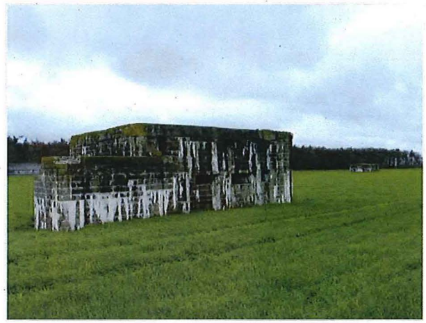
Foto 8: Bunker 3: oostelijke zijde met drie openingen
