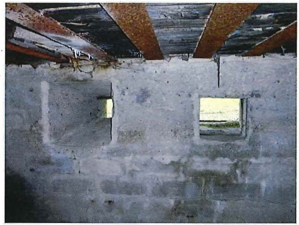
Foto 20: Bunker 5: schietopening en opening voor handzoeklicht aan westelijke zijde.
