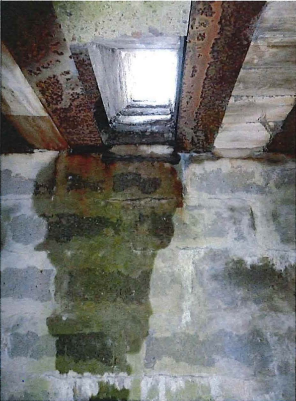
Foto 21: Bunker 5: opening voor seinlamp aan oostelijke zijde
