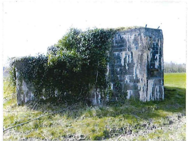
Foto 50: Bunker 14: zicht op de bunker vanuit noordoostelijke hoek
