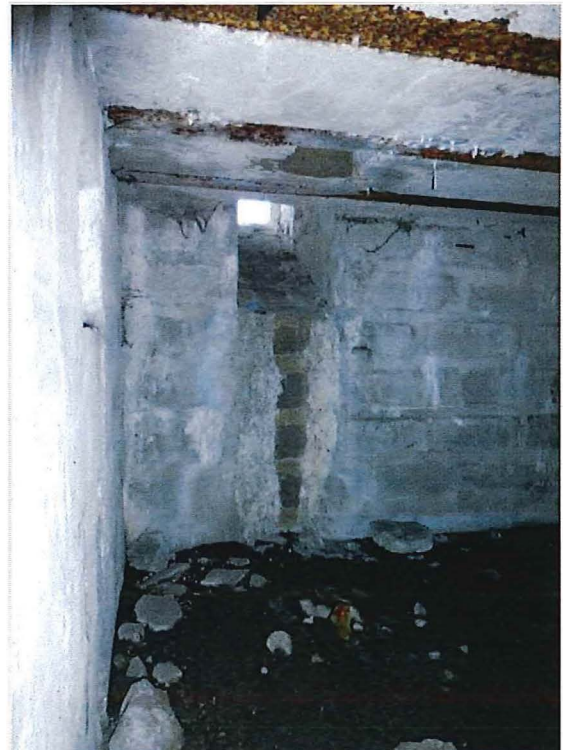
Foto 60: Bunker 16: schuin naar boven lopende opening en vierkante opening in plafond
