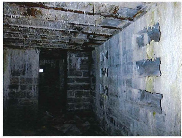
Foto 56: Bunker 15: binnenruimte, met voorkamer
