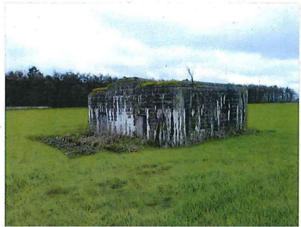
Foto 14: Bunker 4: zuidelijke en oostelijke zijde
