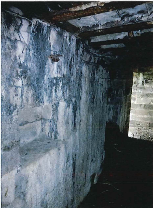
Foto 11: Bunker 3: gang met nissen en ijzeren haken
