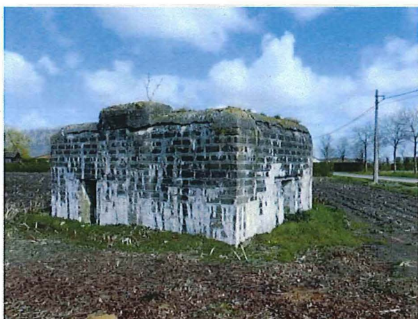
Foto 71: Bunker 20: vanaf zuidwestelijke zijde
