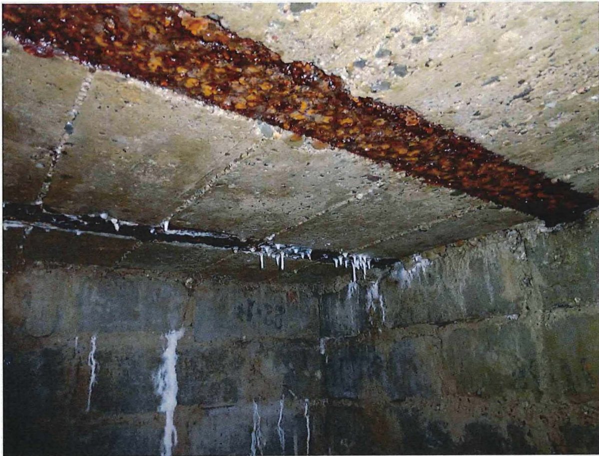
Foto 3: Bunker 1: het plafond is gegoten en versterkt met ijzeren balken.
