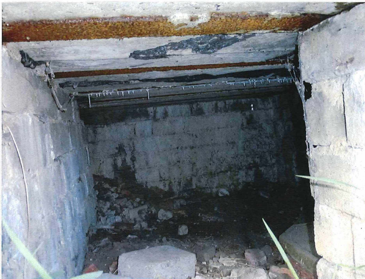
Foto 7: Bunker 2: zicht in de betonnen post. Tegen het plafond, dat versterkt is met ijzeren profielen, zitten sporen van teerpapier.
