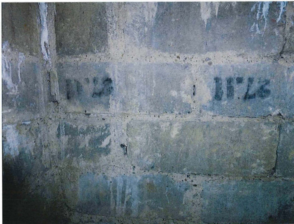
Foto 4: Bunker 1: enkele betonstenen zijn genummerd.
