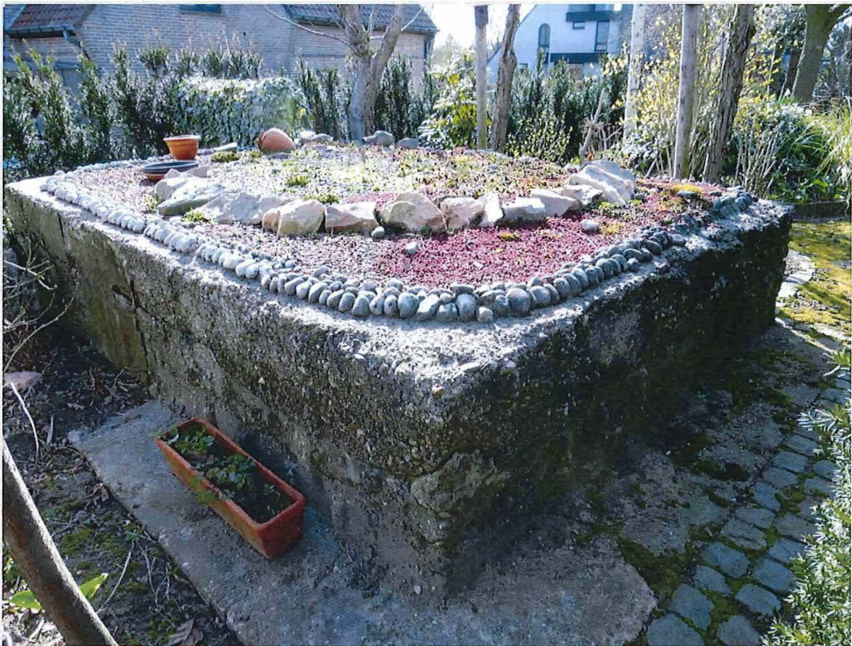
Foto 1: Bunker 1: de uitstekende muren vormden een platform, waardoor het dak als borstwering gebruikt kon worden.
