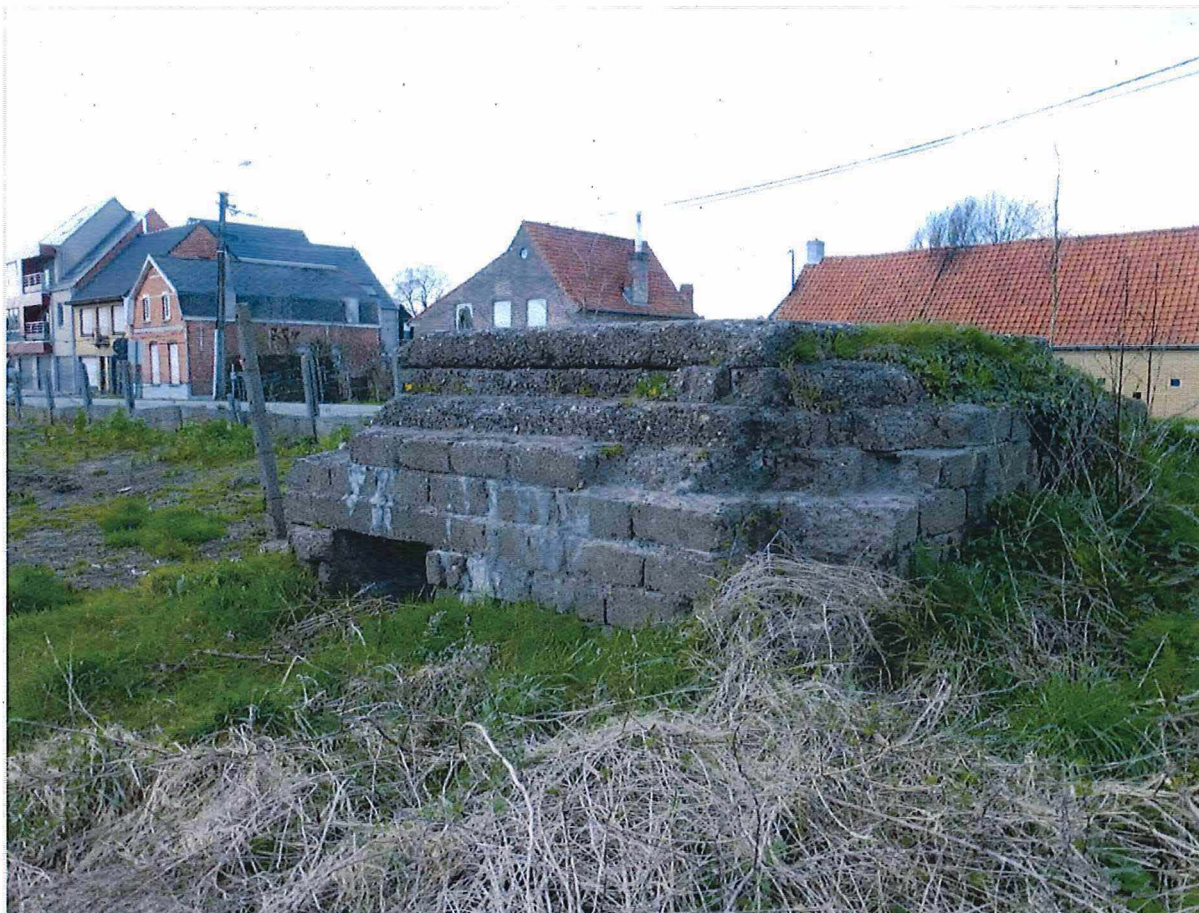
Foto 5: Bunker 2, gelegen langs de Groenendijk.
