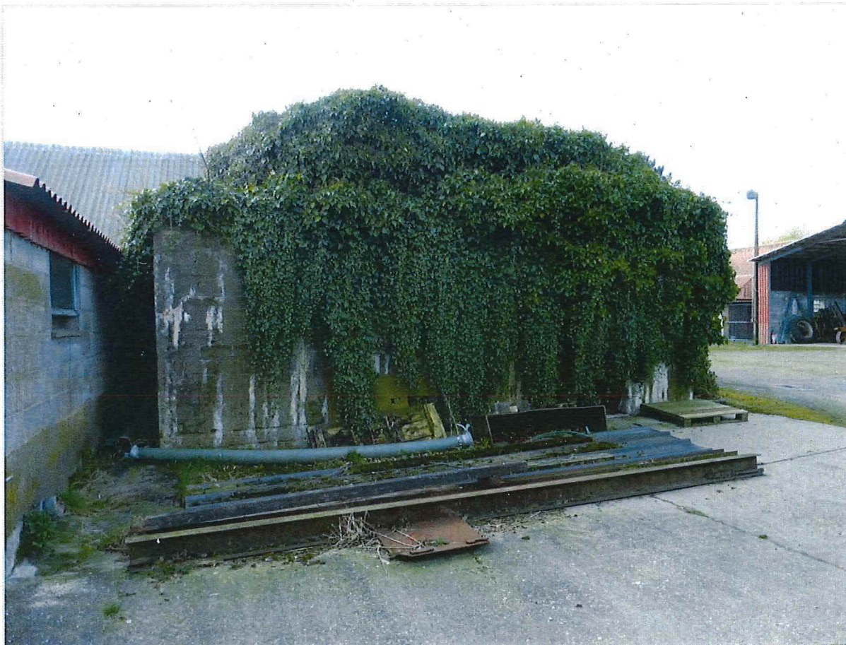
Foto 1: Bunker 1: zicht op westelijke zijde.
