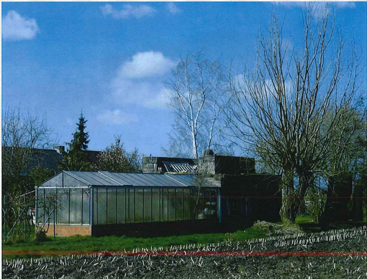
Foto 14: Bunker 4: zicht op zuidelijke en oostelijke zijde.
