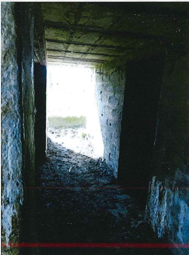
Foto 8: Bunker 2: de L-vormige gang.
