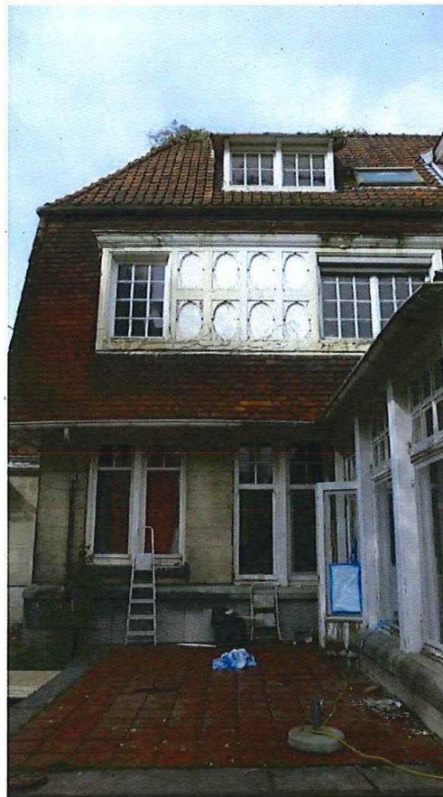
Foto 32: zuidelijk volume 'oostgevel en aansluiting op middenvolume.
