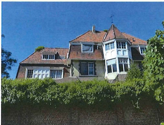
Foto 2: zuidelijk deel van de oostgevel.
