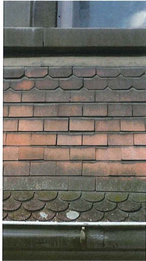
Foto 28: detail afwerking kleine tussendaken (hier links van toreuitbouw).
