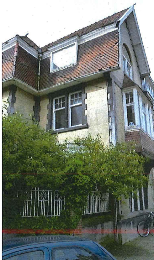
Foto 21: noordoosthoek woning met tuinmuur en hekwerk.
