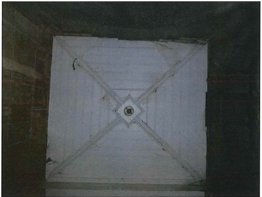
Foto 24: houten plafond ingangsportiek
