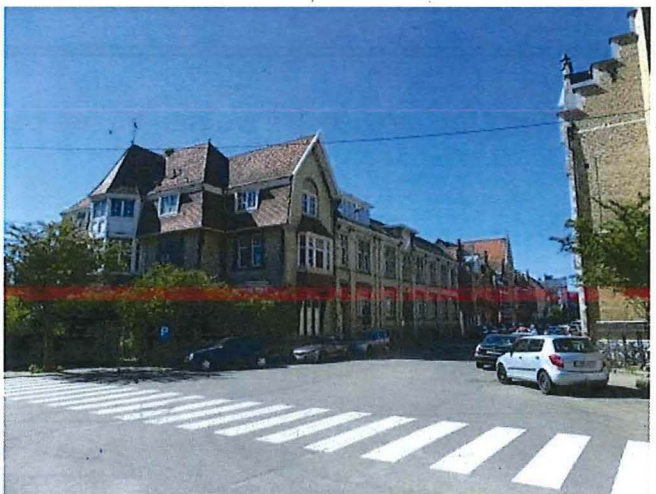
Foto 5: de noordelijke gevel en de huizenrij in de Sint-Amamndstraat
