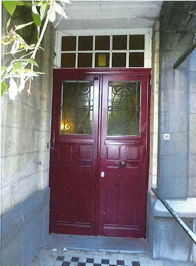
Foto 27: detail oorspronkelijk schrijnwerk, inkomdeur.
