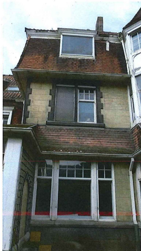
Foto 30: gevelveld links van toreuitbouw.
