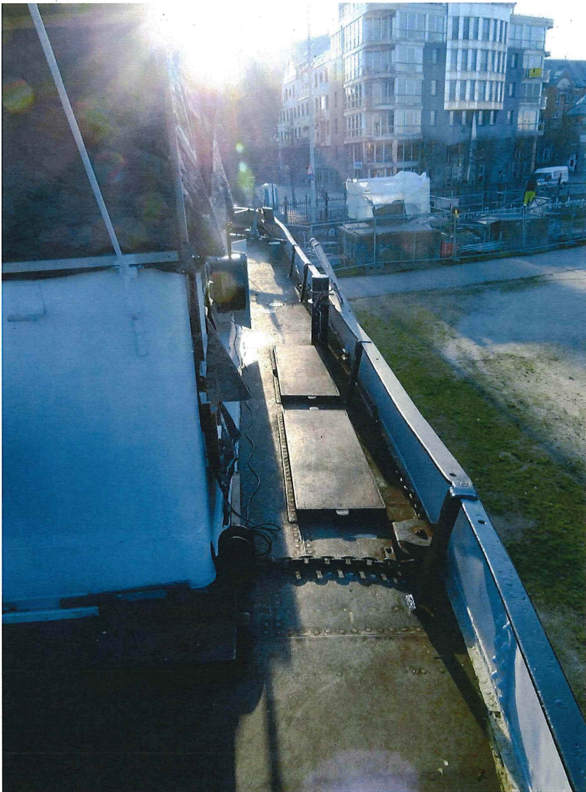
Foto 17: Gangboord aan bakboordzijde.
