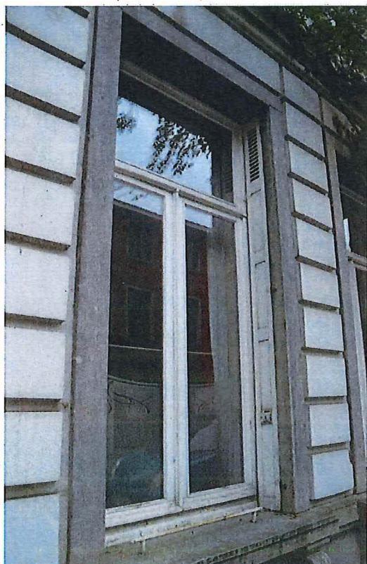
Foto 5: Voorgevel, detail schrijnwerk en inklapbare buitenluiken (30/08/2017).
