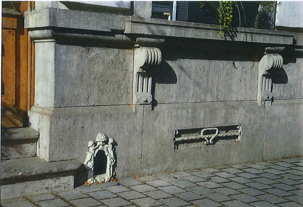
Foto 7: Voorgevel, detail van plint in blauwe hardsteen met smeedijzeren voetenschraaper en ornament (13/09/2017).
