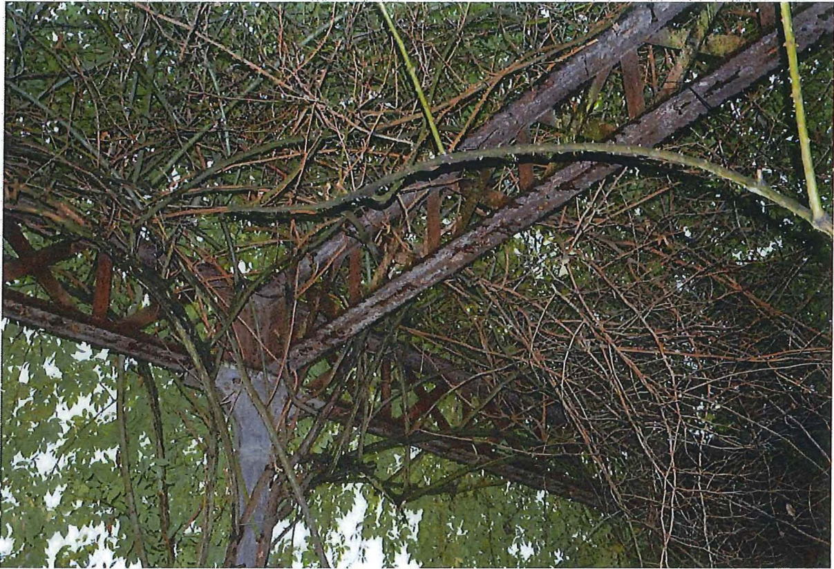
Foto 17: Metalen draagstructuur, detail van verbinding tussen kolom en liggers (30/08/2017).
