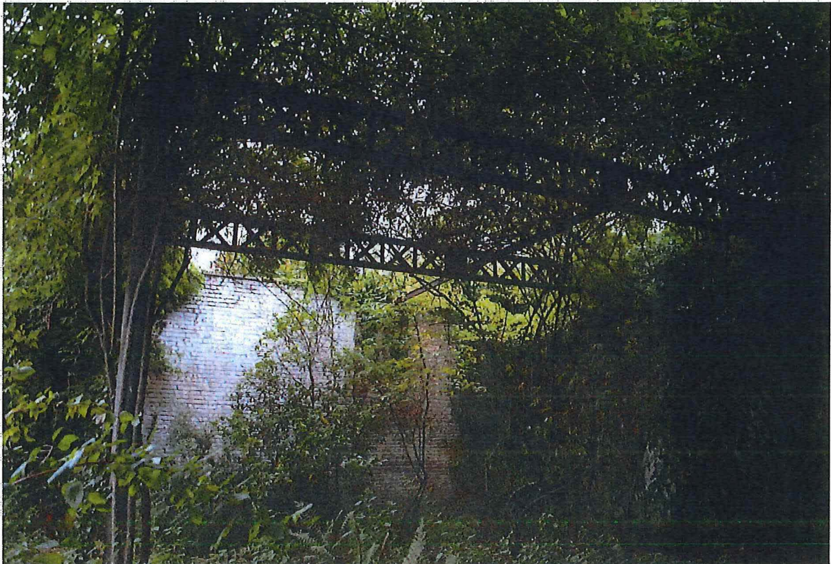
Foto 16: Restanten van het voormalige depot, gelegen achteraan het perceel (30/08/2017).
