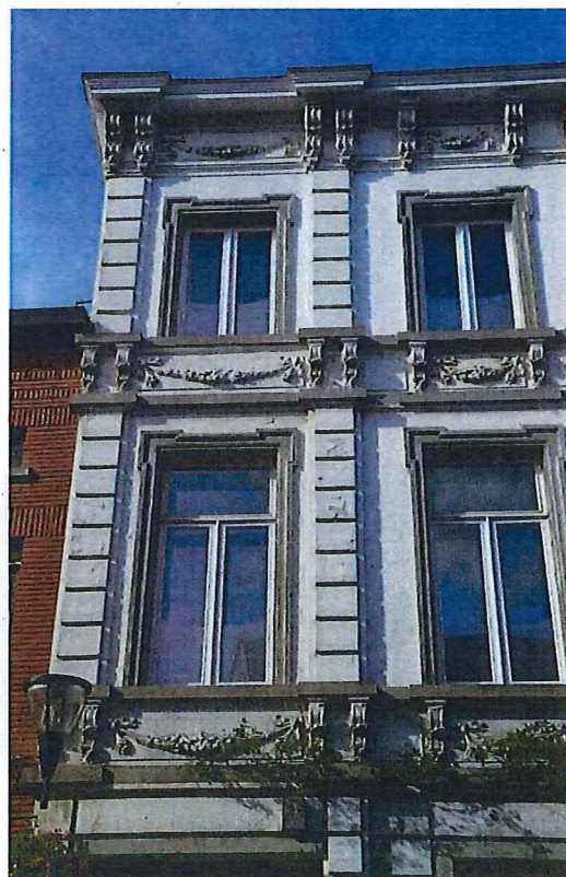
Foto 6: Voorgevel, detail gevelornamentiek en -beploistering ter hoogte van de poorttravee (13/09/2017).
