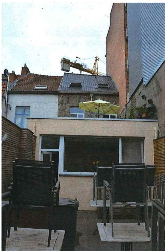
Foto 18: Achtergevel, met aanbouw uit 2008.
