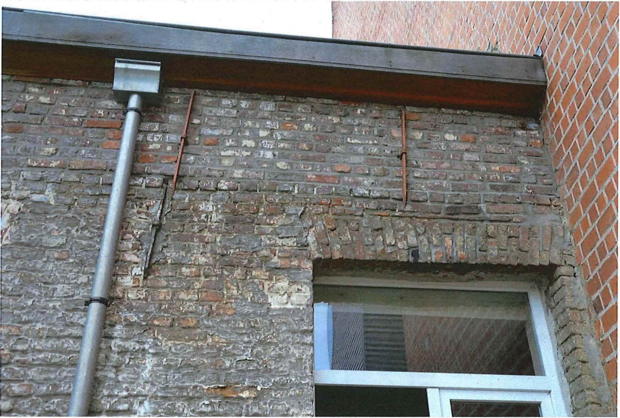
Foto 20: Achtergevel, noordzijde. Detail bouwsporen van verhoging gevel.
