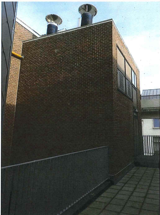
Foto 11: westelijk hoger bouwvolume
