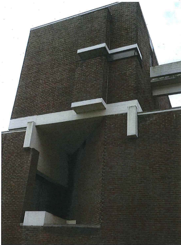
Foto 7: noordgevel Volmolenstraat met oostelijk hoger bouwvolume
