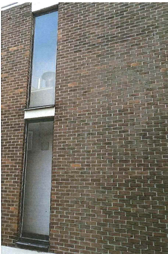
Foto 13: ramen in wetsgevel van oostelijk hoger bouwvolume
