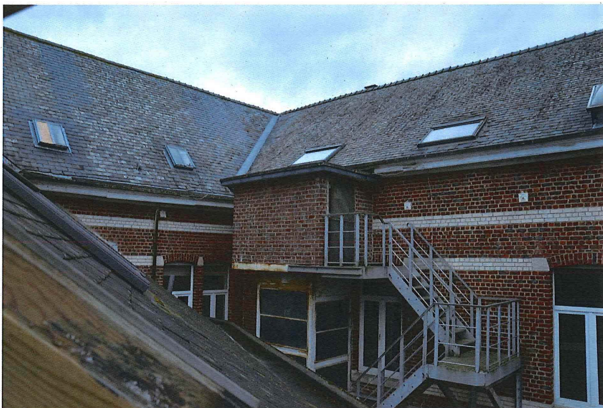
Foto 17: Zicht op de daken van het hoofdvolume en de haakse noordvleugel. Centraal de liftkoker en trap bovenop de lage bijgebouwen in de oksel van het bouwencomplex (24.01.2018).
