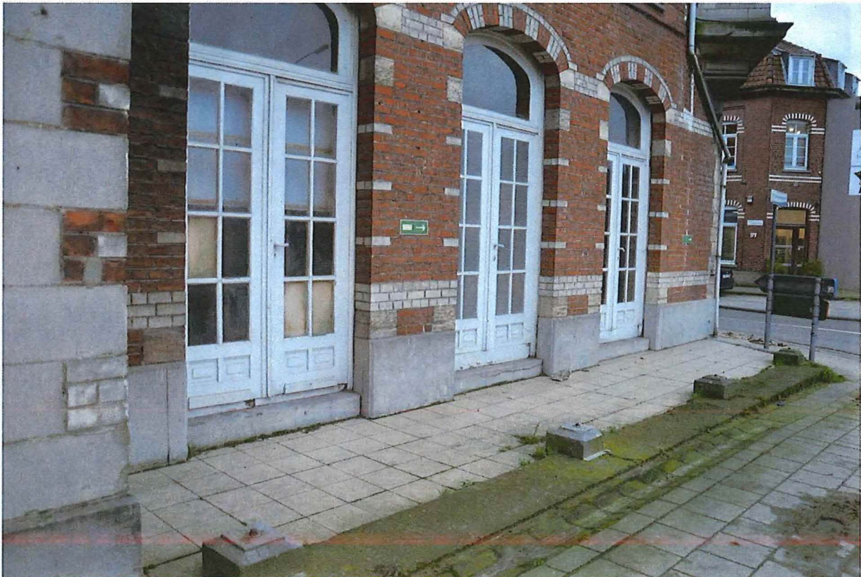
Foto 6: Hoofdvolume Sint-Jansbergdreef, vensterdeuren op de gelijkvloerse verdieping. De oorspronkelijke aflijning van de houten galerij en de natuurstenen basementen zijn nog bewaard (24.01.2018).
