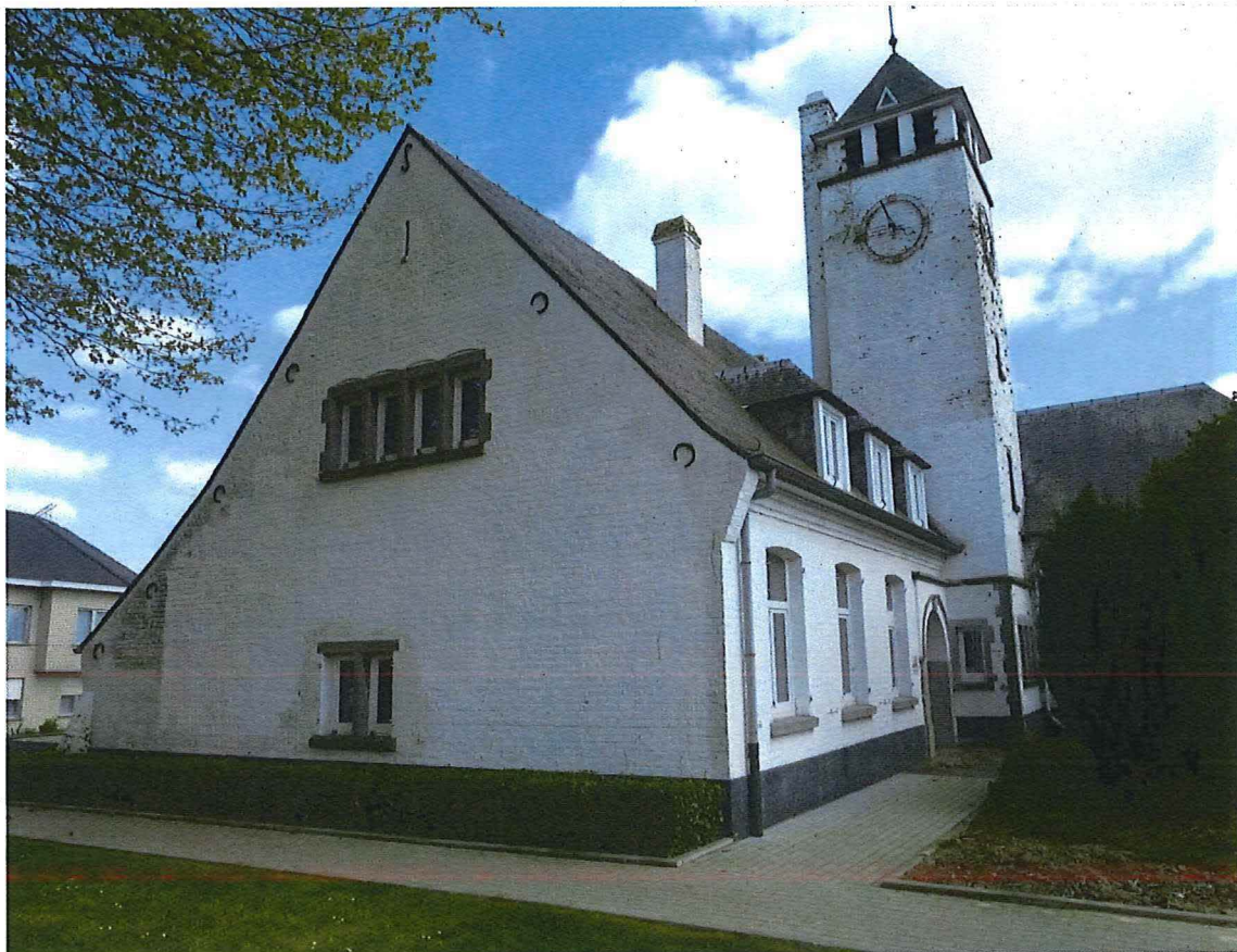
4. gemeentehuis van Vlezenbeek, noordwest gevel, 19/05/2017
