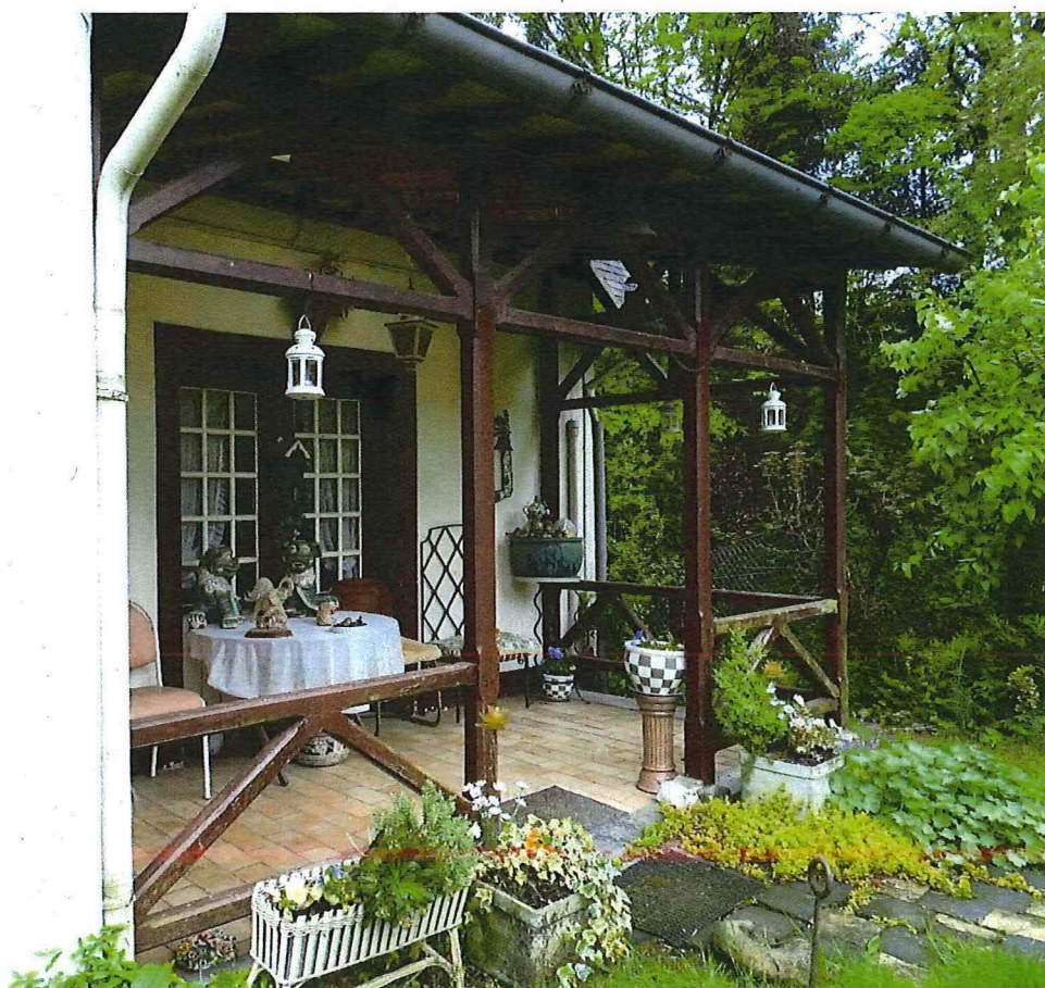
Foto 14: Overdekt terras aan noordoostelijke voorgevel (19/09/2018).
