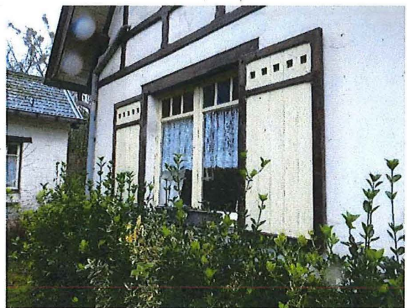
Foto 17: Zuidoostelijke zijgevel. Detail van het keukenraam met buitenluiken (4/01/2018).
