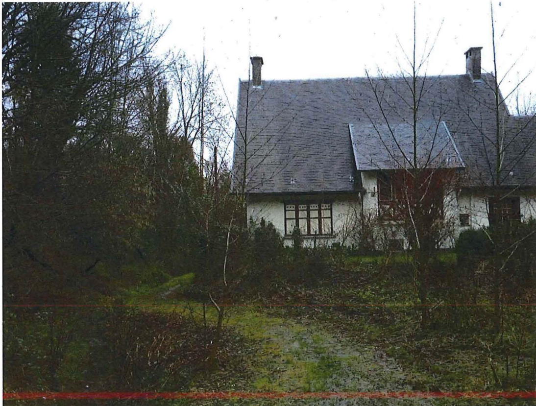
Foto 3: Villa Herman Teirlinck. Zicht vanuit het zuidwesten op de achtergevel. Langsheen de woning loopt het Koekoekpad aan noordwestelijk zijde (4/01/2018).
