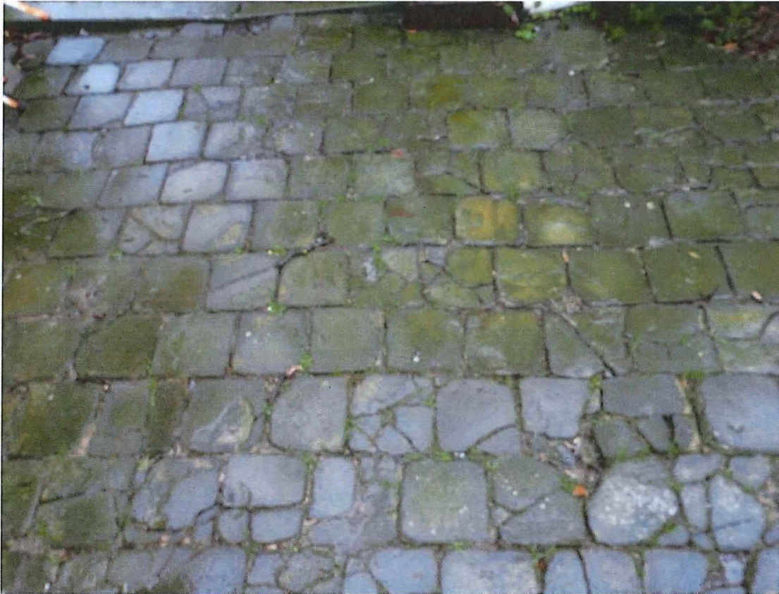
Foto 24: Gekasseide verharding in blauwgrijze natuursteen ter hoogte van de achtergevel tussen de achterdeur en het tuinhuis (4/01/2018).
