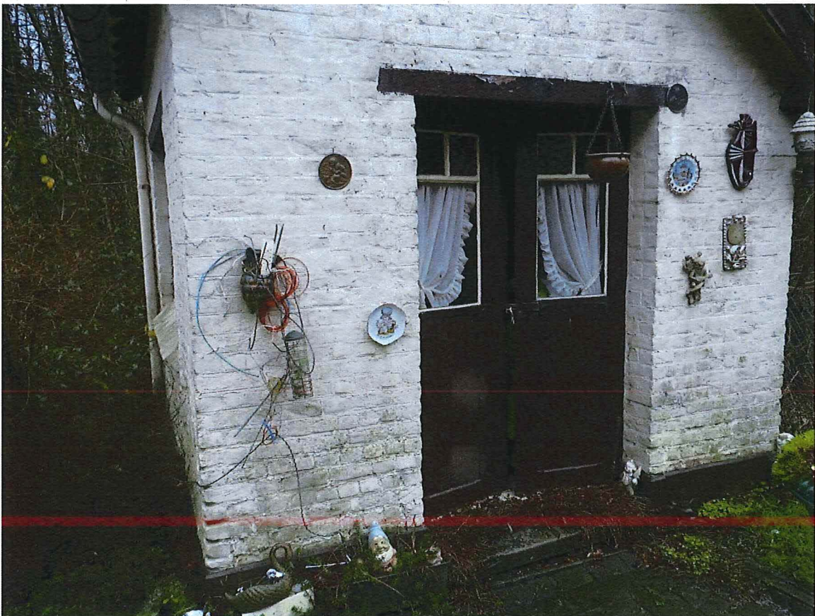
Foto 26: Detail tuinhuis Villa Teirlinck. Dubbele beglaasde paneeldeur met bovenlichten (4/01/2018).
