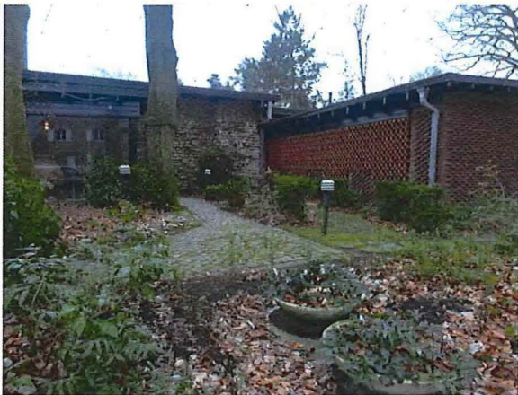
Foto 8: Voortuinaanleg en gekasseid toegangspad tot de voordeur.
