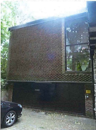
Foto 5: Noordgevel van de oostelijke vleugel.
