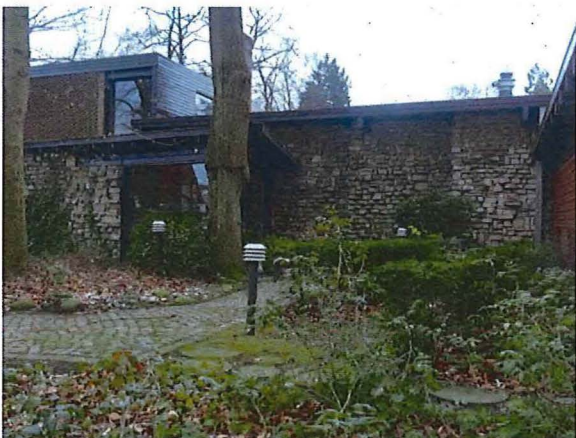
Foto 10: Voortuinaanleg met wandelpad in betontegels.
