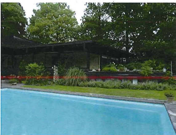
Foto 20: Tuinzijde van de oostelijke vleugel.
