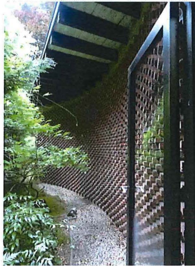
Foto 17: Gebogen westgevel ter hoogte van de eetplaats.
