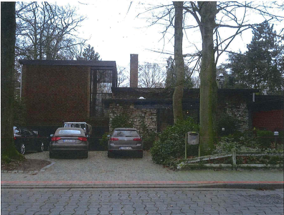
Foto 4: Voorgevel, zicht vanuit het noorden.
