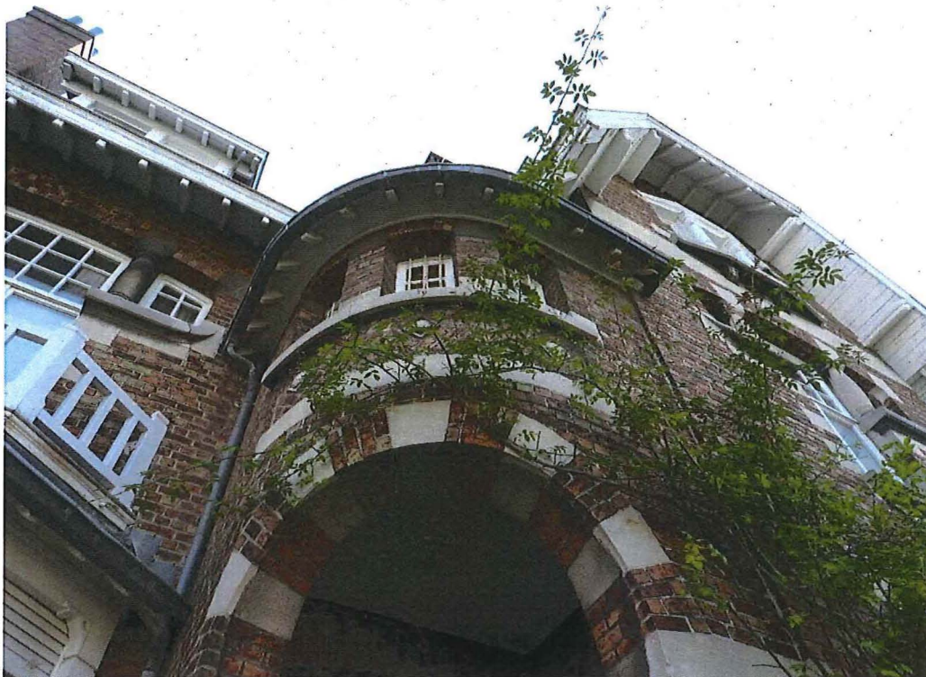
Foto 8: Halfrond hoekportaal met geblokte rondboog en metselmozaïek met natuurstenen diamantkoppen (28/08/2017).
