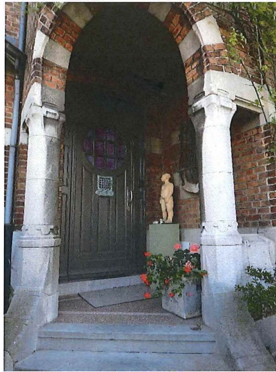
Foto 6: Halfrond inkomportaal met natuurstenen zuiltjes op octagonale sokkels (28/08/2017).
