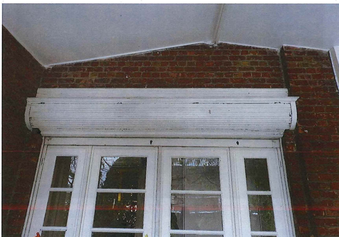
Foto 19: Beglaasde paneeldeur met zijlichten met rolluikkast in de middentravee van de achtergevel, gezien vanuit het overdekt terras (12/12/2017).
