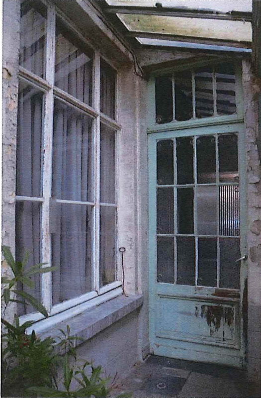
Foto 16: Achtergevel hoofdvolume, gelijkvloers. Detail negenvlakraam van het salon en deur naar de traphal.
