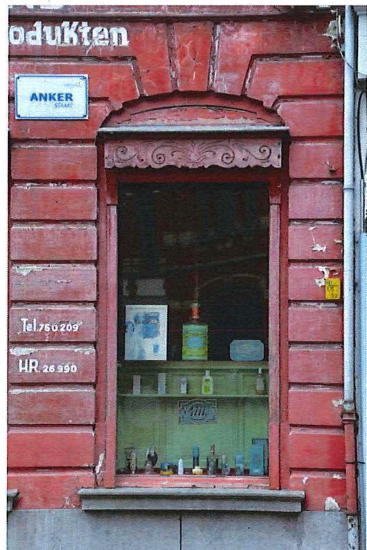
Foto 6: voorgevel, detail venster (4de travee) met rolluikkast.
