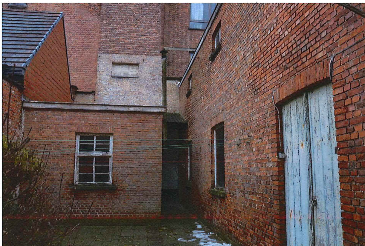
Foto 11: Exterieur achterzijde, algemeen zicht naar de zuidzijde.
