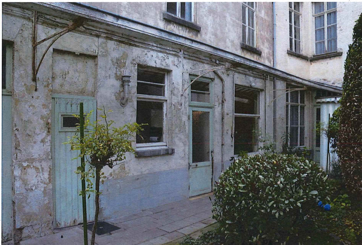
Foto 14: Achterbouw, gelijkvloers (plankendeur van het toilet; guillotineraam en deur van de keuken, groot guillotineraam van de eetkamer). Achtergevel hoofdvolume (negenvlakraam van het salon).
