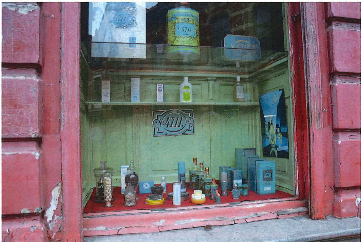
Foto 7: Voorgevel, detail venster (4de travee) met zicht op één van de vitrinekasten, identiek aan deze in het aanpalende venster (3de travee).
