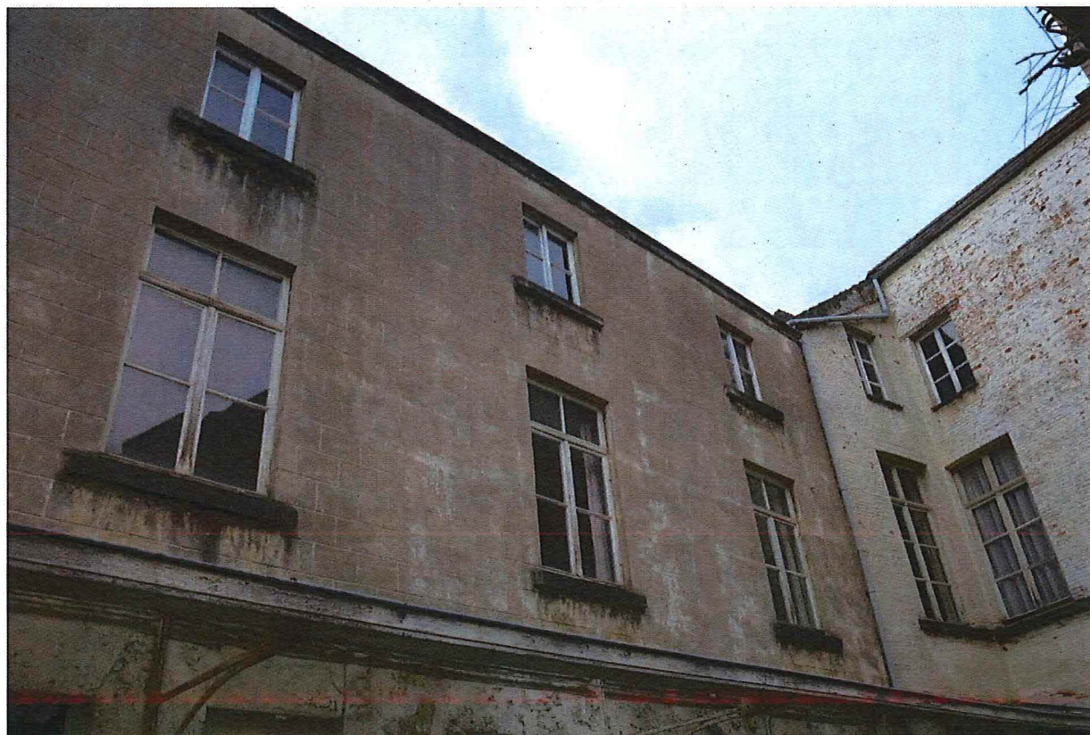
Foto 15: Zicht op de achtergevels van de achterbouw (gecementeerd) en het hoofdvolume (beschilderd).
