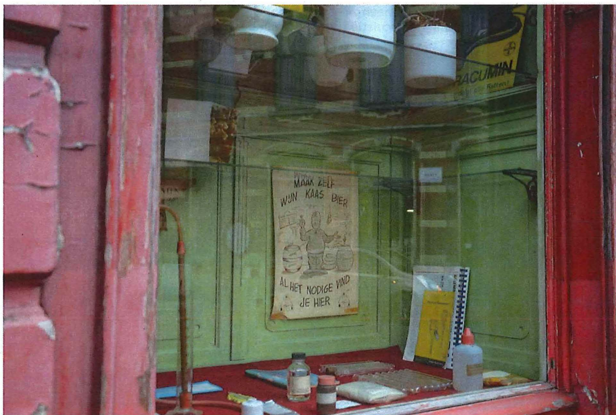
Foto 9: Voorgevel, detail venster (1ste travee). Zicht op de vitrinekast met een andere vormgeving dan de overige twee vitrinekasten (3de en 4de travee).
