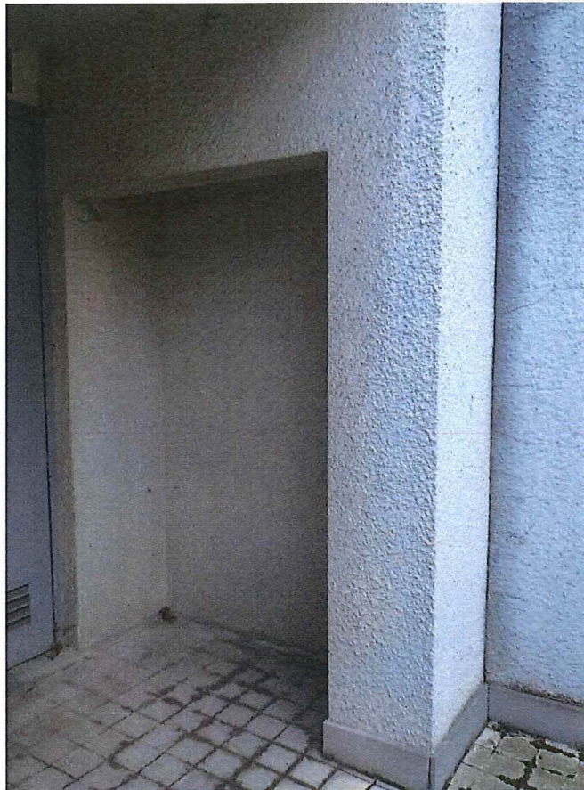
Foto 6 : nis, rechts van deur, begane grond
