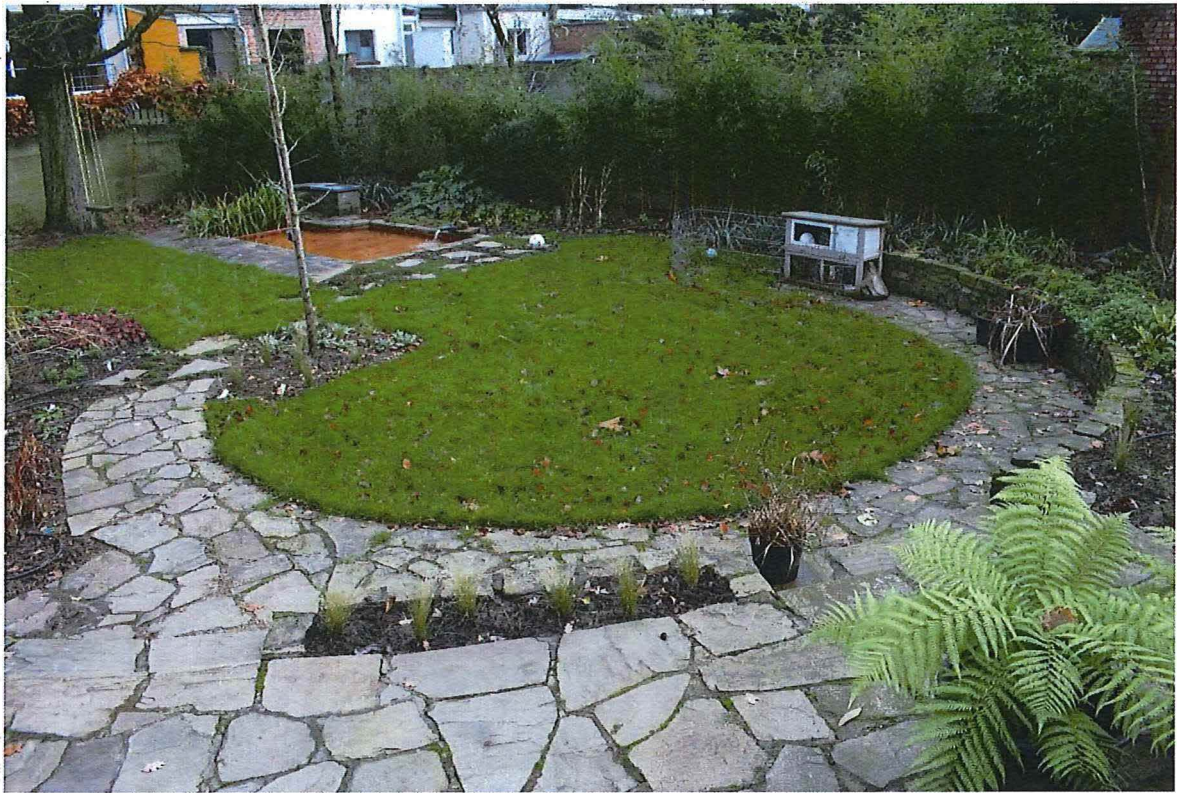
Foto 15: aanleg achtertuin met "flagstones"
