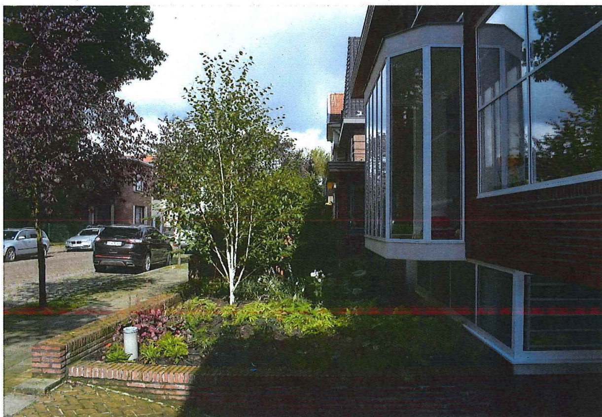
Foto 2: voorgevel met erkèr en vensterband
