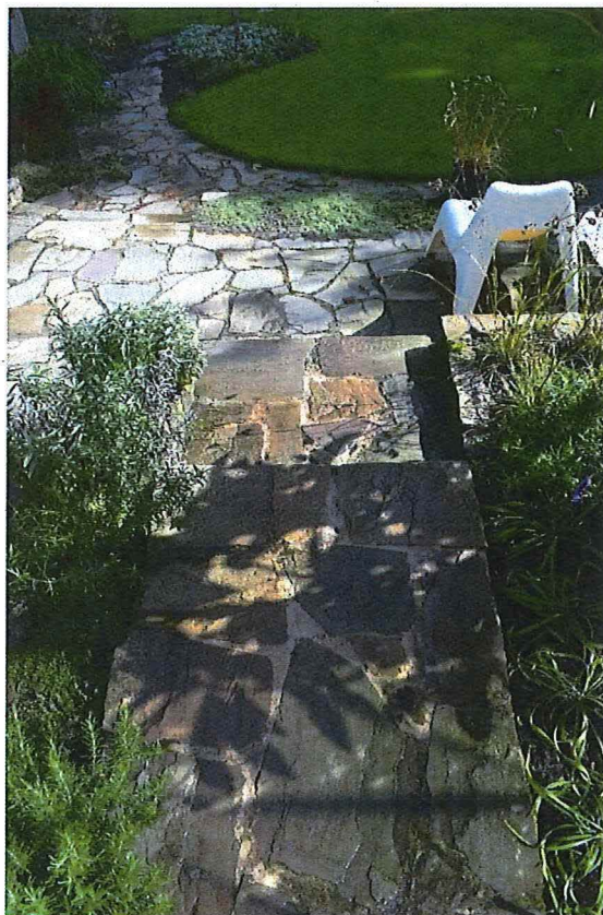
Foto 17: aanleg achtertuin met "flagstones"
