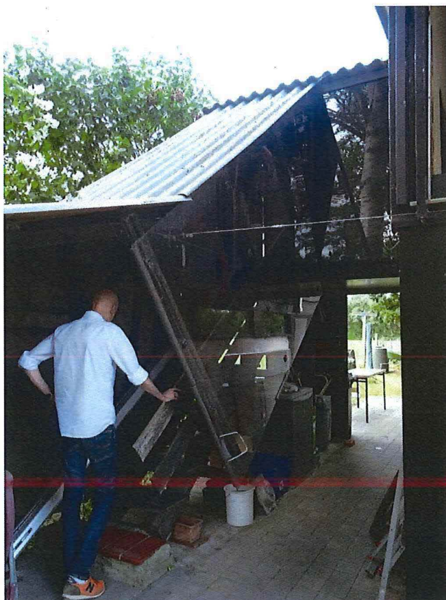
Foto 14: Buitentrap, links naast de zuidelijke gevel.
