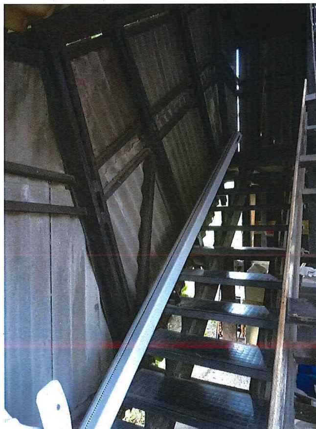
Foto 15: Buitentrap. Binnenzicht vanaf beneden.
