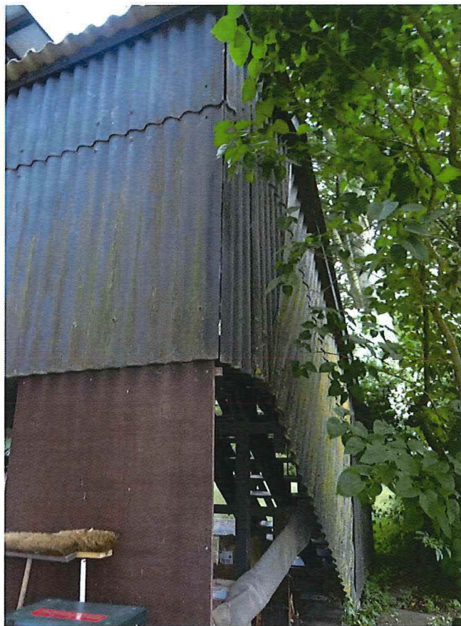
Foto 20: Achterzijde en zijkant buitentrap.
